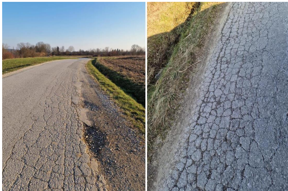
Slika 11. Puzanje bankine i procjeđivanje vode kroz bankinu
