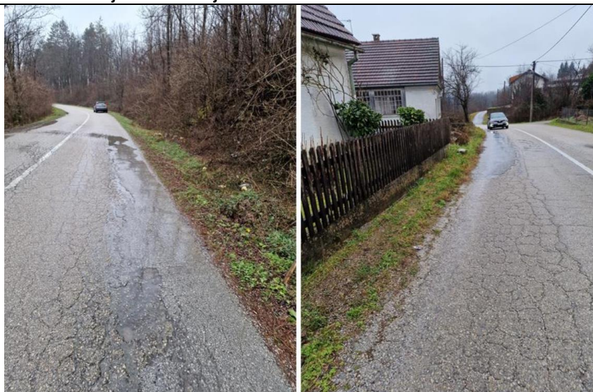
Slika 22. Županijska cesta ŽC 3176; Stacionaže: km 11+030 ÷ km 8+530
