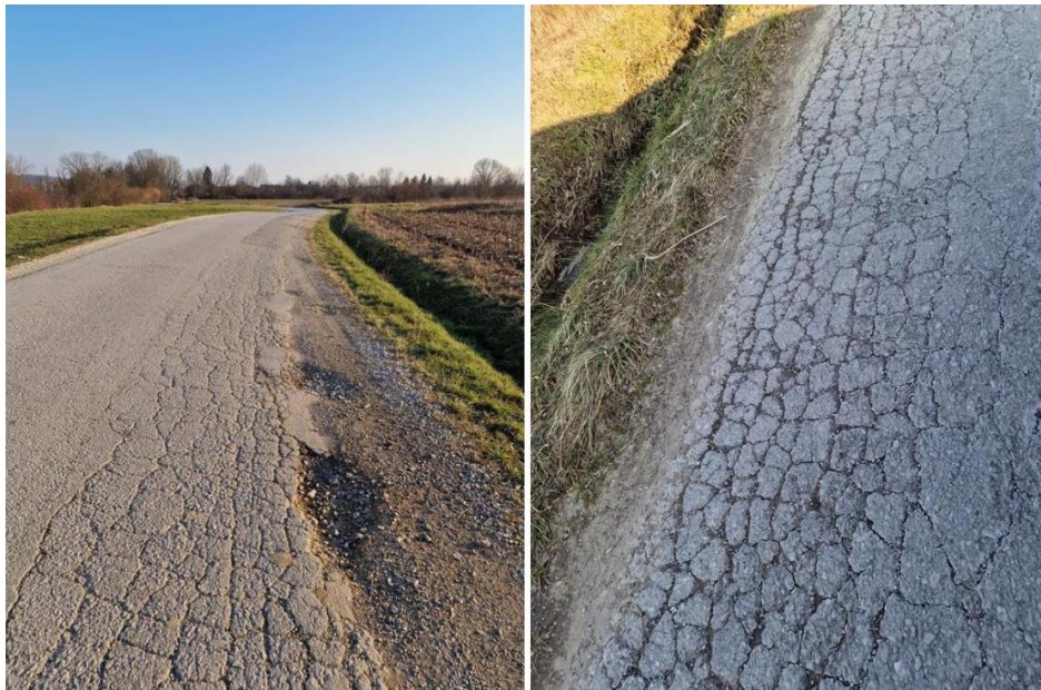
Slika 11. Puzanje bankine i procjeđivanje vode kroz bankinu
