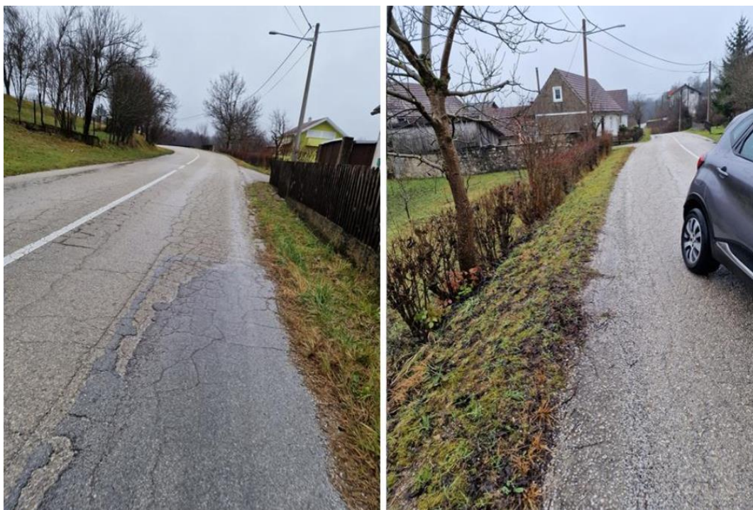
Slika 23. Puzanje bankine i procjeđivanje vode kroz bankinu
