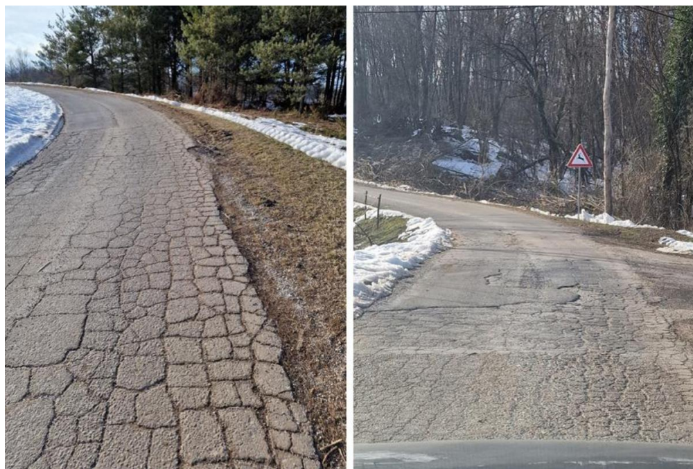
Slika 17. ŽC 3257; Stacionaže: km 0+000 ÷ km 1+100
