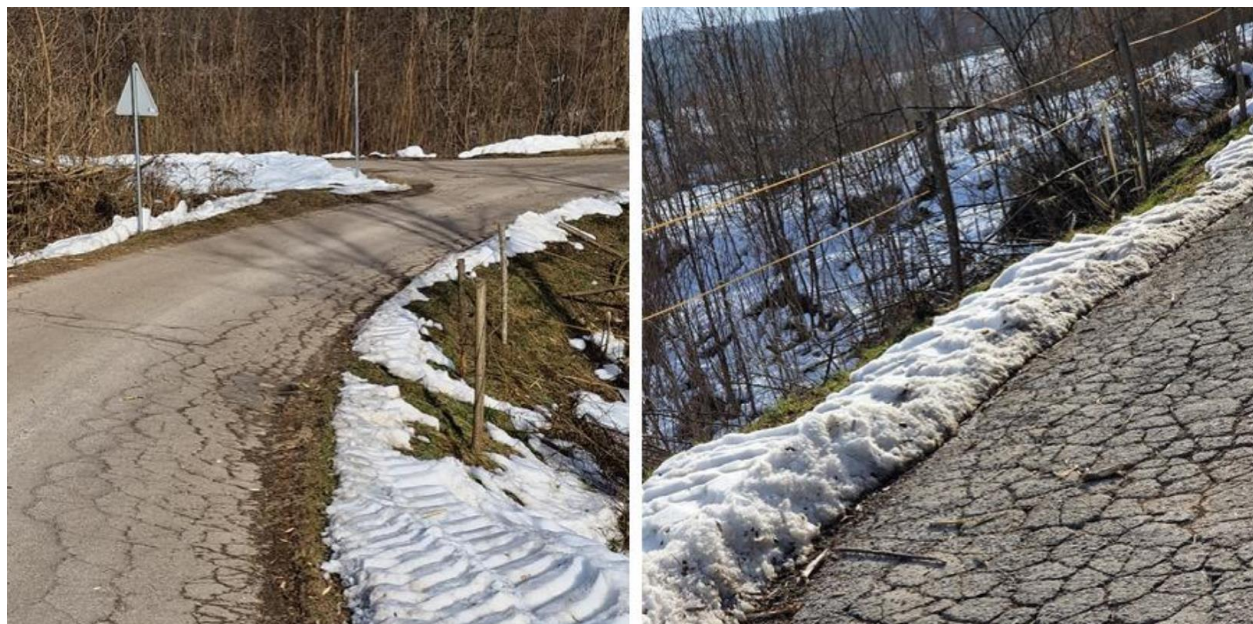
Slika 18. Puzanje bankine i procjeđivanje vode kroz bankinu
