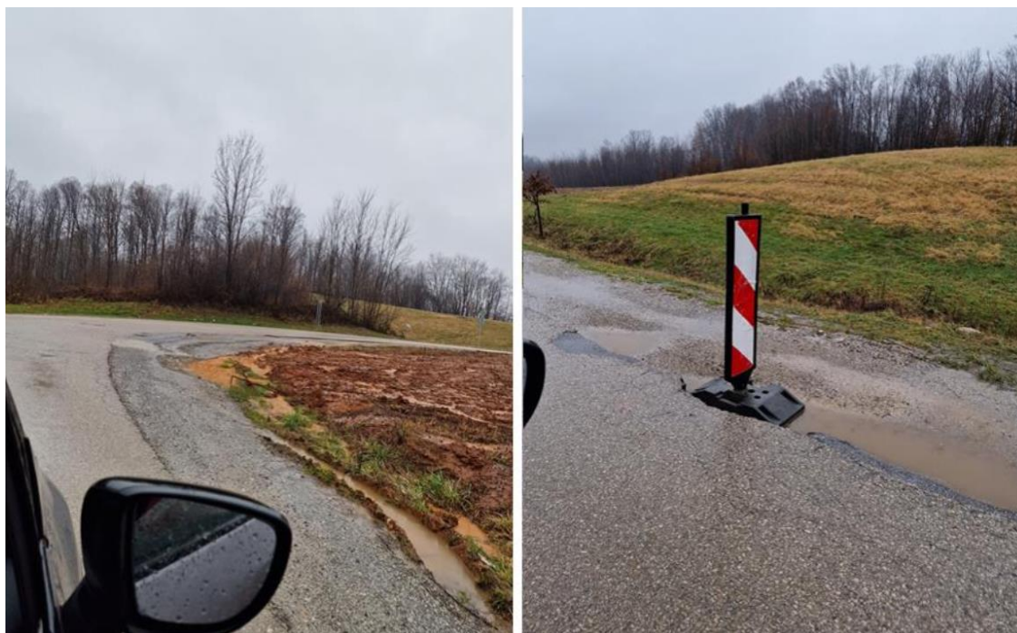
Slika 4. Lokalna cesta LC 34059; Stacionaže: km 0+230 ÷ km 1+610
