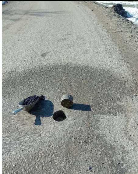
Slika 16. Obilazak županijske ceste ŽC 3257
