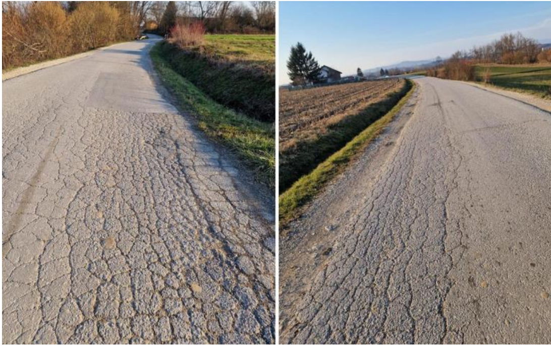
Slika 10. ŽC 3143; Stacionaže: km 4+420 ÷ km 2+420
