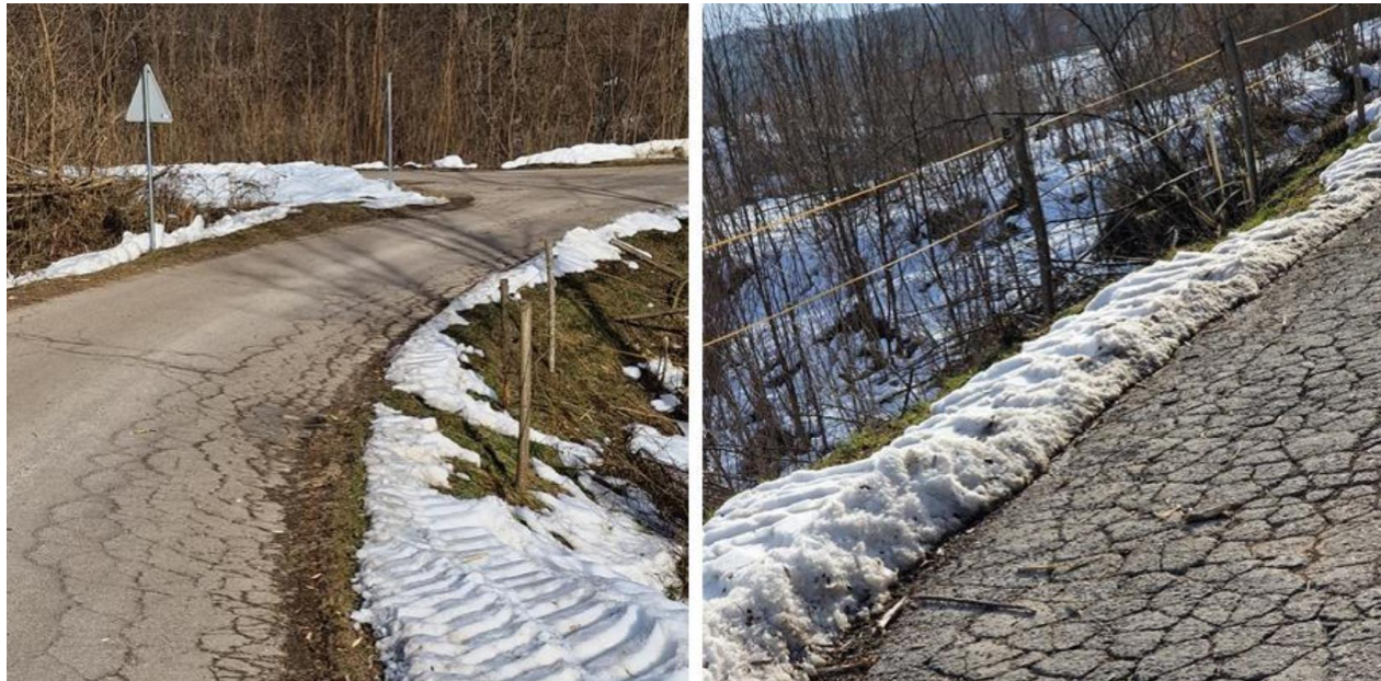
Slika 18. Puzanje bankine i procjeđivanje vode kroz bankinu
