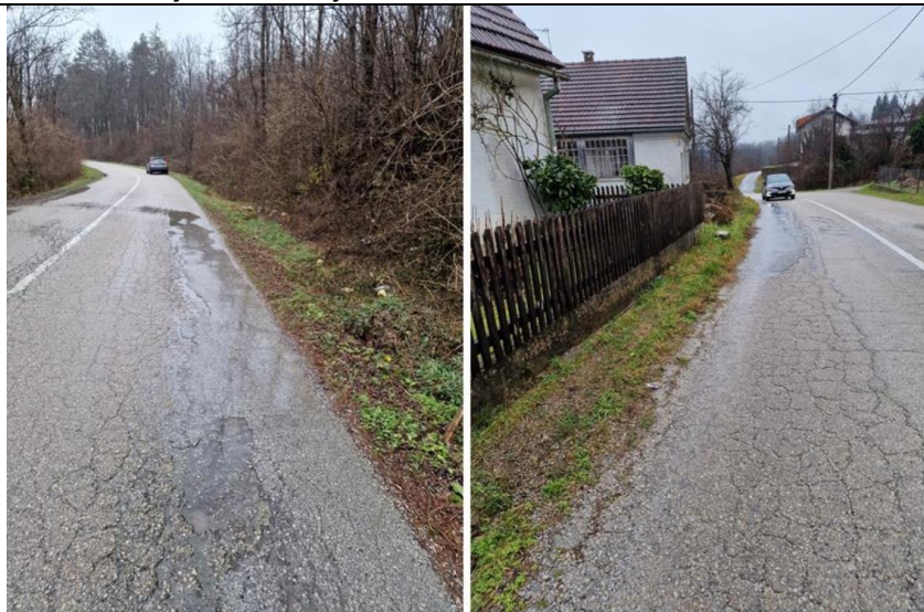
Slika 22. Županijska cesta ŽC 3176; Stacionaže: km 11+030 ÷ km 8+530
