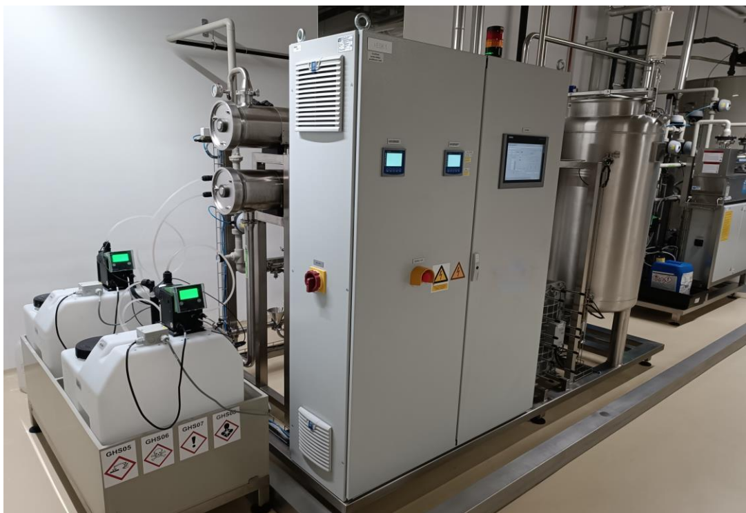
Slika 4. Proizvodnja tehnološke vode (Izvor: Autor)
