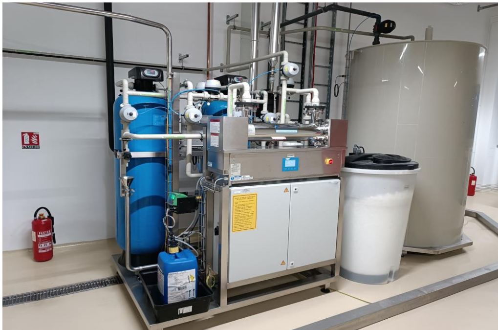
Slika 3. Predpriprema tehnološke vode (Izvor: Autor)
