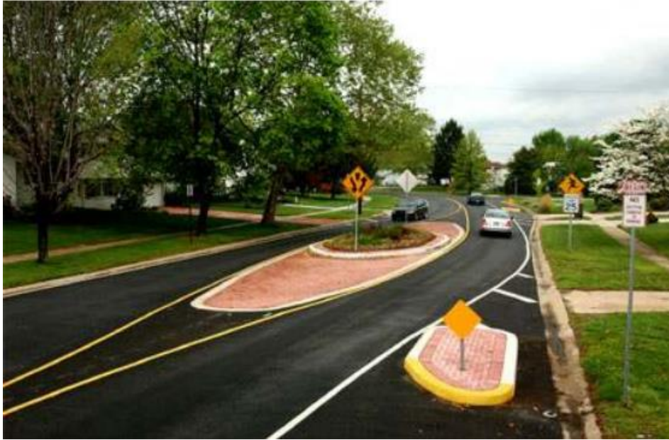
Slika 3-12 Primjer razdvajanja smjerova vožnje izvođenjem prometnih otoka
