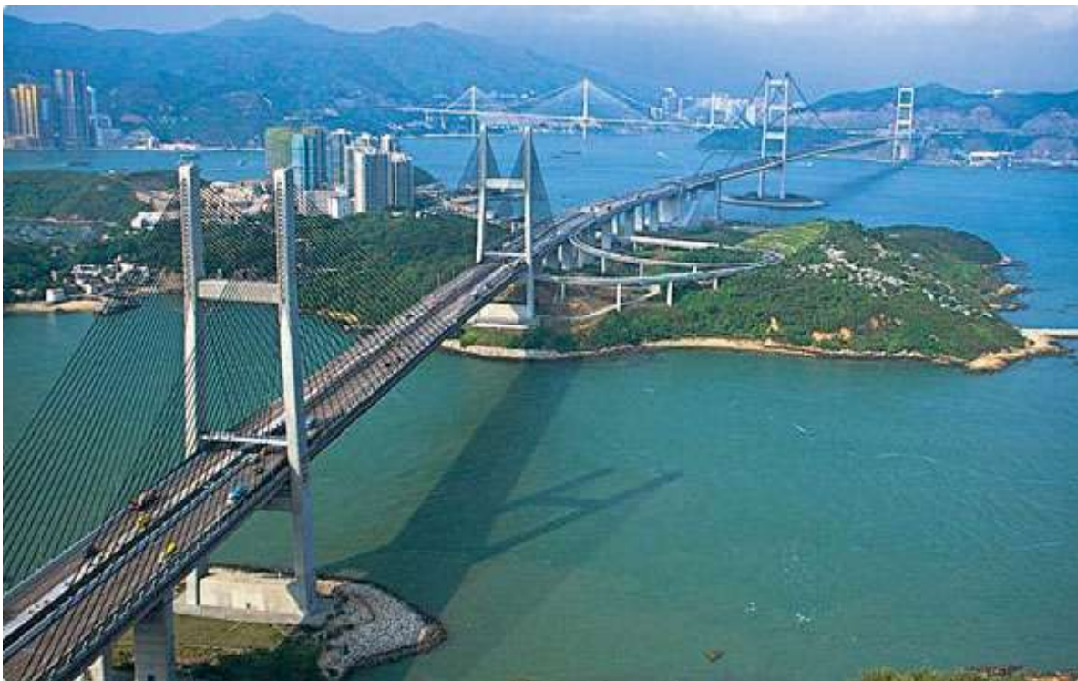
Slika 3a, Tsing Ma Bridge, izvor:
