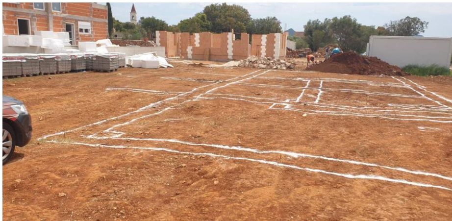
Slika.3.1.1 - Iscrtavanje temelja (iskolčenje)
