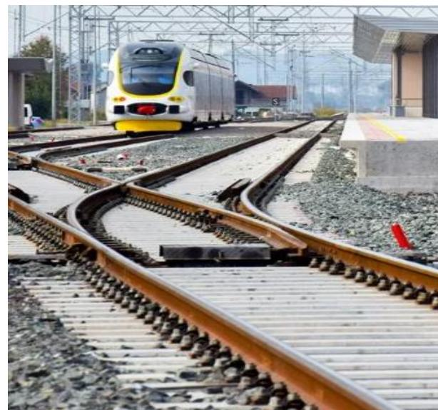
**Slika 3.4. Željeznička pruga- nosač na elastičnoj podlozi,**
