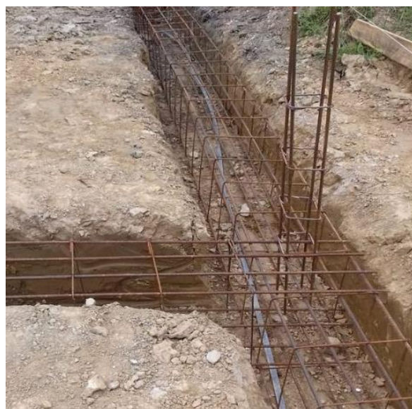
Slika 4.1. Armatura elastičnih temeljnih nosača na tlu
