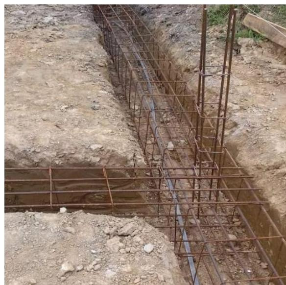
Slika 4.1. Armatura elastičnih temeljnih nosača na tlu
