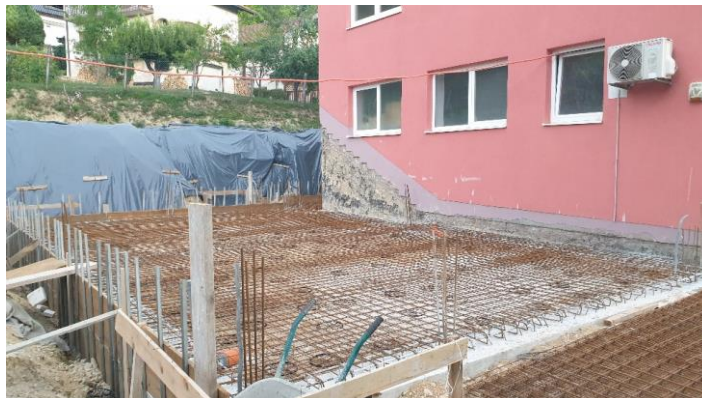
Slika. 3.3.1 Postavljena armaturna mreža za
