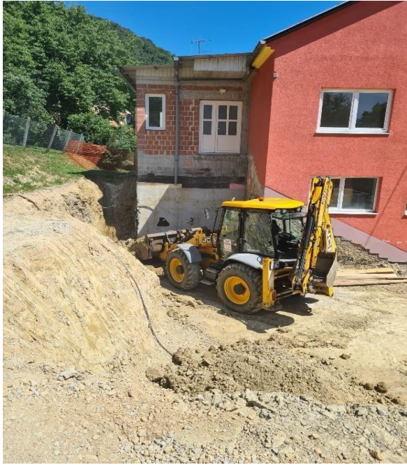
Slika 3.2.1 Strojni iskop građevinske jame
