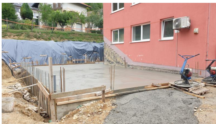
Slika 3.5.1. Prikazuje betoniranje AB podne ploče
