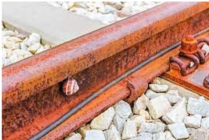
Slika 2.5. Prikaz opće korozije [7]
