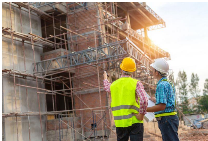
Slika 4. Nadzor na gradilištu (izvor: web)
