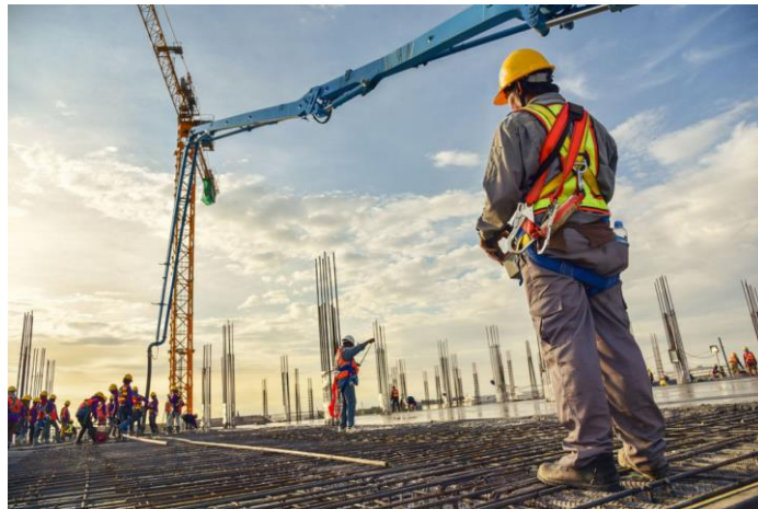
Slika 5. Provedba radova na gradilištu (izvor: web)
