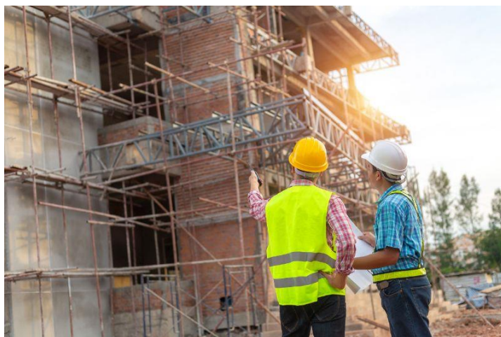
Slika 4. Nadzor na gradilištu (izvor: web)
