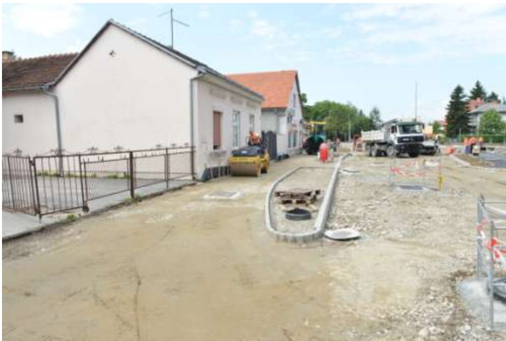
Slika 20. Ugradnja i zbijanje zrnatog kamenog materijala 0-60 mm (Izvor: PZC Varaždin d.d., arhiva fotografija, 2013.)
