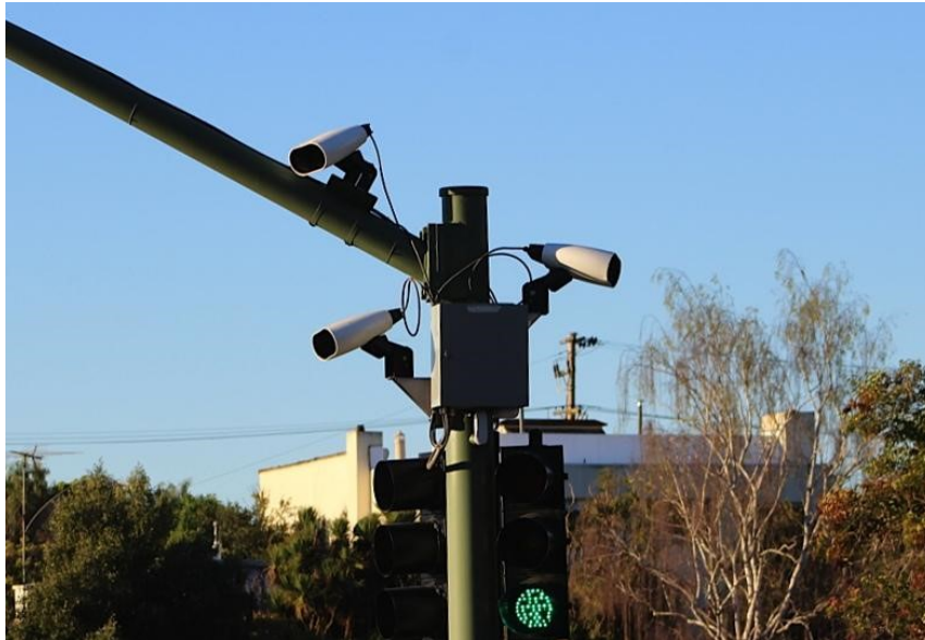
Slika 4.4. Stacionarne ANPR kamere, izvor:
