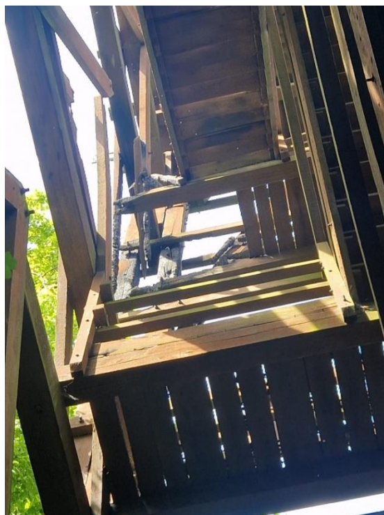
Slika 10.10. Dotrajali dijelovi vidikovca – izgoreni dijelovi
