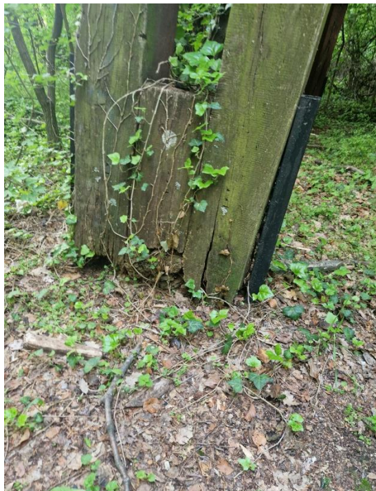
Slika 10.14. Spoj konstrukcije vidikovca i armirano-betonskih temelja
