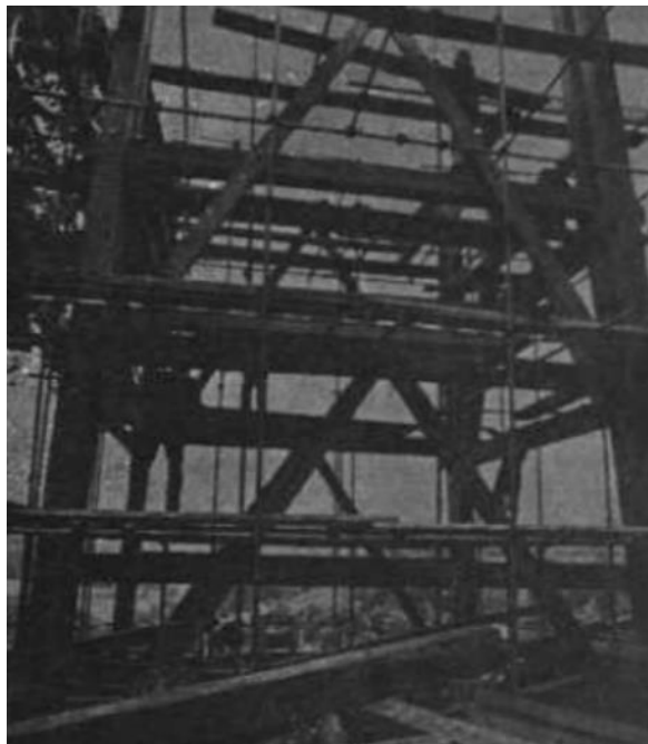
Slika 10.2. Vidikovac u tijeku izgradnje
