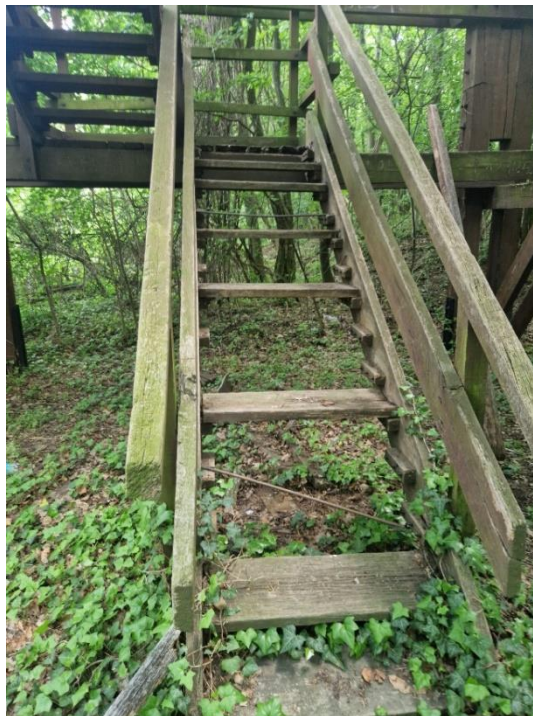
Slika 10.11. Dotrajali dijelovi vidikovca – ulazne stepenice
