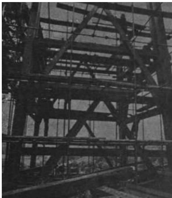
Slika 10.2. Vidikovac u tijeku izgradnje
