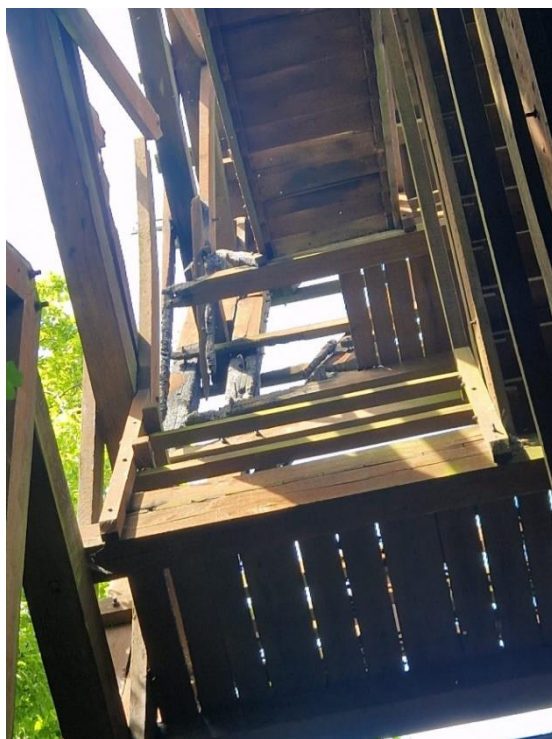
Slika 10.10. Dotrajali dijelovi vidikovca – izgoreni dijelovi
