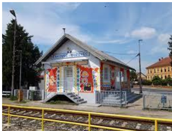
Slika 26 Novouređena željeznička stanica Čakovec-Buzovec
