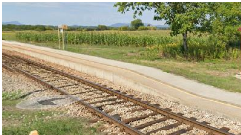
Slika 46 Željeznička stanica u naselju Vidovec
