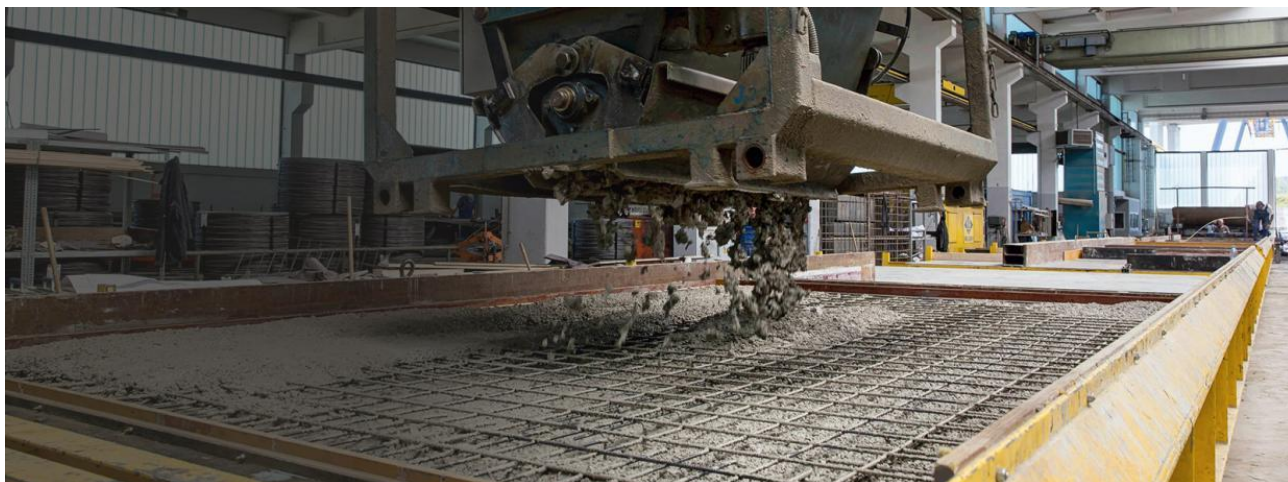
Slika 2.7. Proizvodnja predgotovljenog armiranobetonskog elementa
