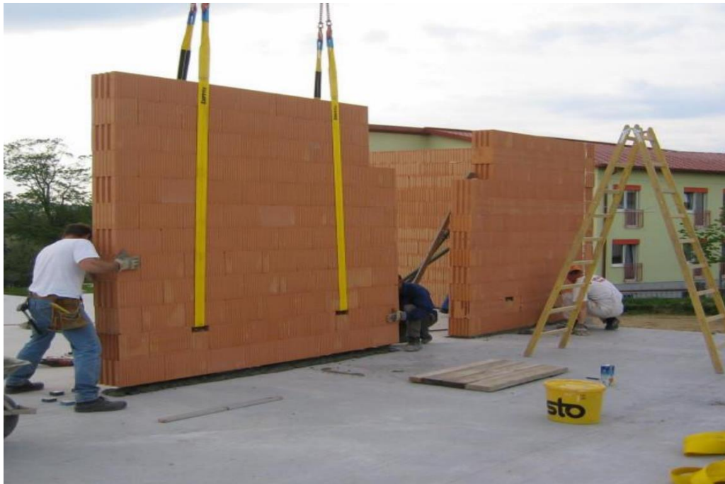
Slika 7.3. Montaža predgotovljenog zidnog opečnog elementa
