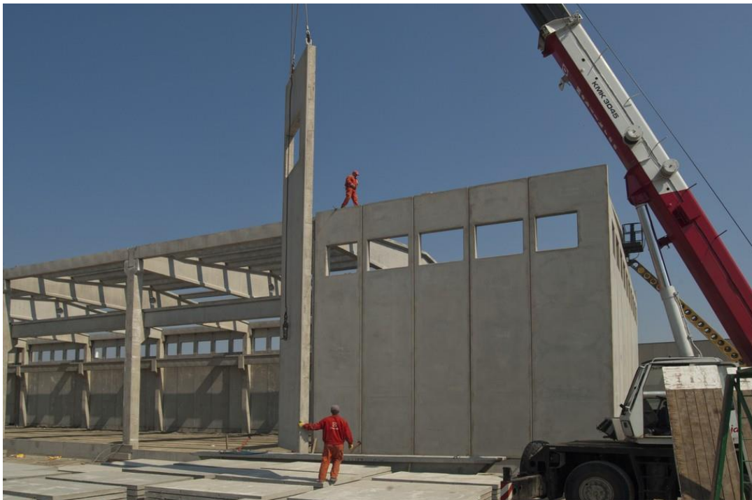
Slika 1.7. Montaža predgotovljenih panela
