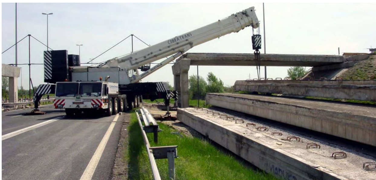
Slika 8: Pogled na demontažu dijelova nadvožnjaka sa autoceste A3 - Ivanić Grad
