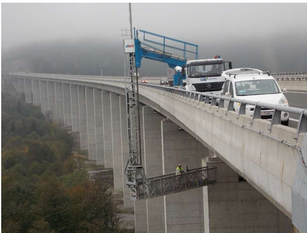
Slika 11: Vizualni pregled mosta uz pomoć posebne opreme – dizalice ( http://geoexpert-igm.hr/certifikacija/ob-poc-7-ag-03_cert-shema-ag-mort_izd-2/ )
