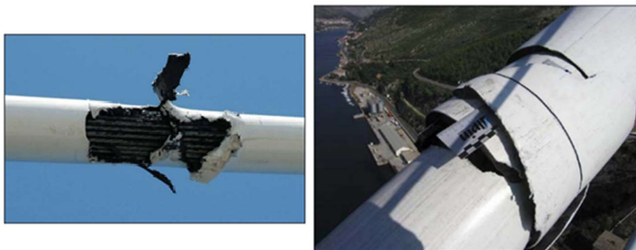
Slika 6: Oštećenje zaštitne cijevi
