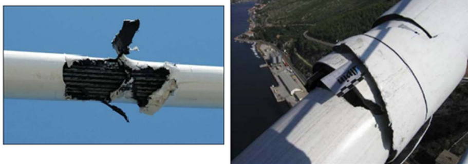
Slika 6: Oštećenje zaštitne cijevi
