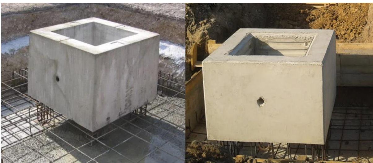
Slika 3.8 Prikaz izvedbe čaša s glatkom (lijevo) i nazubljenom površinom (desno) [15]
