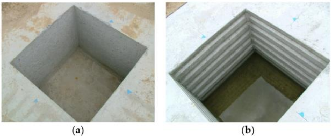
Slika 3.1 Prikaz unutarnje površine temeljnih čaša: (a) s glatkom površinom i (b) s nazubljenom površinom [4]
