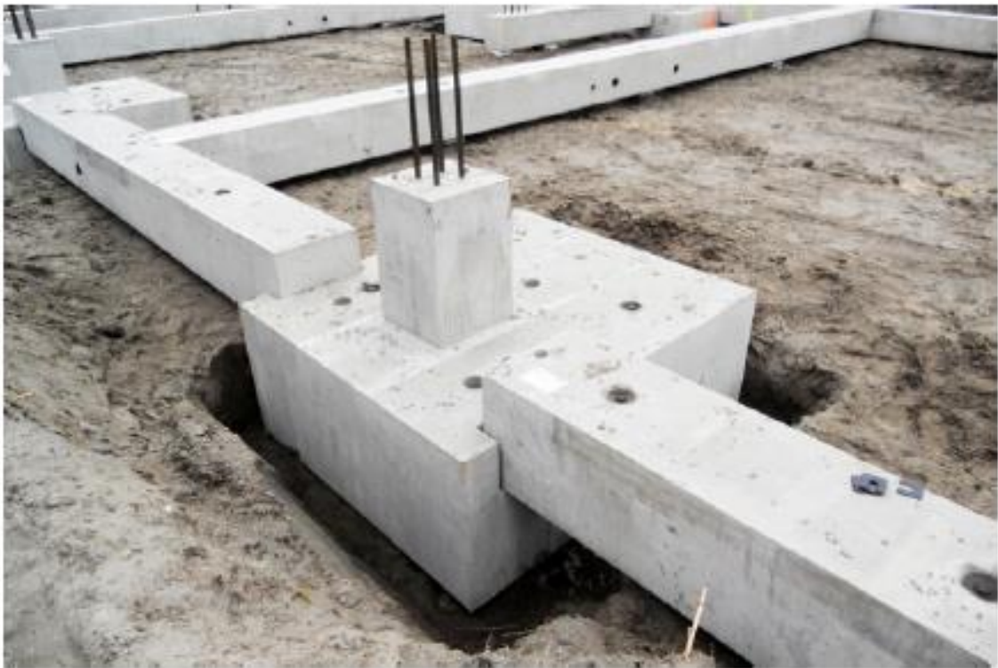
Slika 4.2 Izvedba na gradilištu [11]
