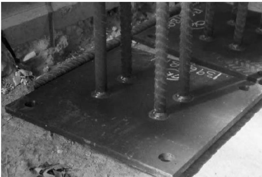
Slika 2.6 Čelična ploča prije ugradnje [1]
