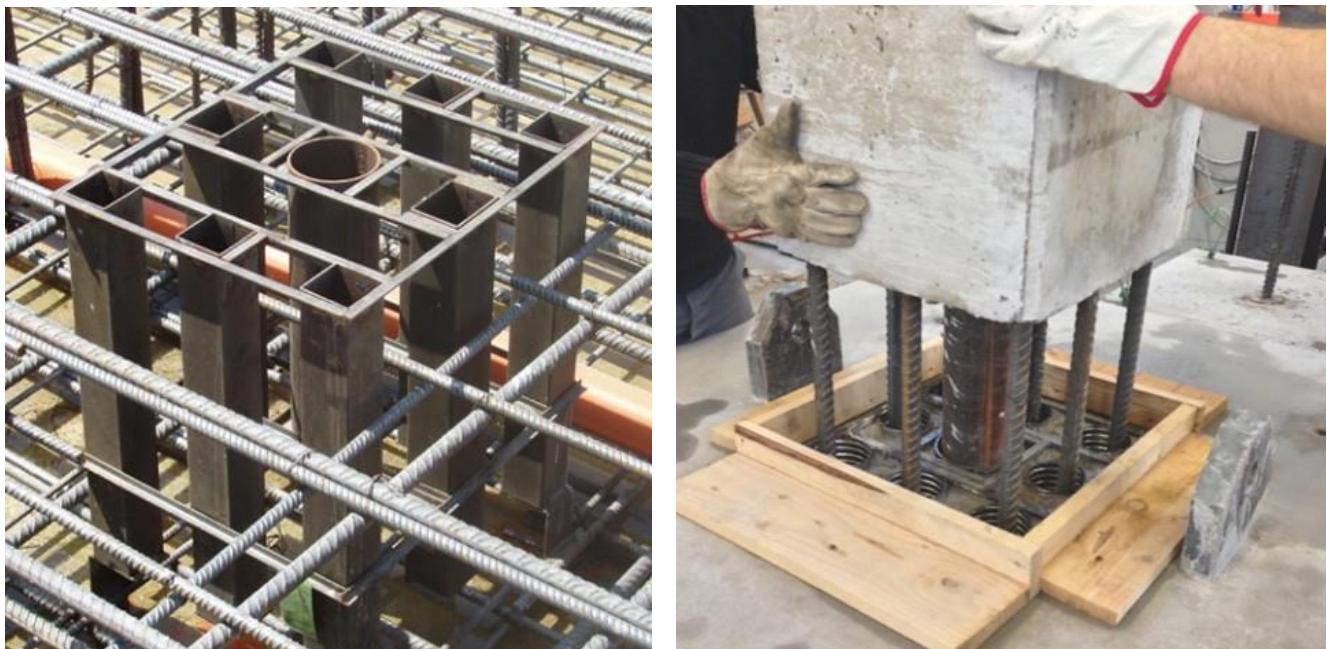
Slika 2.12 Čelične cijevi (lijevo) i spajanje stupa i temelja (desno) [5]
