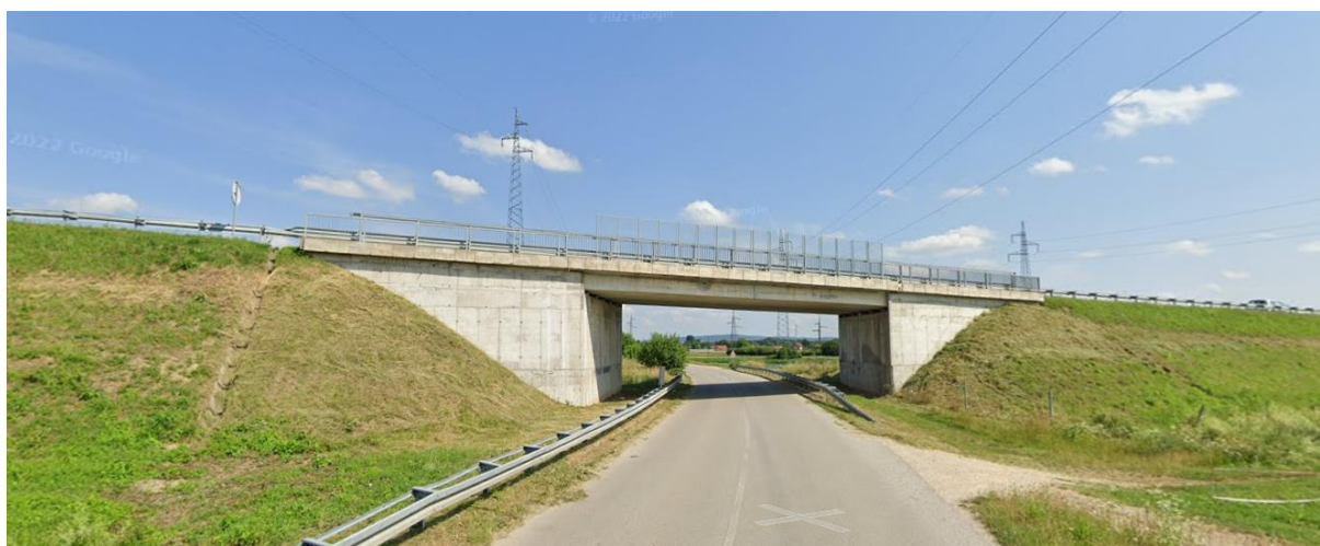
Slika 2.3 Cestovni nadvožnjak u naselju Jalkovec, prevodi državnu cestu D2 preko lokalne ceste između naselja Gojanec i Jalkovec (Izvor: Google karte)
