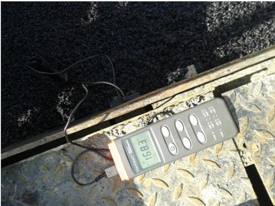
Slika 50. Mjerenje temperature asfaltne mješavine kod puža finišera
