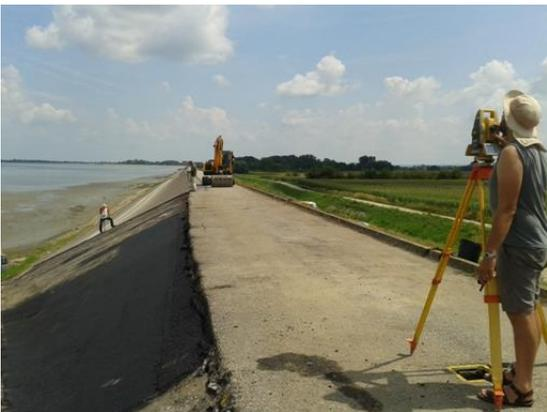
Slika 68. Provedba geodetskih mjerenja u toku izvedbe radova
