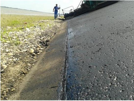
Slika 48. Uzdužni spoj na dnu zahvata kvalitetno premazan hladnom bitumenskom pastom
