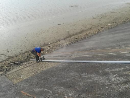
Slika 30. Zarezivanje rubova plošnih oštećenja
