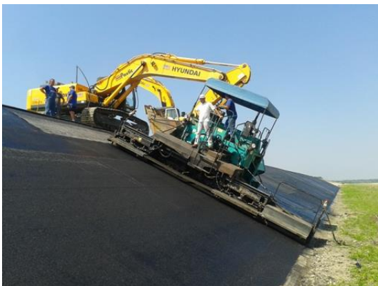
Slika 56. Ugradnja asfaltne mješavine vodoneprop. asfaltnog sloja (donja zona)
