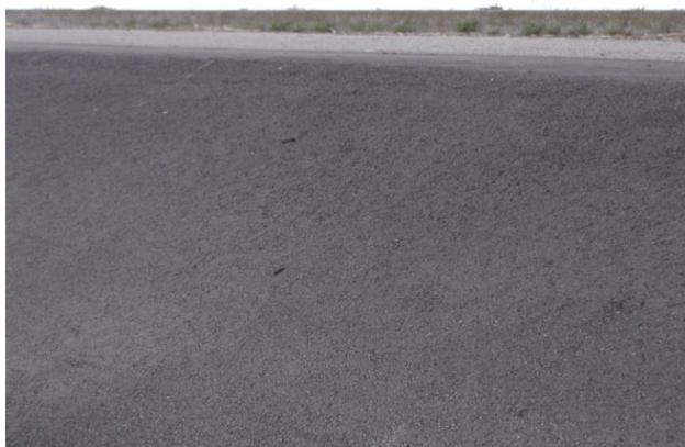
Slika 6. Vodozaštitni sloj asfalta
