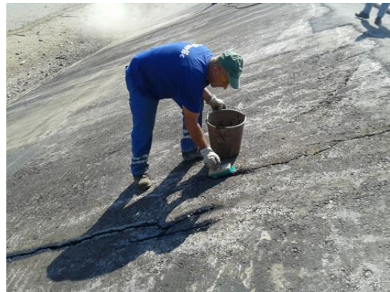
Slika 39. Nanašanje „primera“ na mjestima strukturnih pukotina
