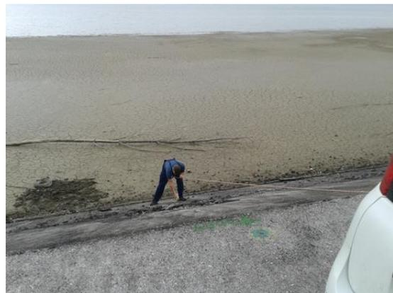
Slika 29. Označavanje granica plošnih oštećenja nosivog asfaltnog sloja
