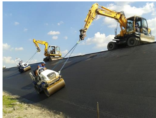
Slika 55. Zbijanje asfaltne mješavine vodoneprop. asfaltnog sloja (donja zona)
