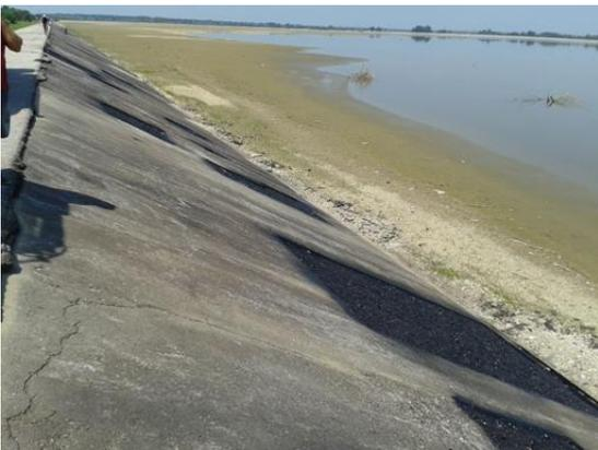
Slika 32. Uređena i bit. emulzijom prešpricana podloga plošnih oštećenja
