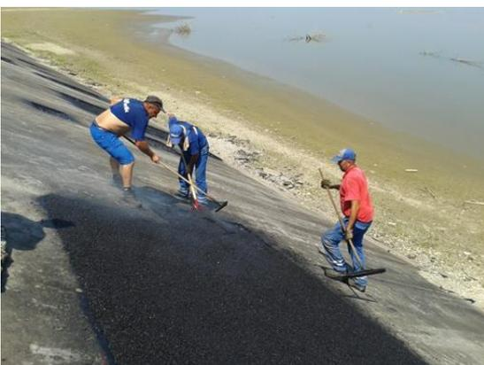
Slika 34. Ručno razastiranje i planiranje asfaltne mješavine na mjestima plošnih oštećenja
