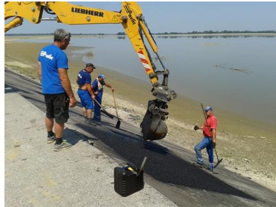
Slika 33. Ugradnja asfalta na mjestima plošnih oštećenja
