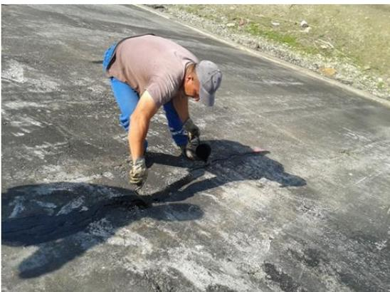
Slika 40. Zapunjavanje strukturnih pukotina vrućom polimernom bitumenskom masom
