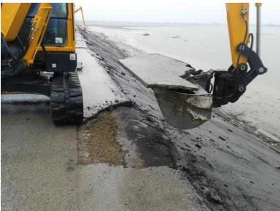
Slika 28. „Otvaranje“ detalja podvučenog vodonepropusnog sloja na kruni nasipa
