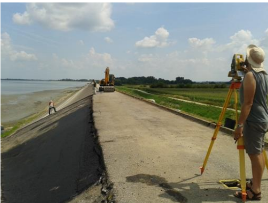
Slika 68. Provedba geodetskih mjerenja u toku izvedbe radova
