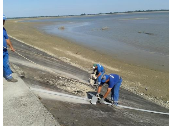
Slika 31. Zarezivanje rubova plošnih oštećenja
