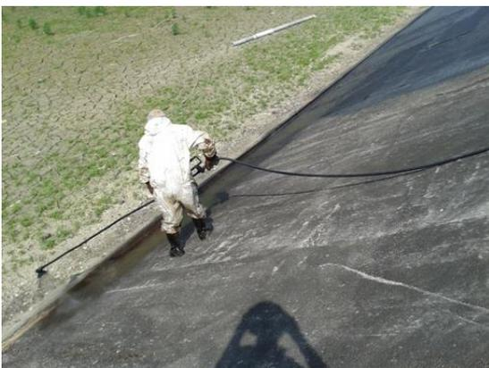
Slika 46. Špricanje polimerne bitumenske kationske emulzije na uzdužni rub na dnu zahvata
