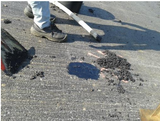
Slika 62. Propisno saniranje pozicija uzimanja uzoraka iz sloja bušenjem
