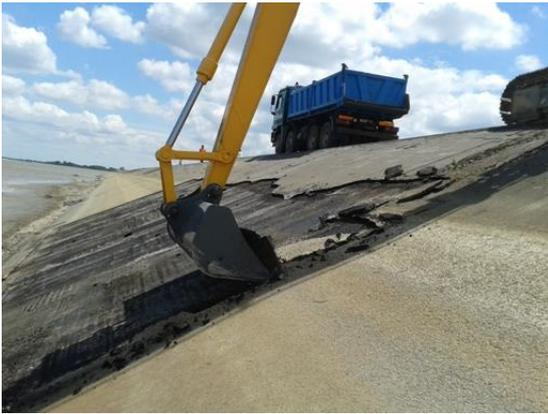
Slika 24. Uklanjanje oštećene asfalt-betonske obloge struganjem korpom bagera (donja zona)
