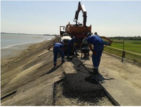
Slika 42. Ugradnja asfaltne mješavine - priprema podloge za vodonepropusni asfaltni sloj
