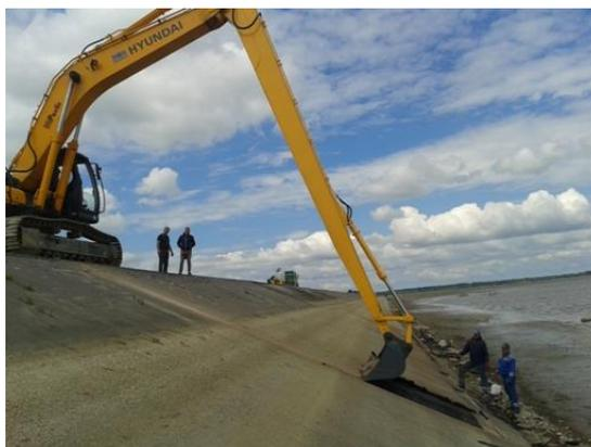
Slika 23. Uklanjanje oštećene asfalt-betonske obloge struganjem korpom bagera (donja zona)
