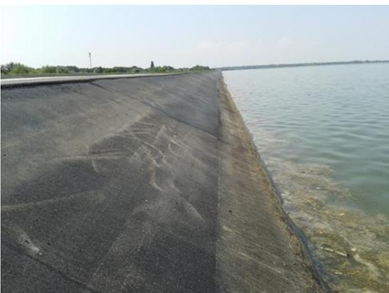
Slika 82. Detalj završenih radova na zamjeni asfalt-betonske obloge kosine nasipa (pri radnoj koti vodostaja akumulacije)
