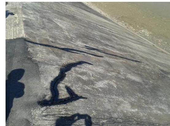
Slika 41. Sanirane strukturne pukotine
