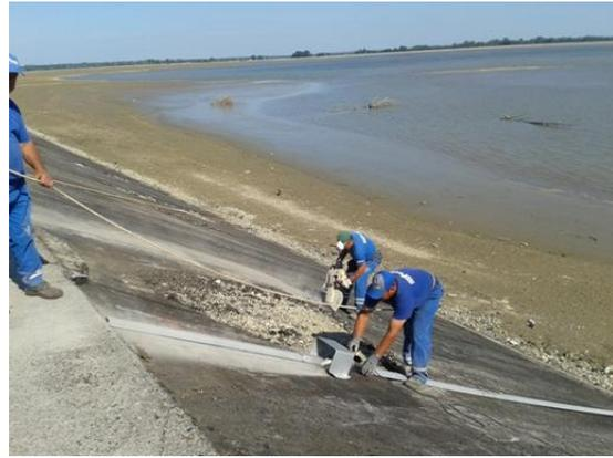
Slika 31. Zarezivanje rubova plošnih oštećenja
