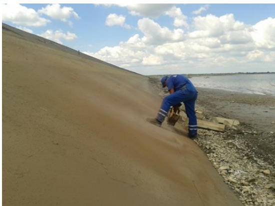
Slika 20. Zarezivanje uzdužnog „šlica“ na granici zahvata
