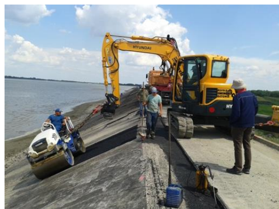
Slika 35. Zbijanje asfalta na mjestima plošnih oštećenja
