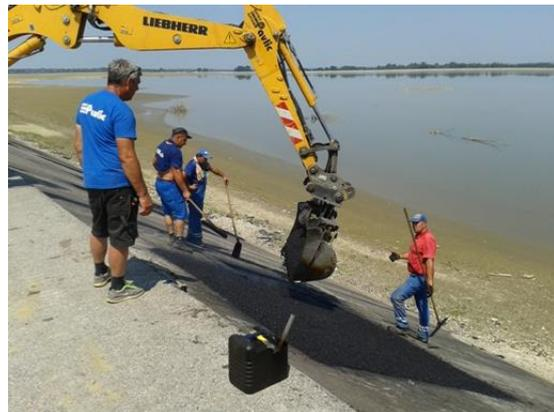
Slika 33. Ugradnja asfalta na mjestima plošnih oštećenja
