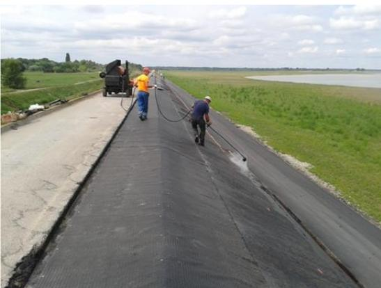
Slika 70. Špricanje uzdužnog radnog spoja polimernom bitumenskom emulzijom
