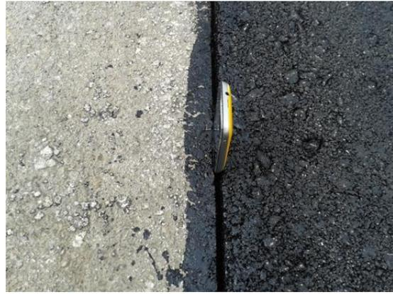
Slika 79. Detalj zarezanog uzdužnog radnog spoja na kruni nasipa (š=1 cm)
