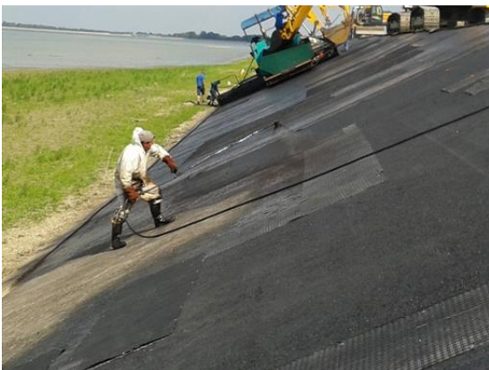
Slika 44. Špricanje polimerne bitumenske kationske emulzije na pripremljenu podlogu
