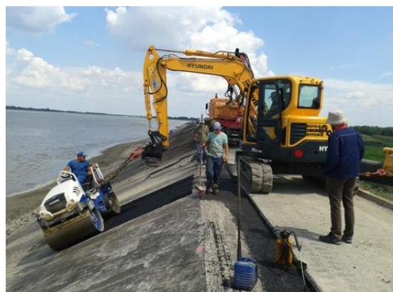
Slika 35. Zbijanje asfalta na mjestima plošnih oštećenja
