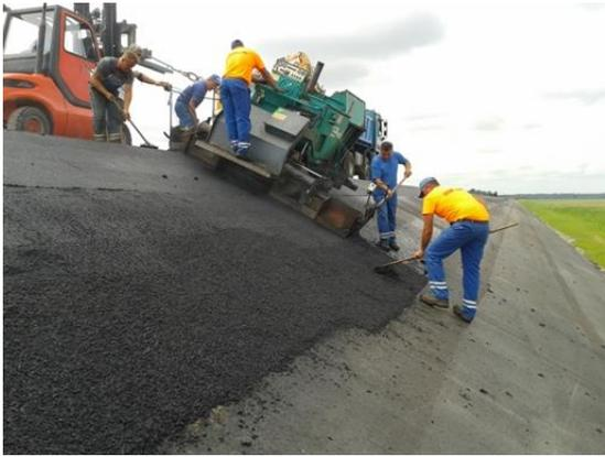
Slika 72. Ugradnja asfaltne mješavine vodoneprop. asfaltnog sloja na kosini nasipa (gornja zona)
