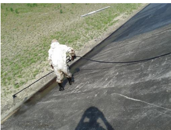
Slika 46. Špricanje polimerne bitumenske kationske emulzije na uzdužni rub na dnu zahvata
