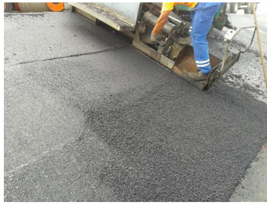
Slika 73. Detalj ručne ugradnje (gornja zona je mjestimično šira od pegle finišera)
