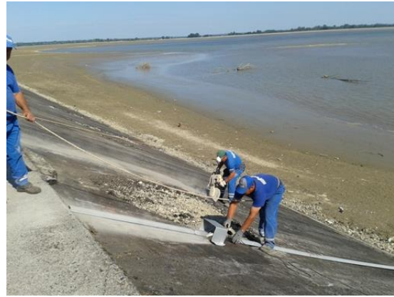
Slika 31. Zarezivanje rubova plošnih oštećenja
