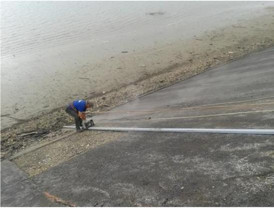
Slika 30. Zarezivanje rubova plošnih oštećenja
