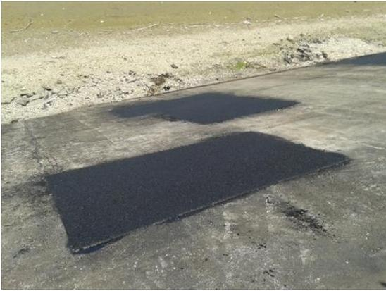
Slika 36. Sanirana površina na mjestima plošnih oštećenja
