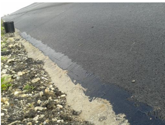
Slika 76. Kvalitetno premazan uzdužni sloj na dnu granice zahvata
