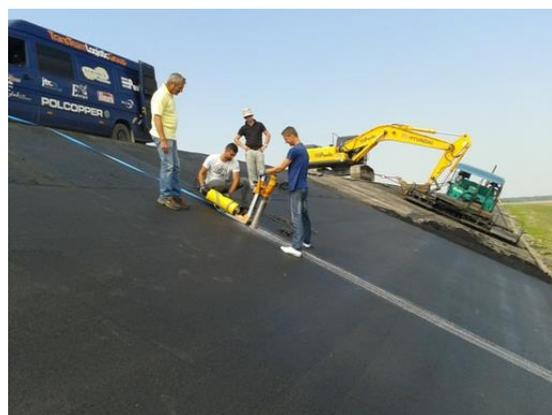
Slika 59. Uzorkovanje uzoraka iz ugrađenog asfaltnog sloja bušenjem
