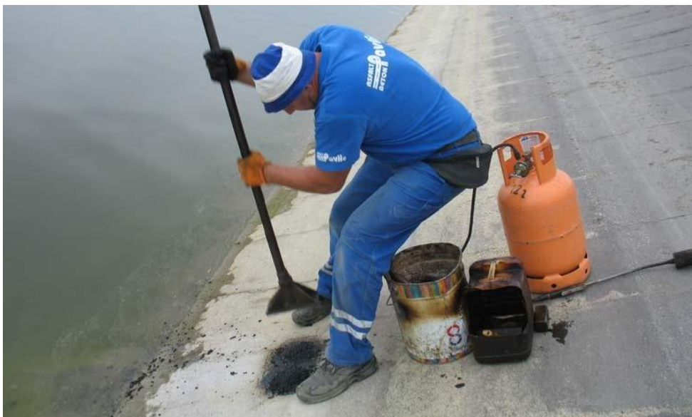
Slika 85. Sanacija rupa vrućom asfaltnom mješavinom sa zbijanjem
