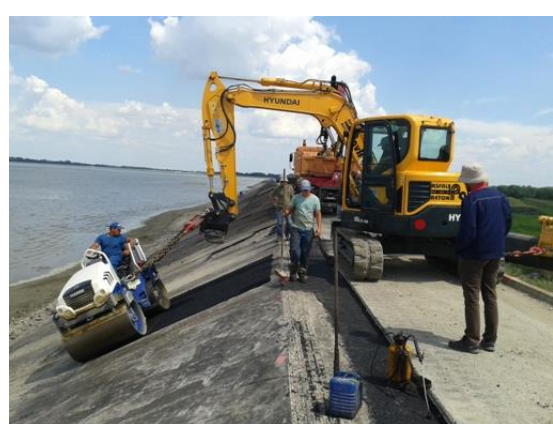
Slika 35. Zbijanje asfalta na mjestima plošnih oštećenja
