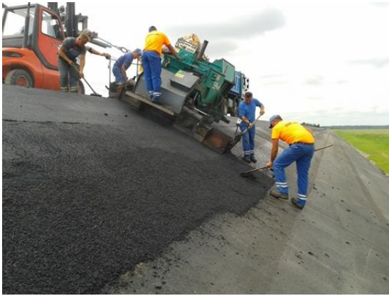
Slika 72. Ugradnja asfaltne mješavine vodoneprop. asfaltnog sloja na kosini nasipa (gornja zona)
