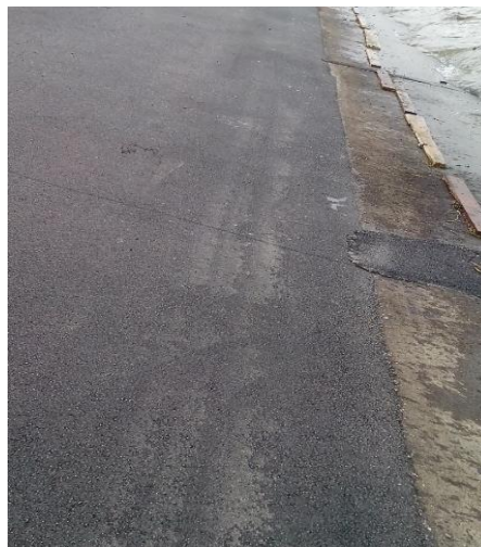
Slika 7. Vodozaštitni sloj asfalta
