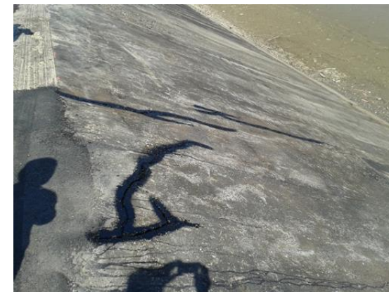
Slika 41. Sanirane strukturne pukotine
