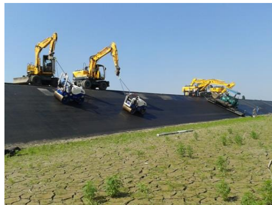
Slika 57. Zbijanje asfaltne mješavine vodoneprop. asfaltnog sloja (donja zona)
