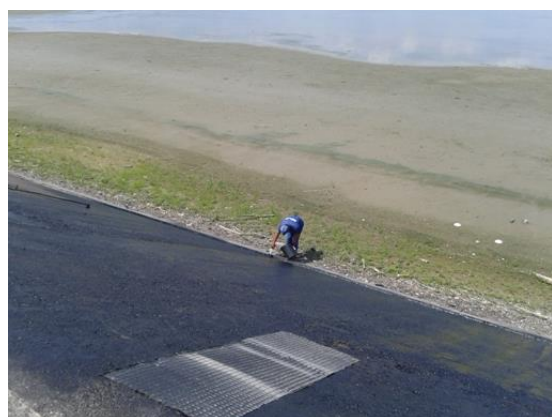
Slika 47. Premazivanje uzdužnog ruba na dnu zahvata hladnom bitumenskom pastom
