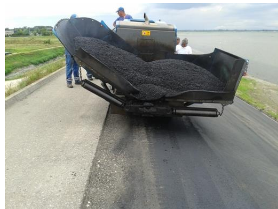
Slika 77. Ugradnja asfaltne mješavine nosivo - habajućeg sloja na kruni nasipa (š=1,6 m)
