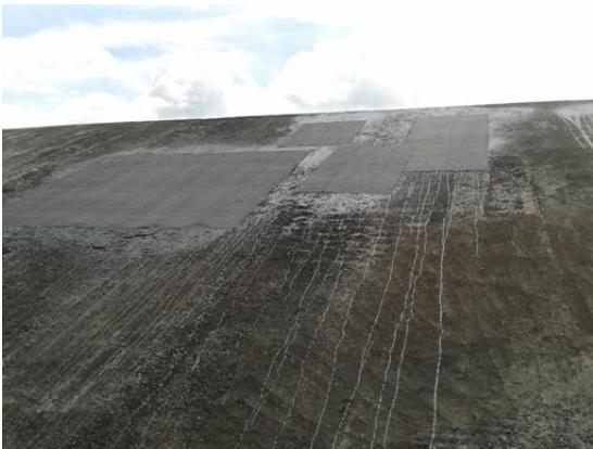
Slika 38. Ugrađene mreže za armiranje asfalta na mjestima saniranih površina plošnih oštećenja
