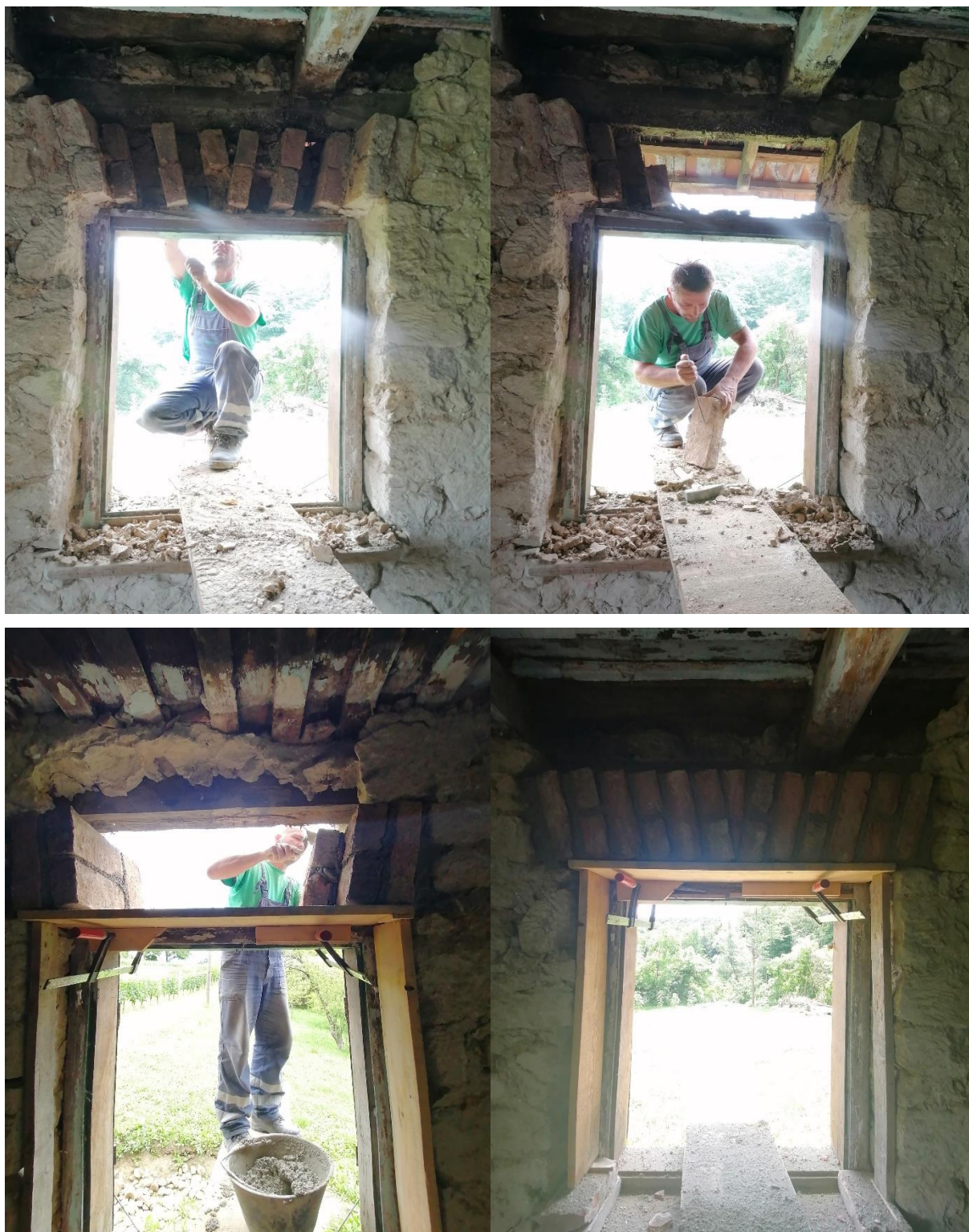
Slika 5.57: Rušenje nadvoja (gore lijevo i desno), zidanje nadvoja s podupiračem (dolje lijevo) i gotovi nadvoj (dolje desno)
