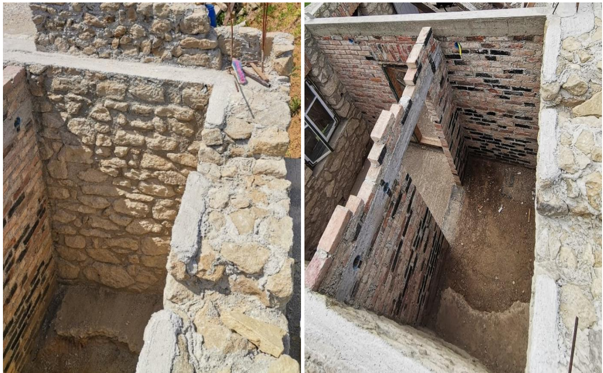
Slika 5.47: Nova ležišta grednika prije ugradnje novih grednika
