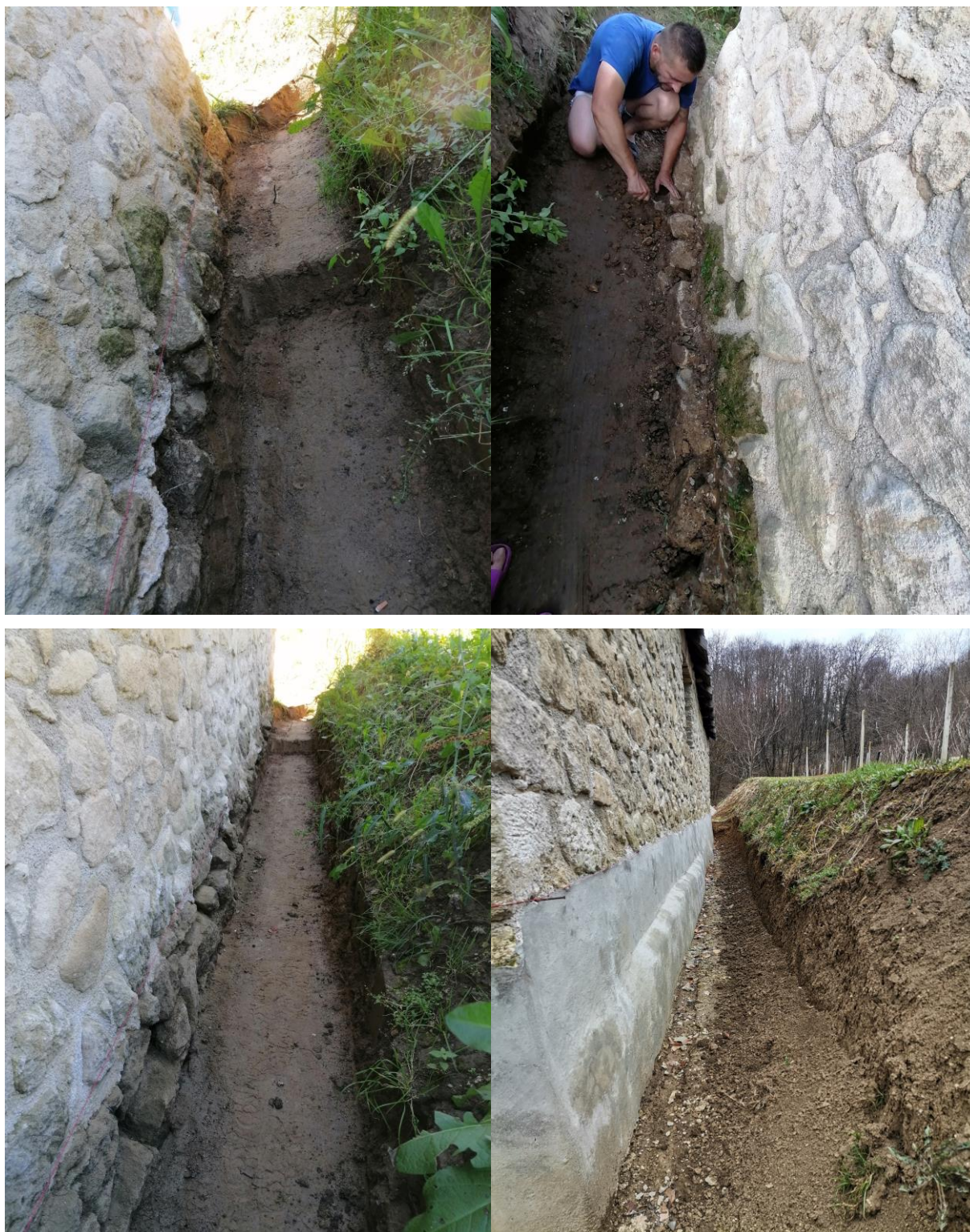
Slika 5.1: Otkopavanje uz temelje (gore lijevo), čišćenje fuga (gore desno), očišćene fuge (dolje lijevo), završeni temelji (dolje desno)
