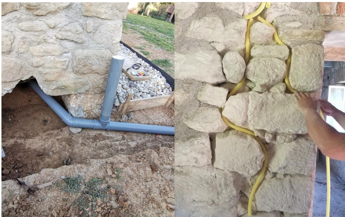
Slika 5.90: Provlačenje bužira za struju (desno) i cijevi za kanalizaciju (lijevo)
