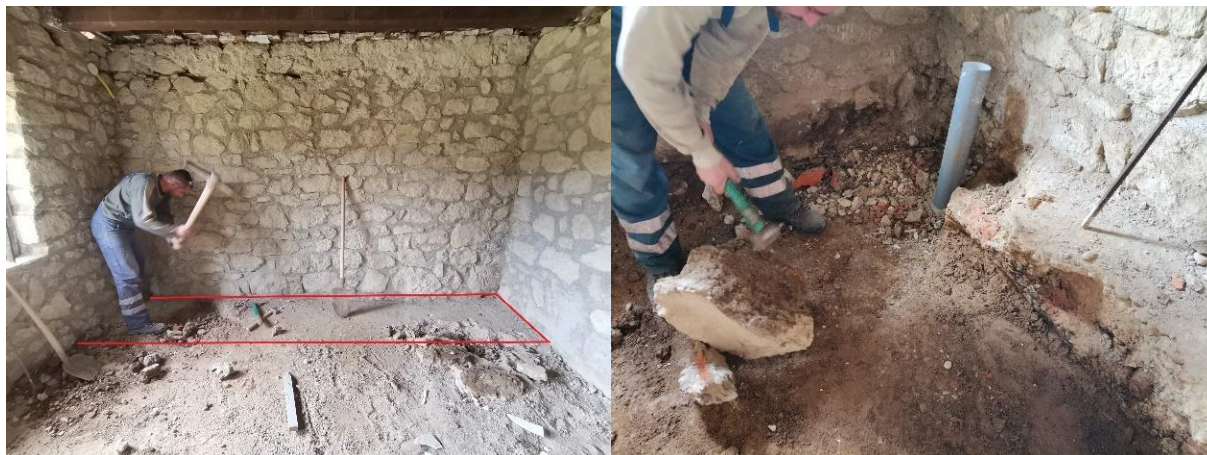
Slika 5.20: Razbijanje mase od opeke i betona
