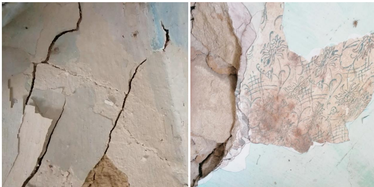
Slika 5.7: Slojevi unutarnjih zidova i zid ukrašen valjkom s mustrom
