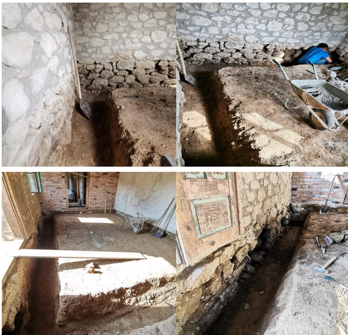
Slika 5.53: Otkopavanje unutar objekta uz zidove
