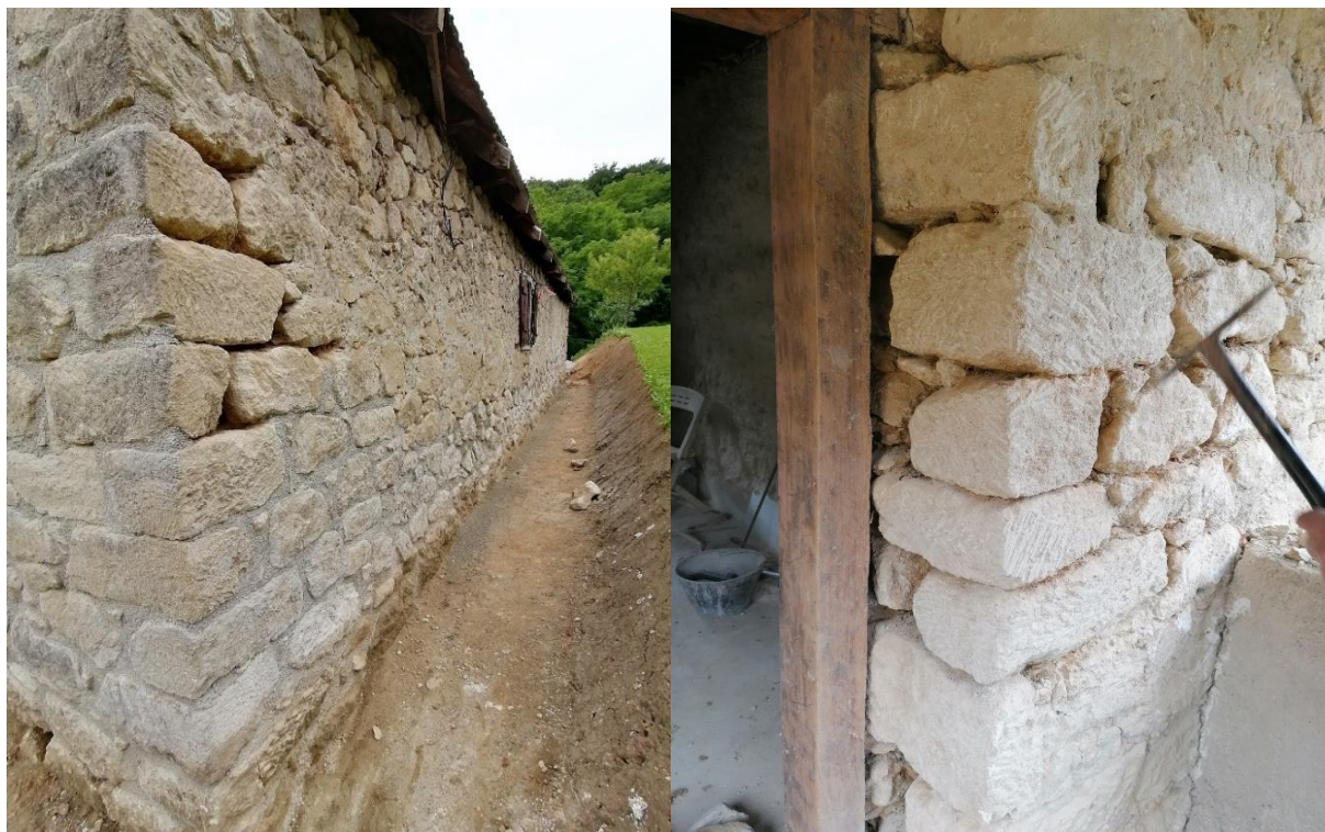
Slika 4.9: Kamene uglovi
