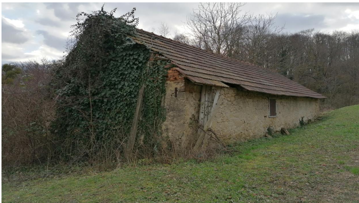
Slika 3.6: Zatečeno stanje – sjeveroistočno pročelje
