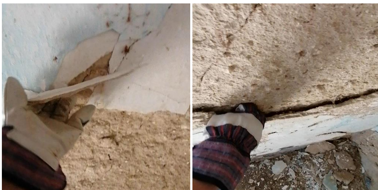
Slika 5.8: Skidanje žbuke s unutarnjih zidova
