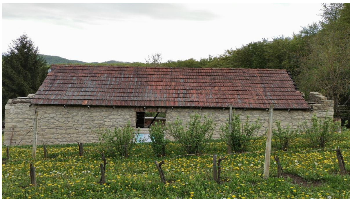
Slika 5.70: Segmentno rušenje krova s istočne i zapadne strane dalji kadar
