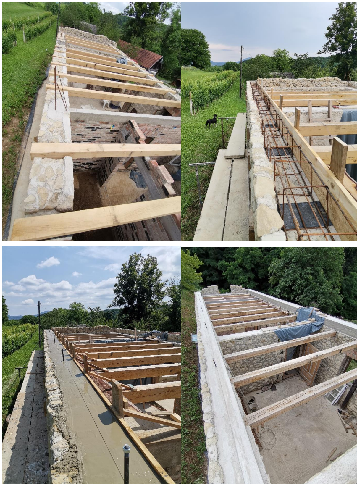
Slika 5.39: Ugradnja grednika u utore (gore lijevo), izrada kamenog zidića (gore desno), ugradanja ankera i betona (dolje lijevo), završni izgled serklaža (dolje desno)
