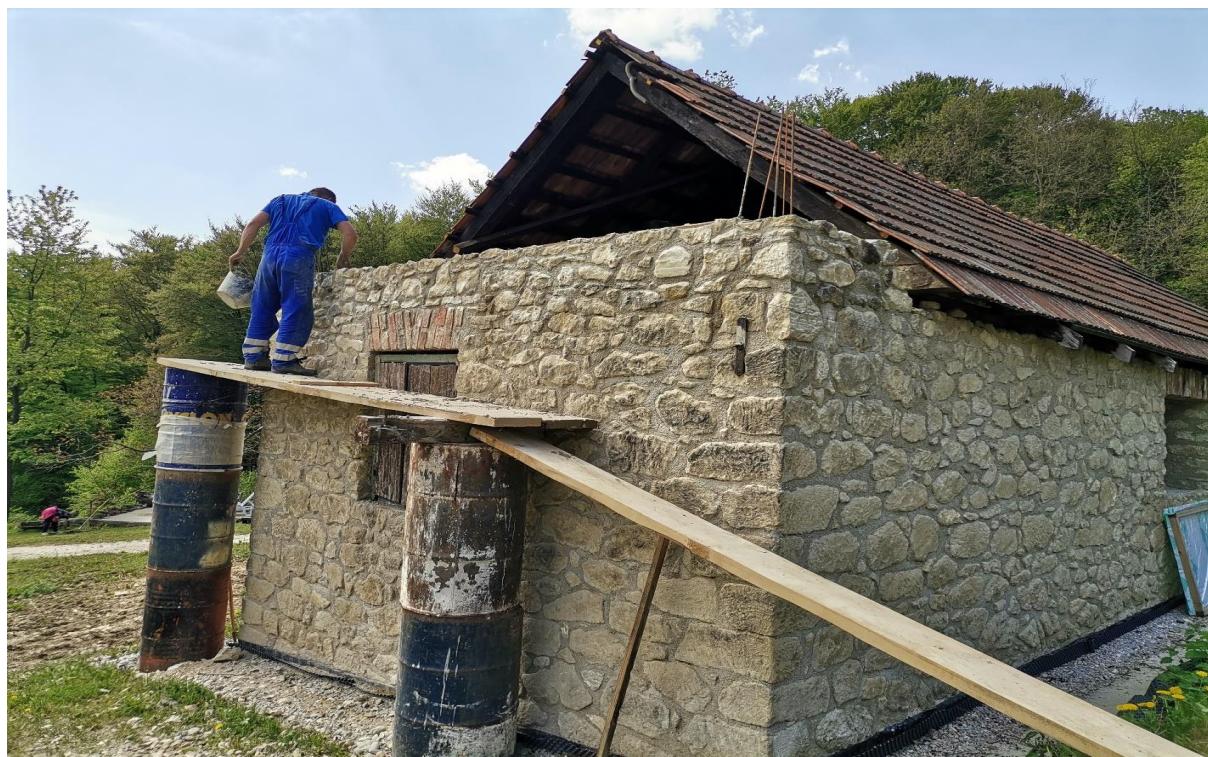
Slika 5.35: Ugradnja betona i improvizacija skele (istočna strana)
