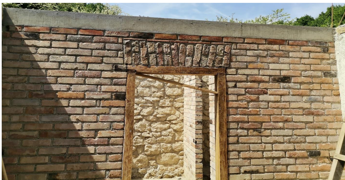
Slika 5.44: Gotovi pregradni zid
