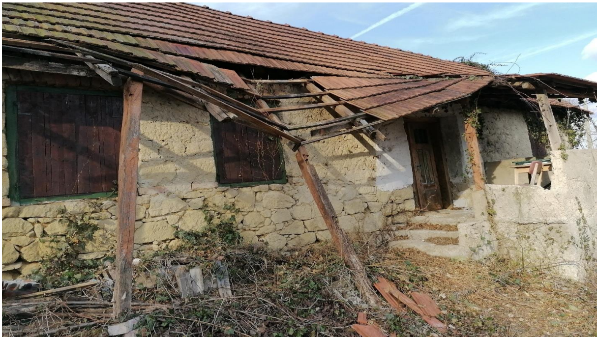
Slika 5.95: Izgled postojeće terase na objektu
