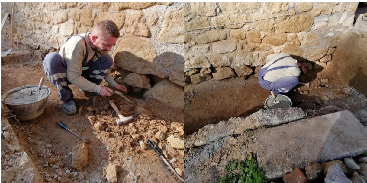
Slika 5.3: Potkopavanje temelja u etapama
