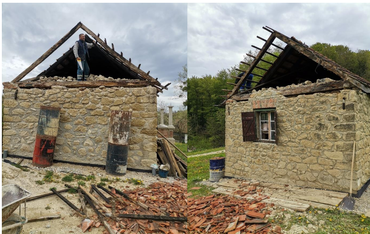
Slika 5.69: Segmentno rušenje krova s istočne i zapadne strane bliži kadar
