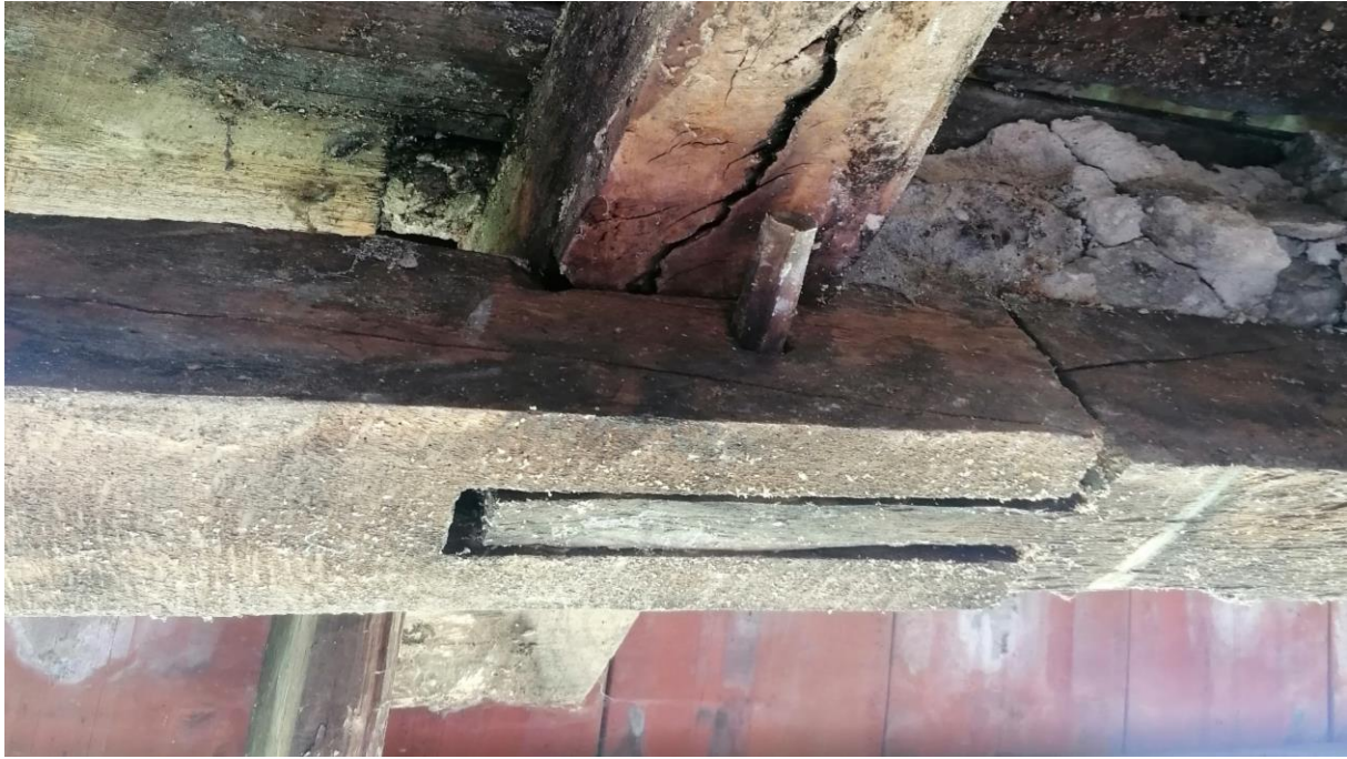
Slika 3.35: Način spajanja nazidnih greda
