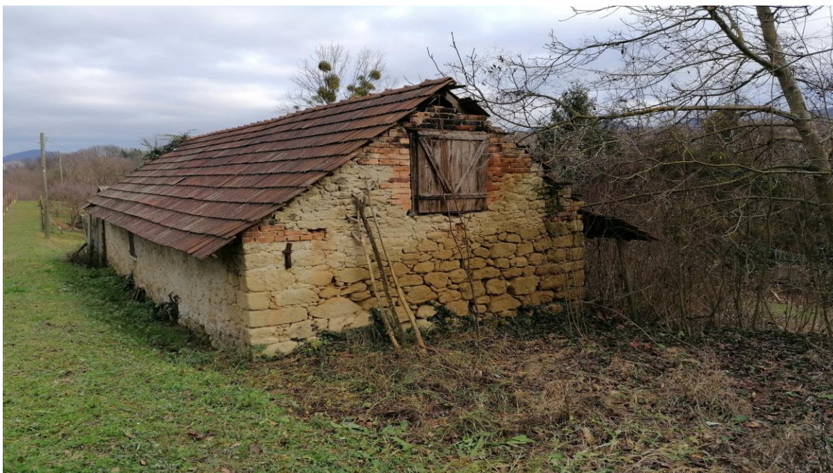
Slika 3.8: Zatečeno stanje – sjeverozapadno pročelje
