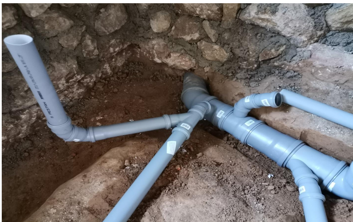
Slika 5.94: Postavljanje odvodnih i kanalizacionih cijevi
