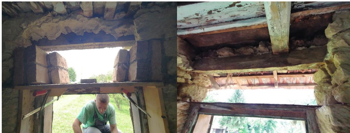
Slika 5.56: Nadvoji nakon rušenja
