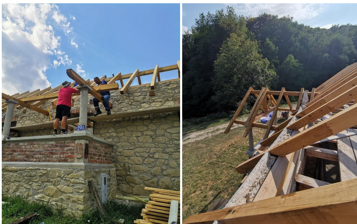
Slika 5.85: Izrada krova terase
