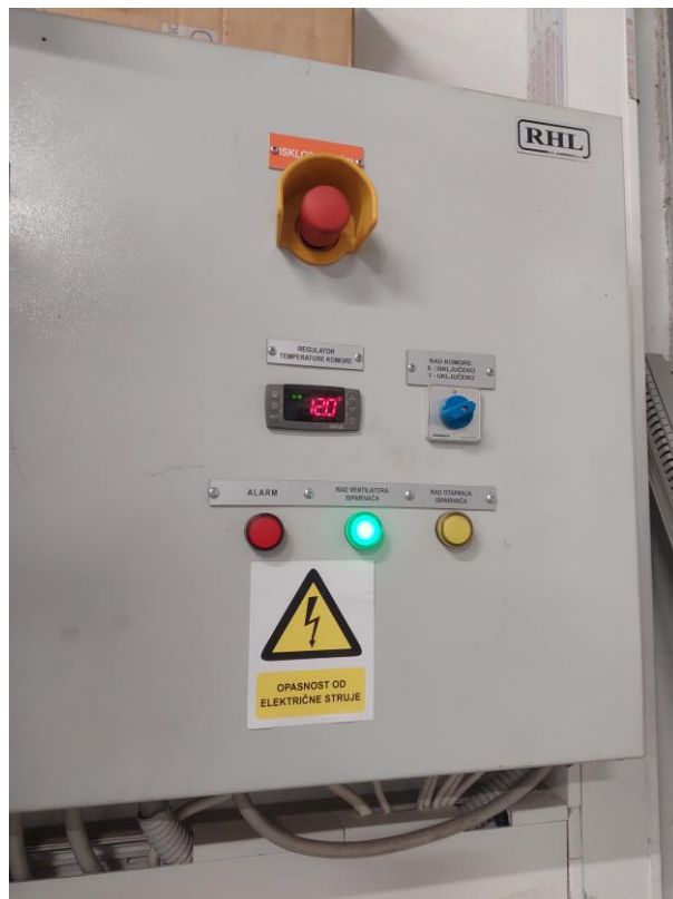
Slika 4.17. Sandučić za upravljanje hladnjačom
