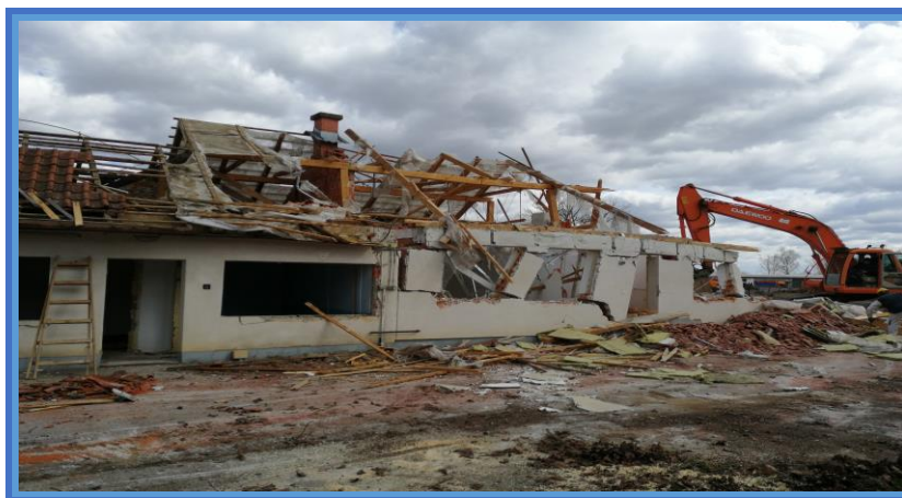
Slika 7. Rušenje postojećih zgrada na parceli [8].
