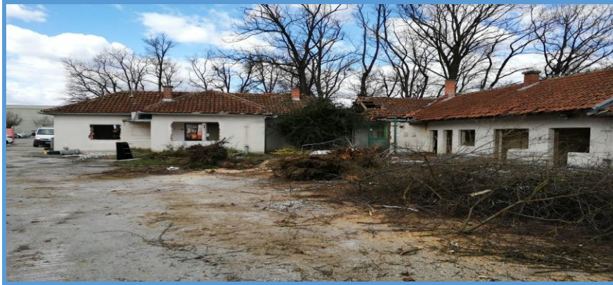
Slika 8. Rušenje postojećih zgrada na parceli [8].
