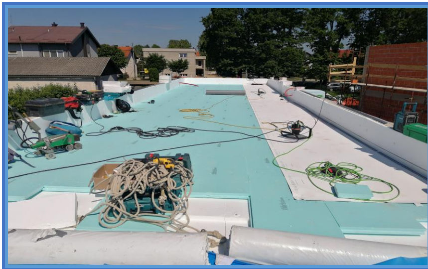
Slika 40. Postavljanje TPO membrane [8].
