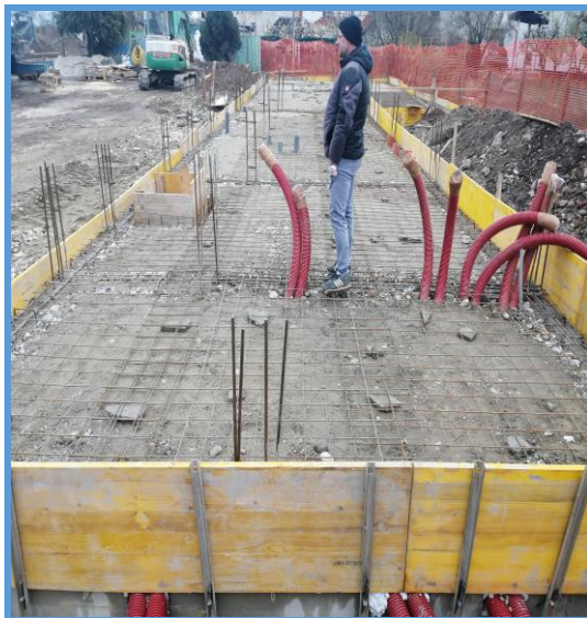
Slika 54. Cijevi za elektroinstalacije [8].
