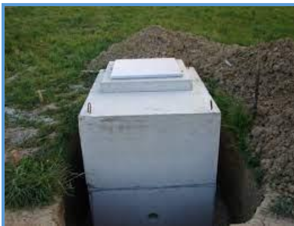
Slika 49. AB vodomjerno okno [8].
