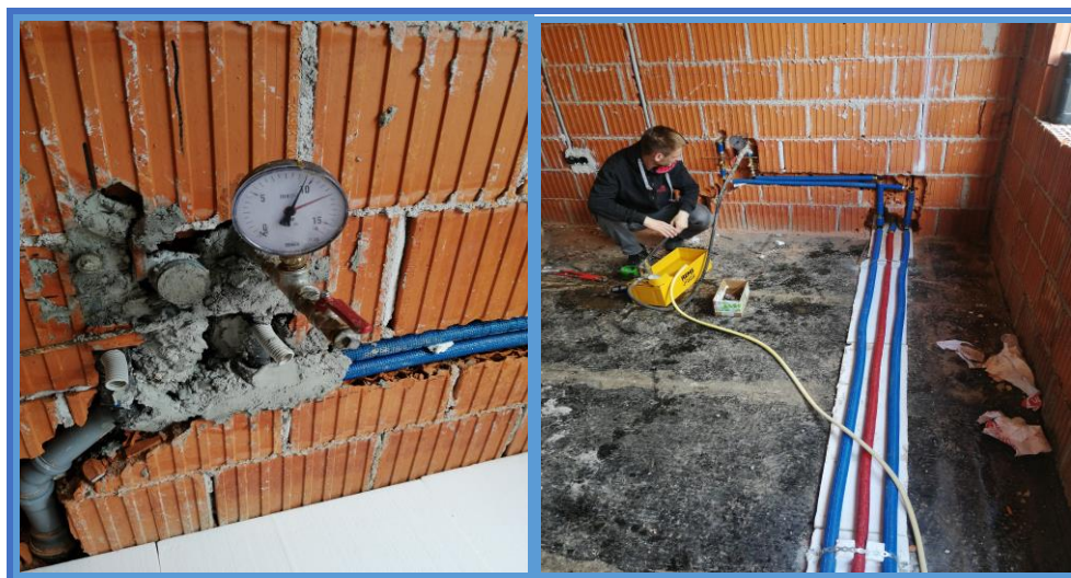
Slika 50. Tlačna proba cjevovoda [8].
