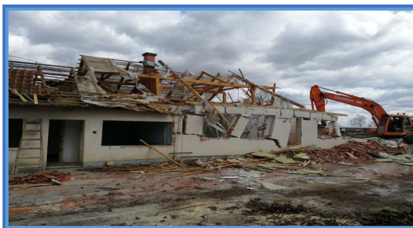
Slika 7. Rušenje postojećih zgrada na parceli [8].
