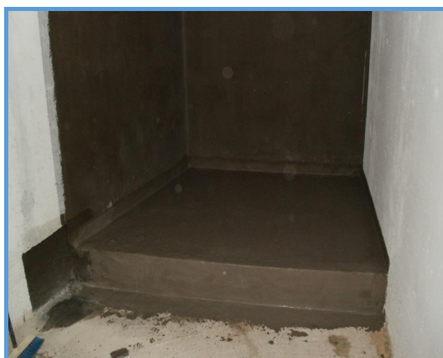
Slika 38. dvokomponentna polimercementna hidroizolacija [8].
