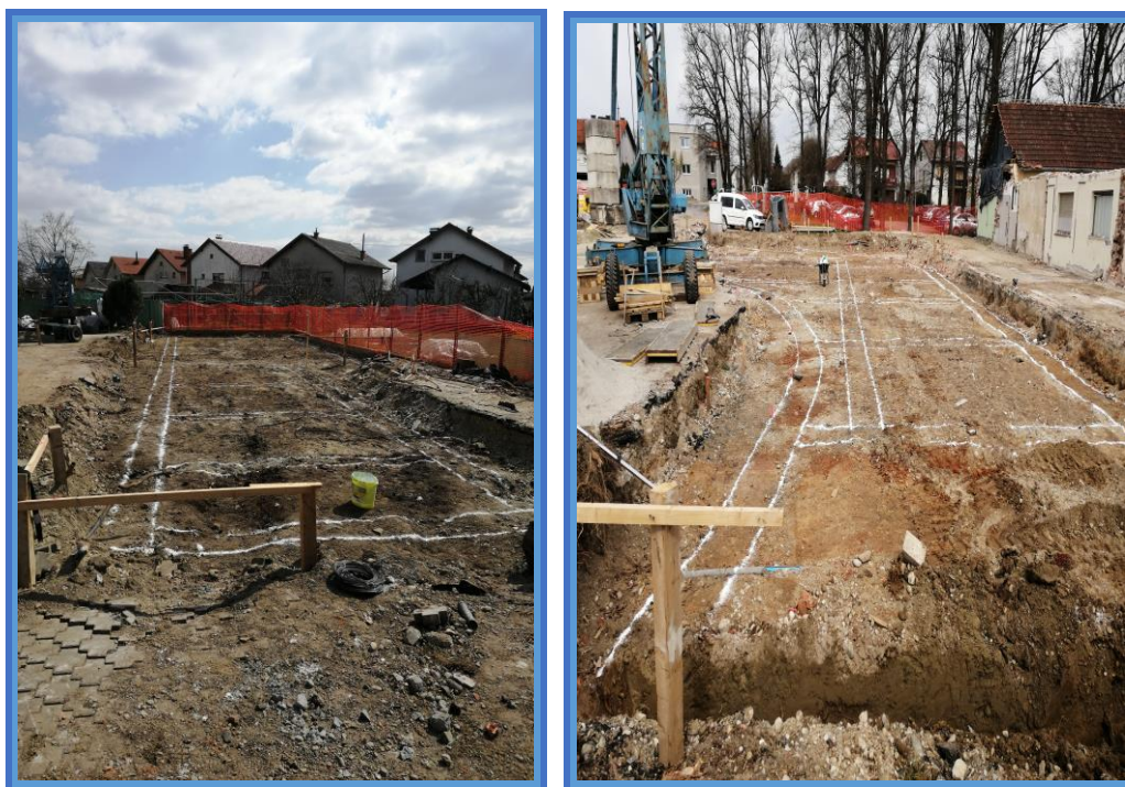
Slika 11. i 12. Zacrtavanje temeljnih traka [8].
