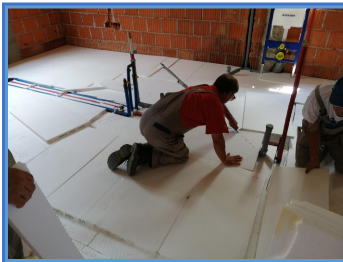
Slika 39. Polaganje EPS-a na podnu ploču [8].
