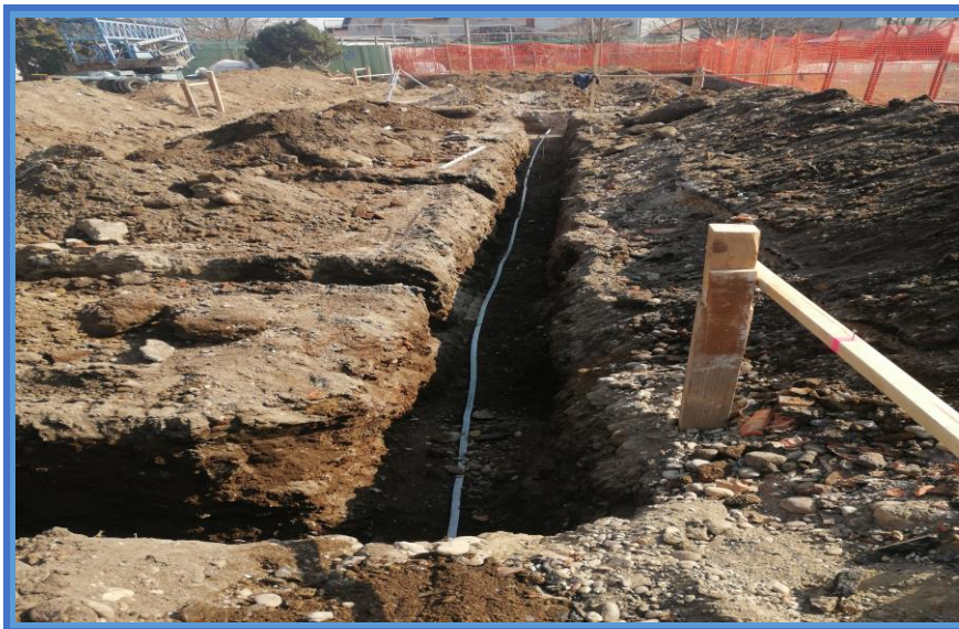
Slika 13. Iskop temeljnih traka-zgrada 2 [8].
