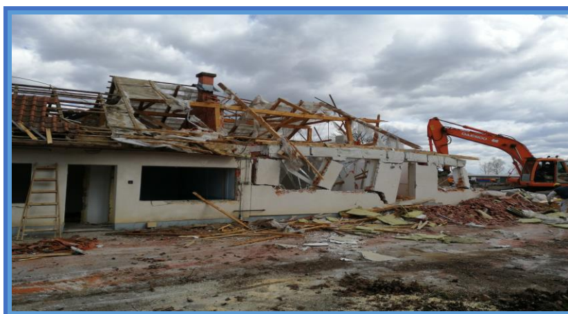
Slika 7. Rušenje postojećih zgrada na parceli [8].
