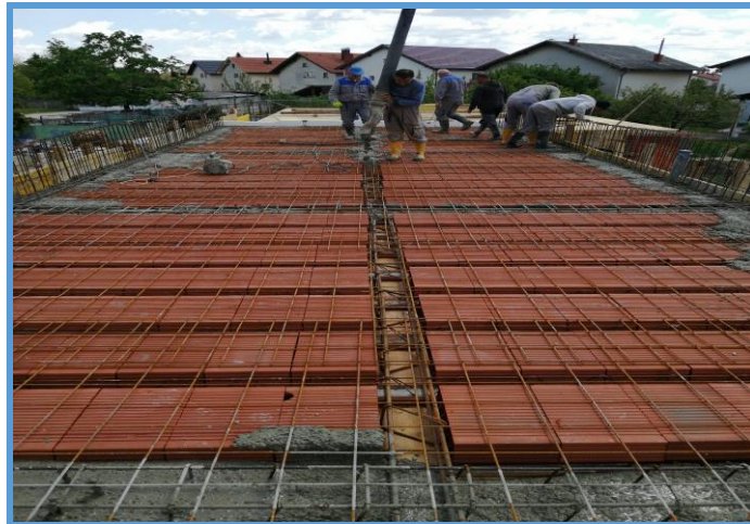
Slika 28. Armiranje i betoniranje fert stropa – zgrada 2 [2].
