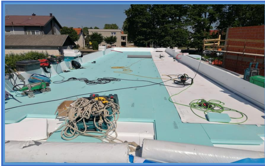
Slika 40. Postavljanje TPO membrane [8].
