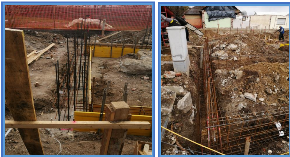
Slika 30. i 31. Armatura nadtemeljnih serklaža [8].
