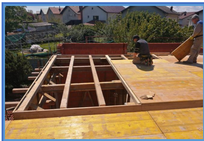
Slika 35. Šalovanje AB stropne ploče prizemlja [8].
