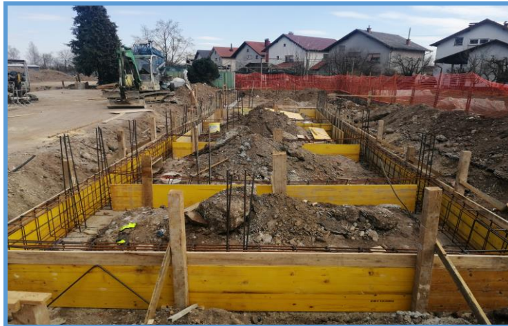
Slika 22. Betoniranje nadtemeljnih serklaža – zgrada 2 [8].
