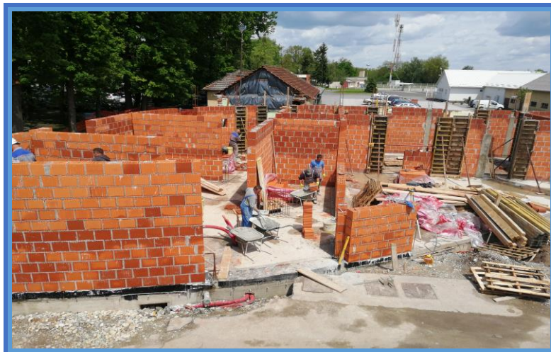
Slika 44. Zidanje nosivih zidova prizemlja – zgrada 1 [8].
