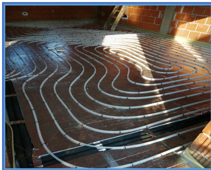
Slika 56. Postava cijevi za podno grijanje [8].
