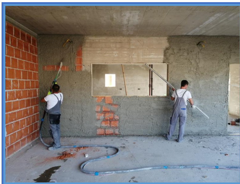
Slika 45. Strojno žbukanje zidova – zgrada 1 [8].
