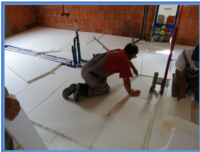
Slika 39. Polaganje EPS-a na podnu ploču [8].
