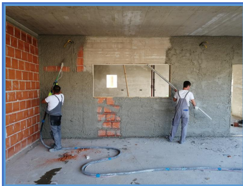
Slika 45. Strojno žbukanje zidova – zgrada 1 [8].
