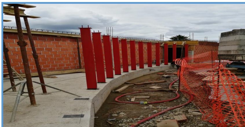
Slika 46. Postavljanje čeličnih stupova nosača fiksne ostakljene stijene [8].
