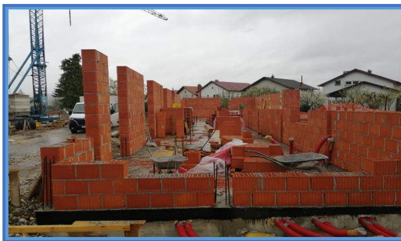
Slika 43. Zidanje nosivih zidova prizemlja – zgrada 2 [8].
