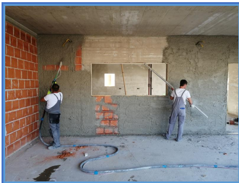
Slika 45. Strojno žbukanje zidova – zgrada 1 [8].
