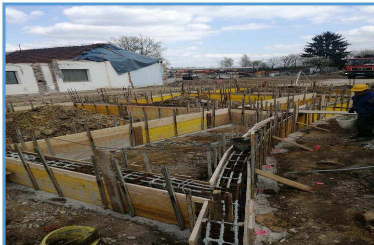
Slika 23. Betoniranje nadtemeljnih serklaža – zgrada 1 [8].
