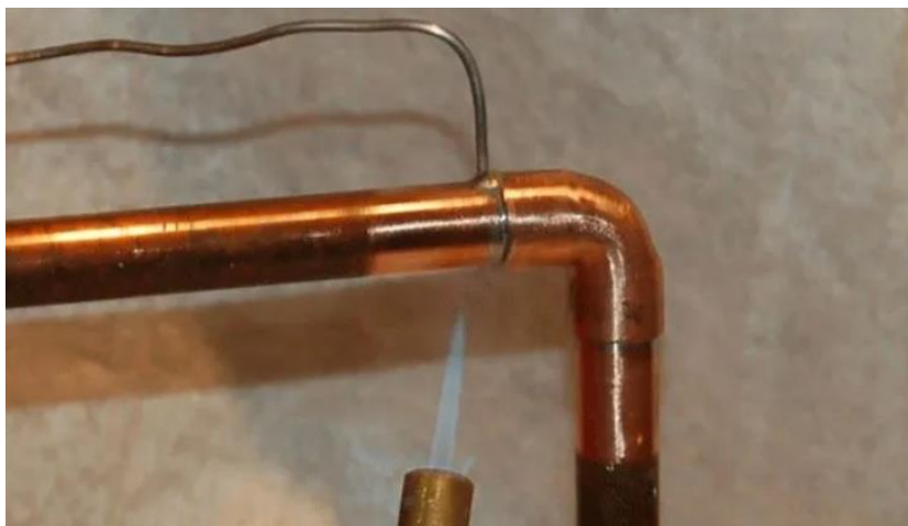
Slika 6.4. Tvrdo lemljenje koljenastog spoja
