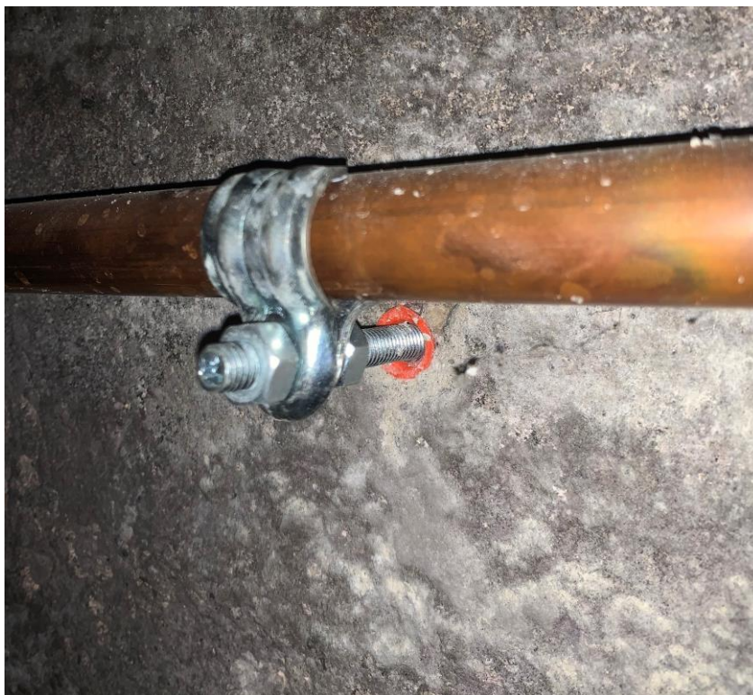
Slika 6.2. Prikaz cijevnih objumica, (Ivan Podravec-2.3.2023.)
