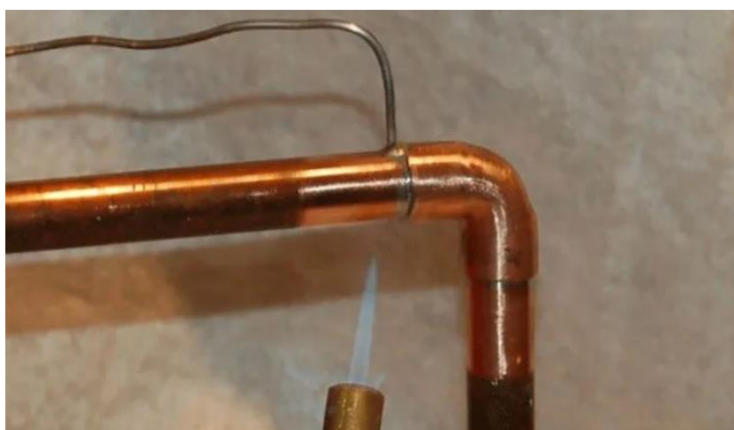
Slika 6.4. Tvrdo lemljenje koljenastog spoja
