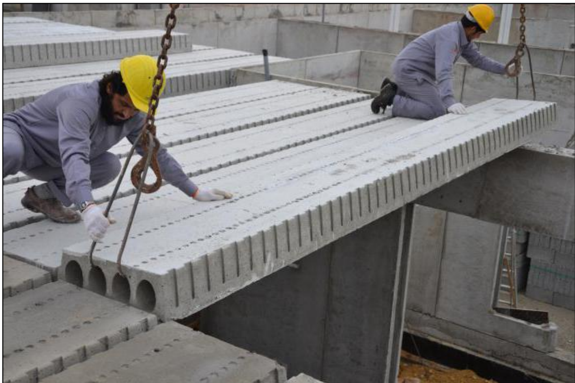
Slika 10:Šuplje prednapregnute stropne ploče - montaža (izvor: https://hr.puntomarinero.com/hollow-floor-slabs-gost-dimensions/ , pregledano 20.10.2022.)
