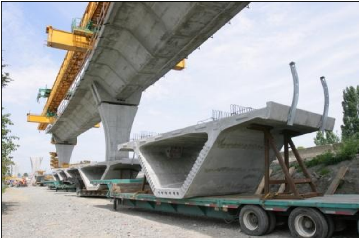
Slika 3: Doprema prefabriciranog sandučastog nosača mosta na lokaciju ugradnje (izvor: https://www.gradjevinarstvo.rs/tekstovi/5445/820/betonski-segmentni-mostovi , pregledano 20.10.2022.)
