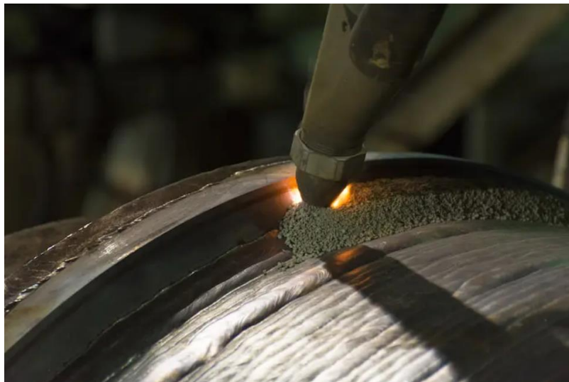
Slika 2.3.: Elektrolučno zavarivanje pod zaštitom praška [6]
