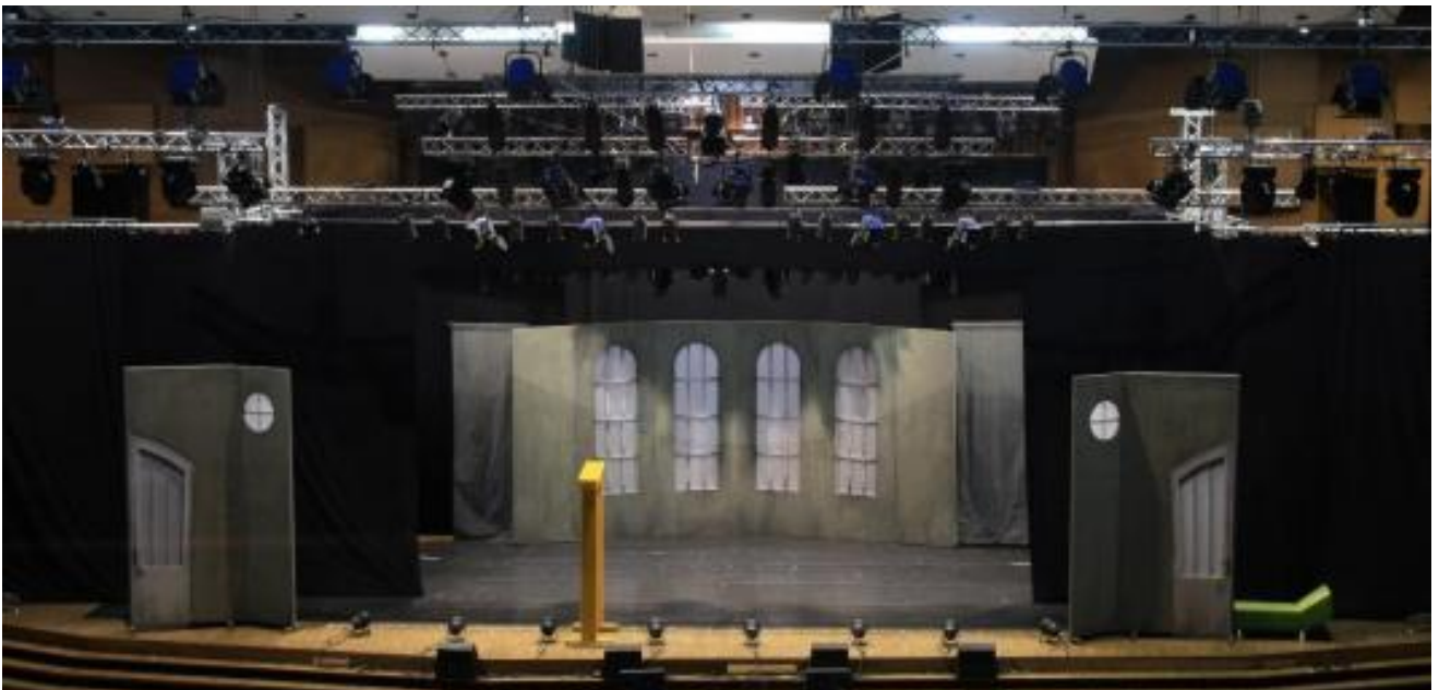
Slika. 3.9. Prikaz primjene aluminijskih nosača (cugovi i rampe) za mjuzikl „Pacijenti“
