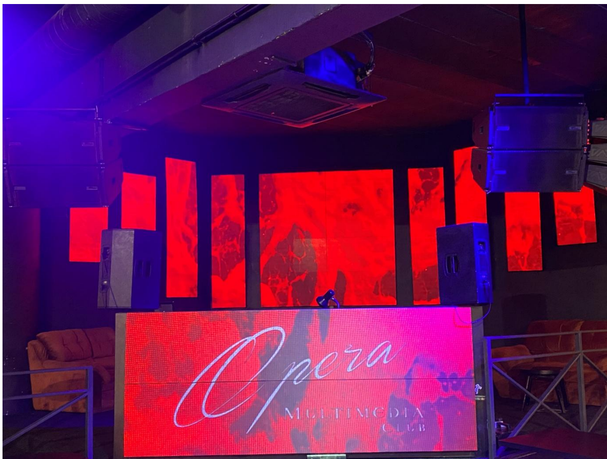
Slika. 7.2. Raspored elemenata LED video zida
