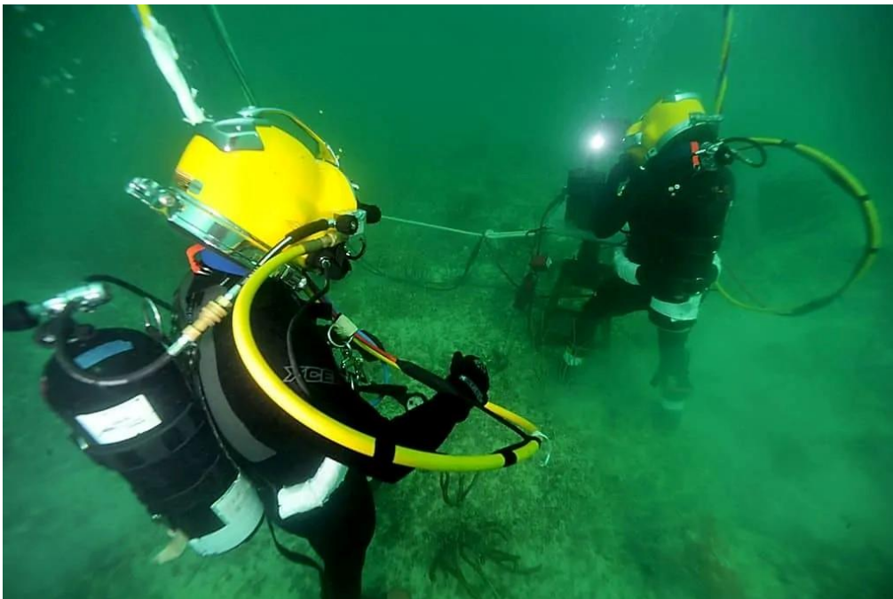
Slika 5. Mokro podvodno zavarivanje REL obloženom elektrodom [7]
