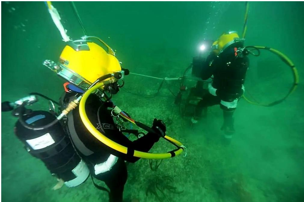
Slika 5. Mokro podvodno zavarivanje REL obloženom elektrodom [7]
