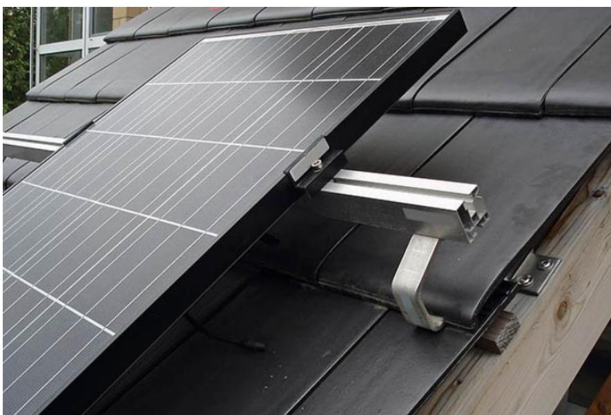
*Slika 6. Konstrukcijski elementi za postavljanje panela na krov prekriven crijepom [14].*
