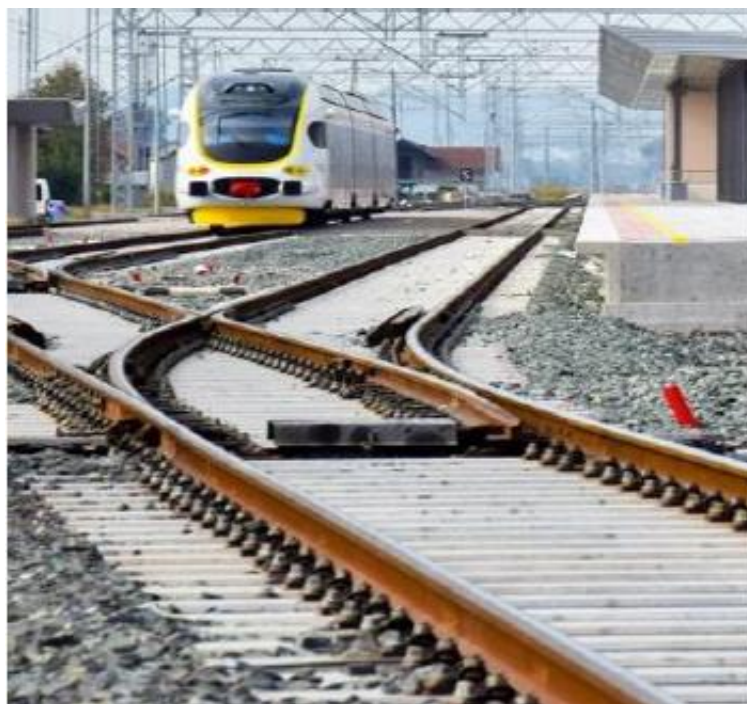
Sl. 4.4.1. Željeznička pruga- nosač na elastičnoj podlozi [19]
