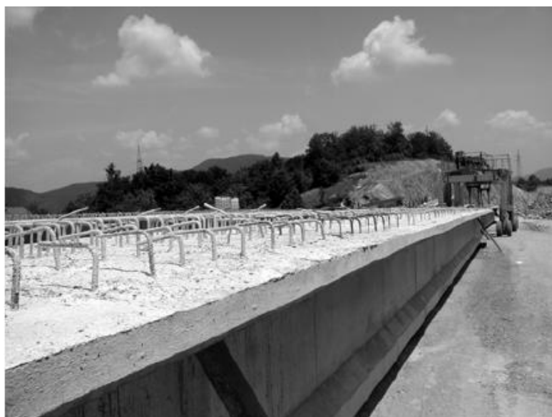
Sl.2.2.1. Proizvodnja predgotovljenih elemenata na gradilištu [12]
