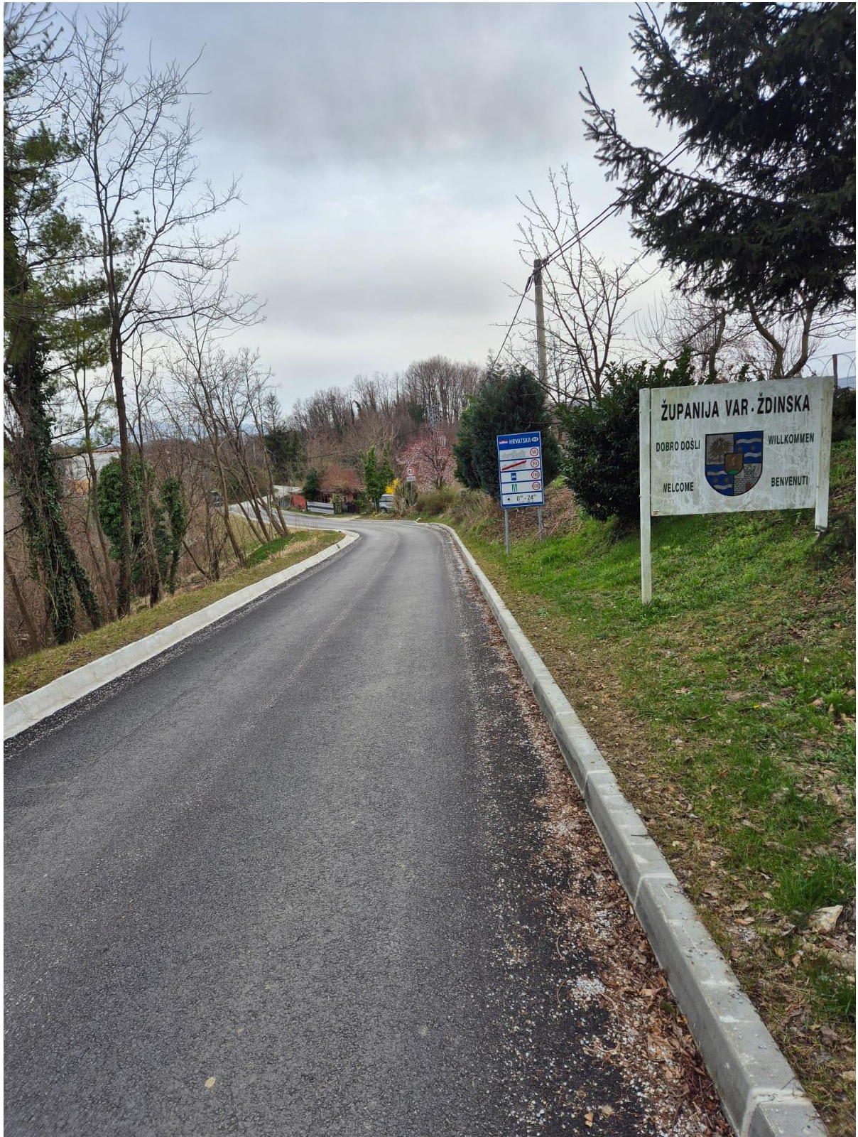
Slika.31. prikaz sadašnjeg stanja saniranog klizišta 1
