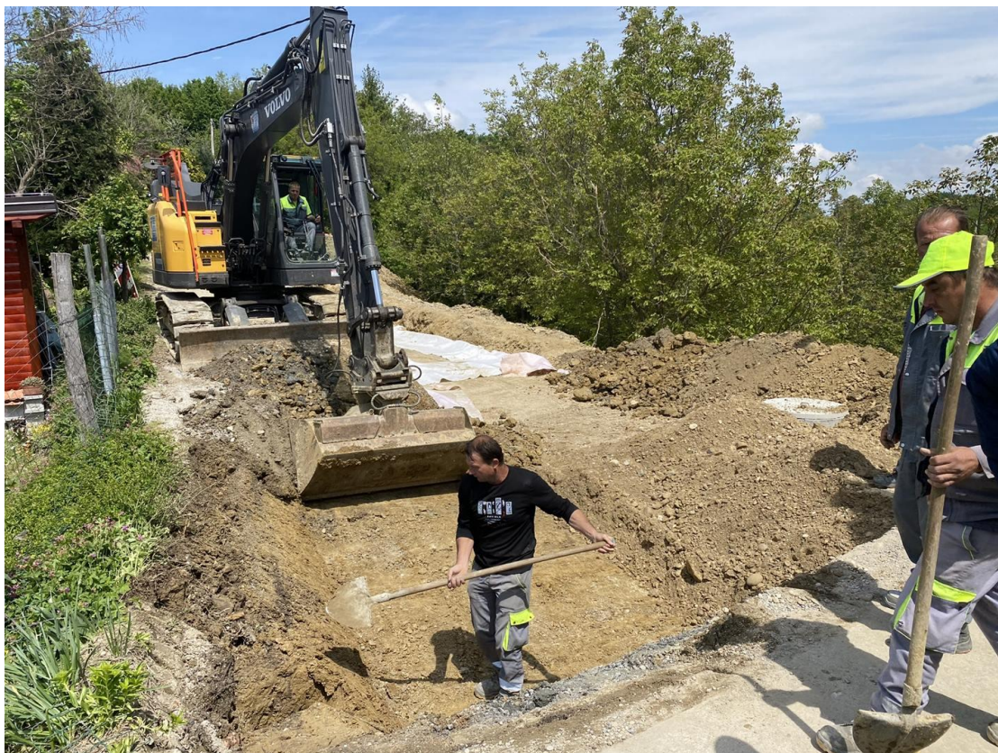
Slika.27. Ugradnja nosivog materijala u kolničku konstrukciju 1
