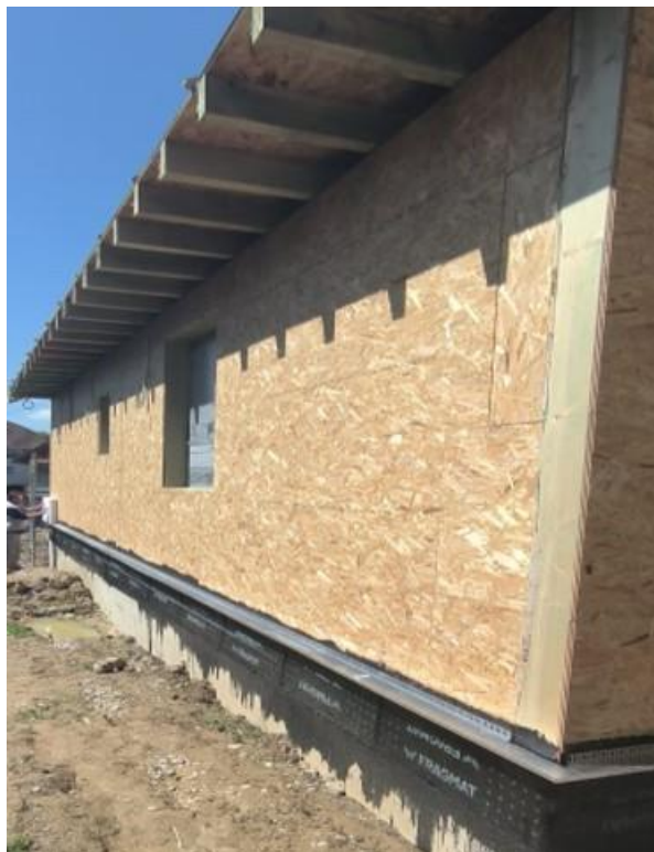
Slika 3. Prikaz vanjskog sloja montažne kuće od drveta
