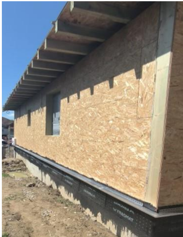
Slika 3. Prikaz vanjskog sloja montažne kuće od drveta
