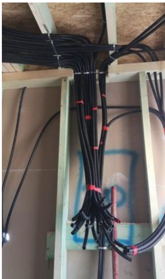
Slika 9. Prikaz postavljanja glavnih vodova i kablova
