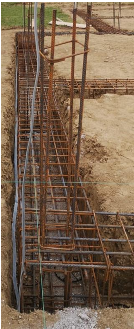
Slika 8. Postavljanje temeljnog uzemljivača u rov
