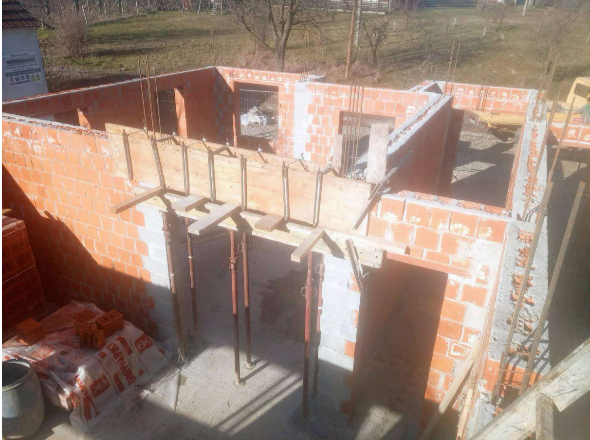
Slika 3.5.1. Prikaz montirane oplata
