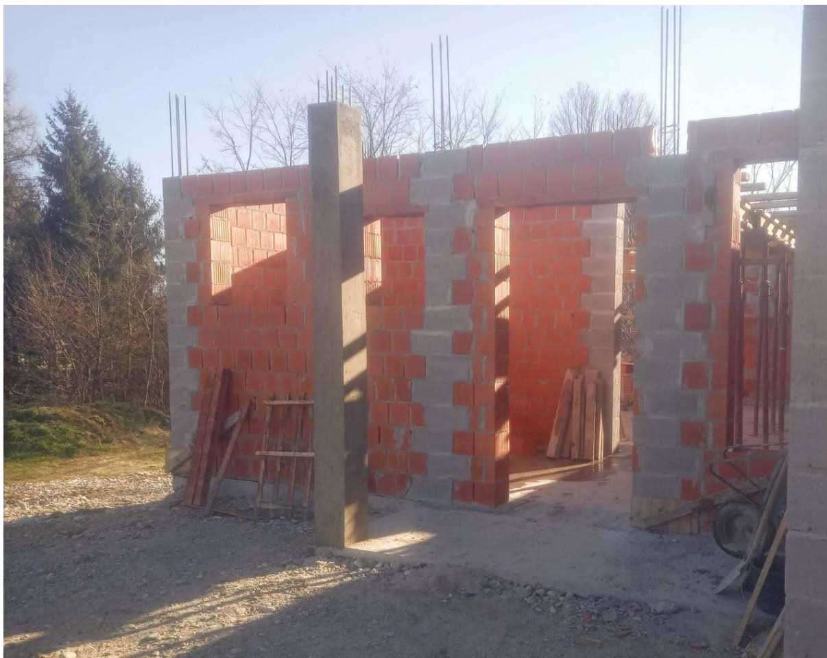
Slika 3.2.2. Betoniranje stupa
