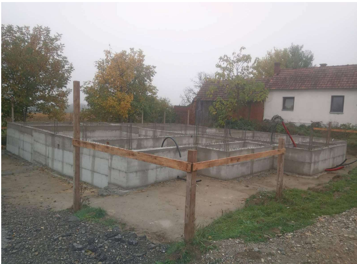
Slika 3.2.1. Betoniranje nadtemeljnih serklaža
