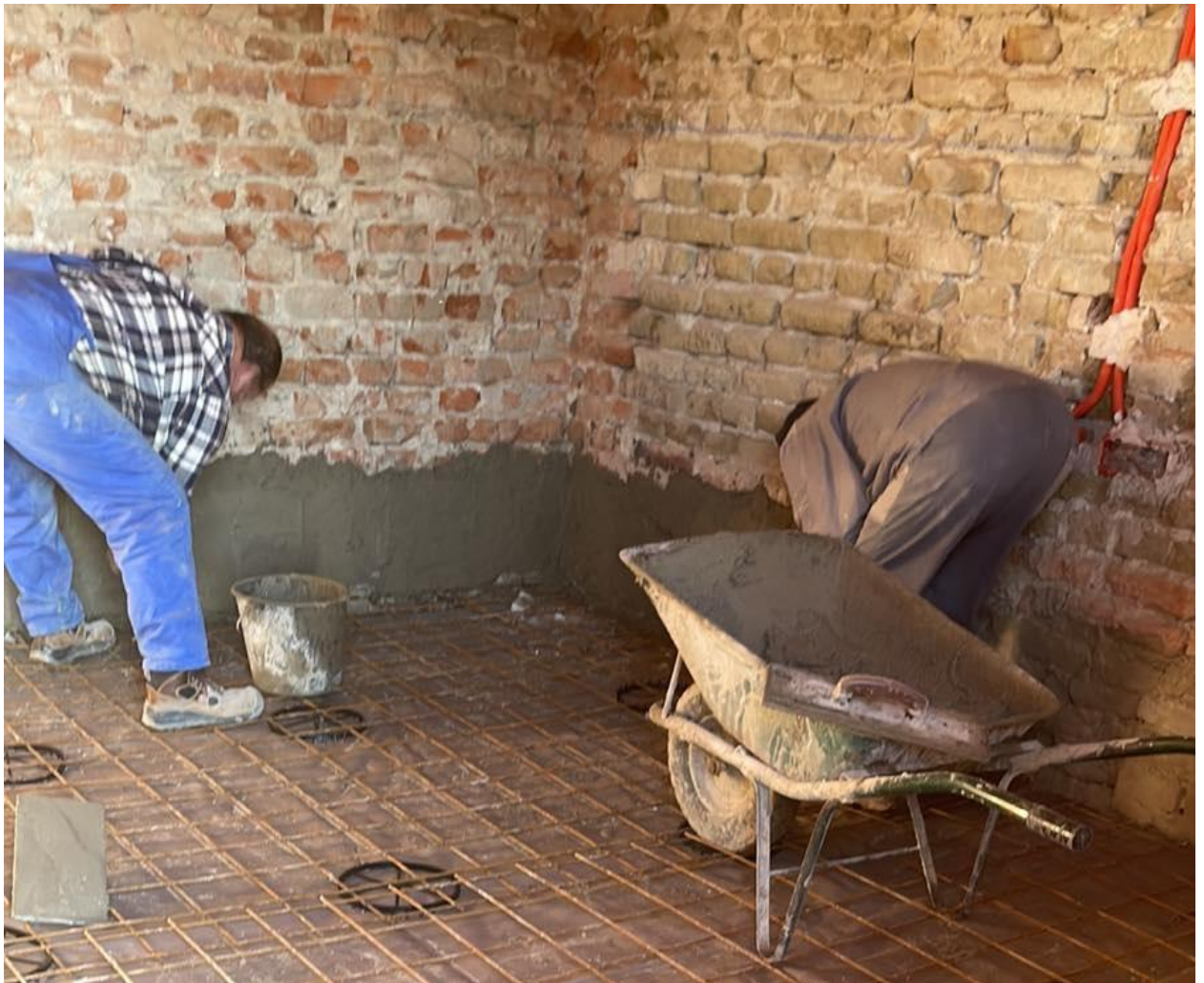
Slika 4.16 – Ručno nanošenje hidroizolacije
