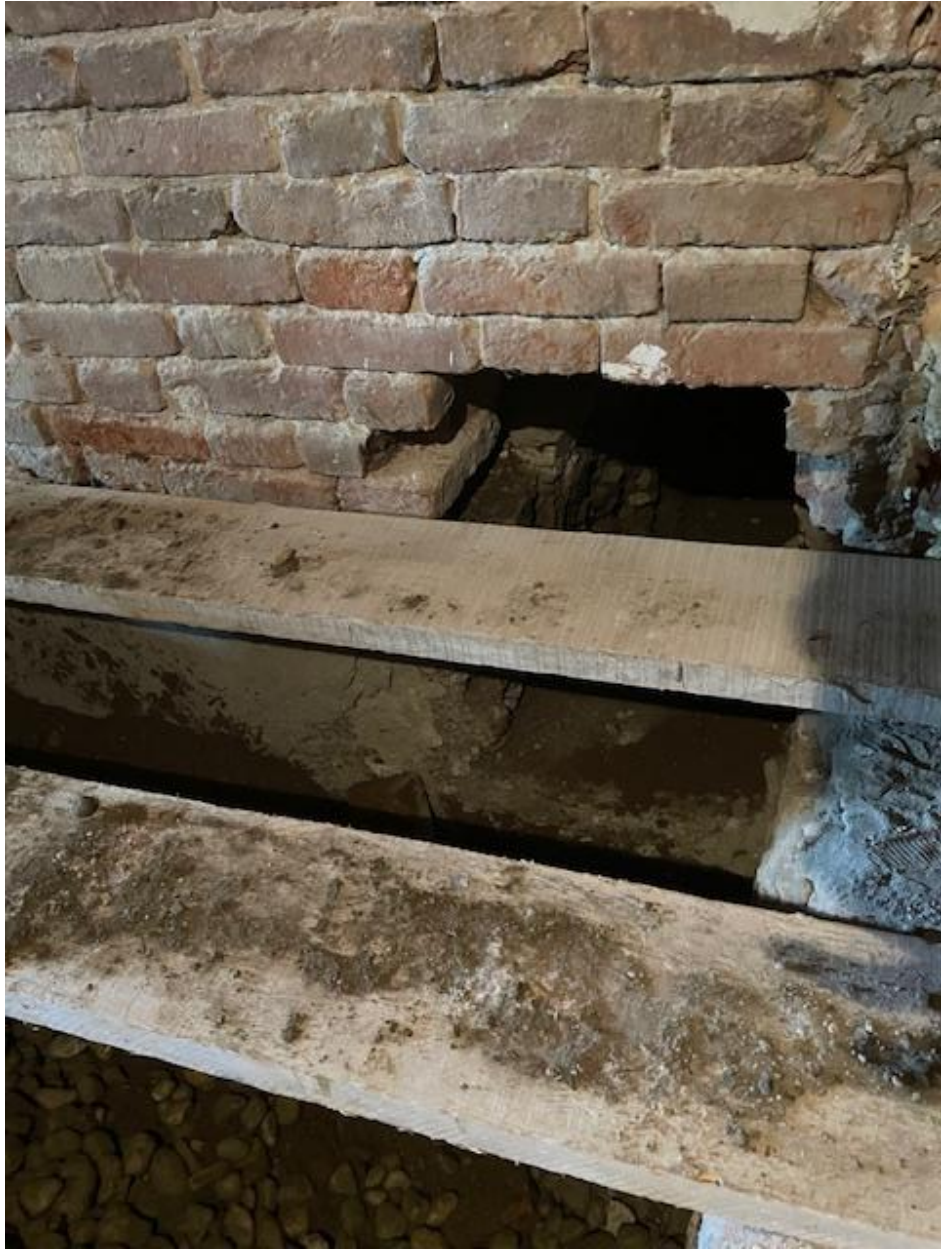
Slika 4.5 – Izrada temelja ispod postojećeg zida
