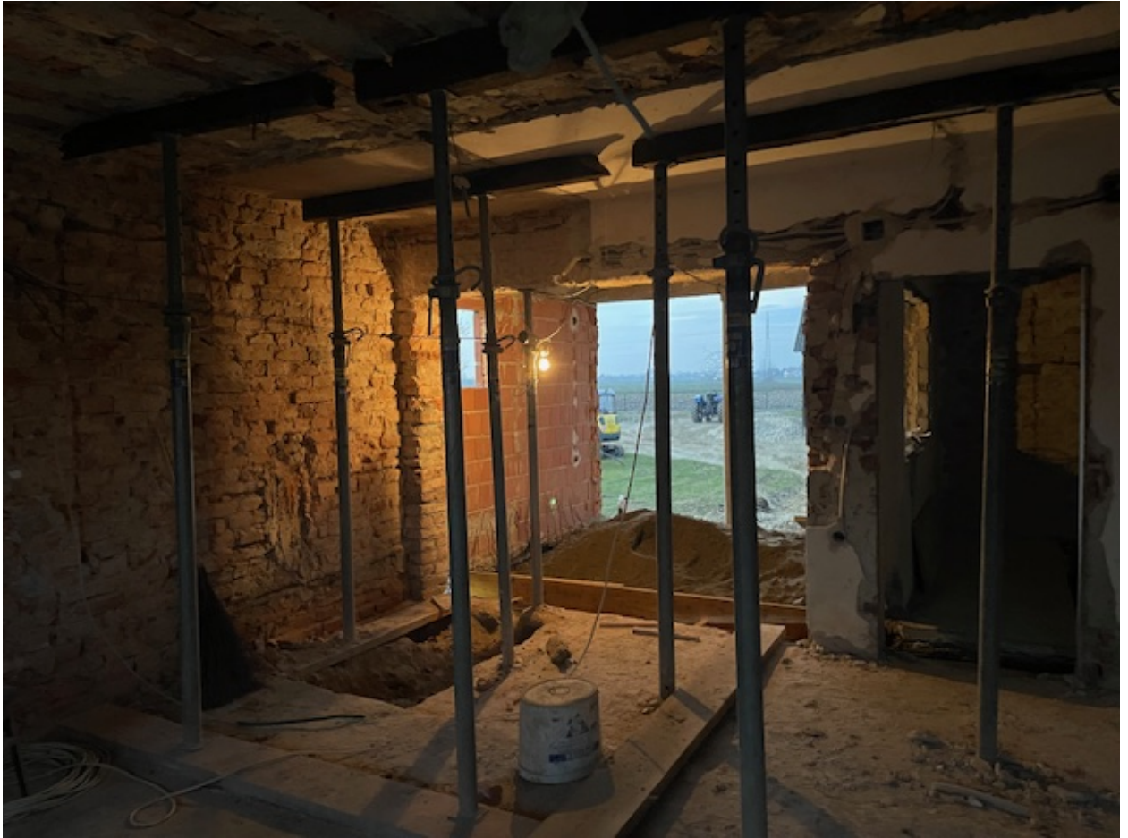
Slika 4.7 – Podupiranje postojeće konstrukcije
