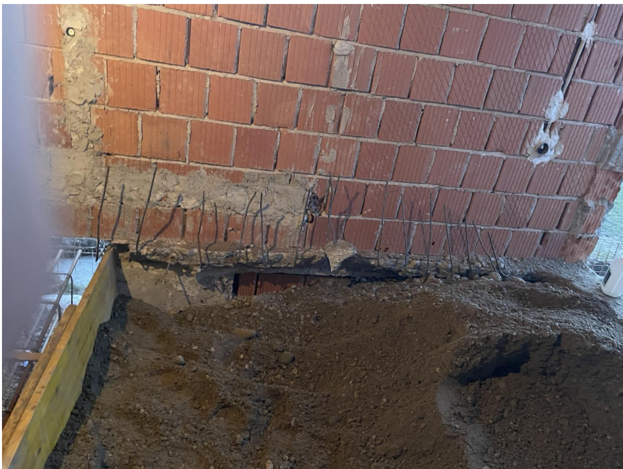
Slika 4.14 – Ispuna „slijepog podruma“ – drugi dio
