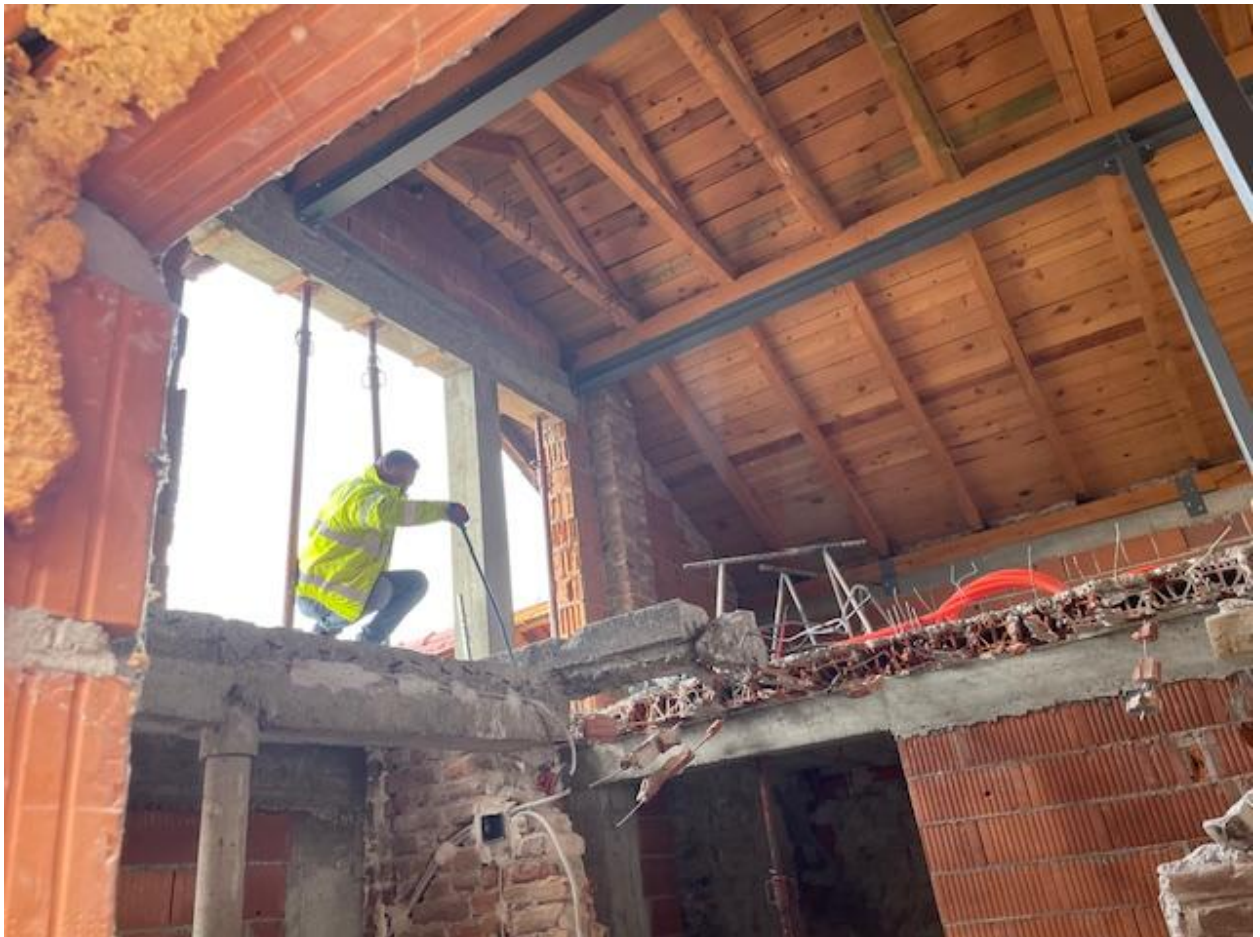
Slika 4.20 – Rušenje stropa
