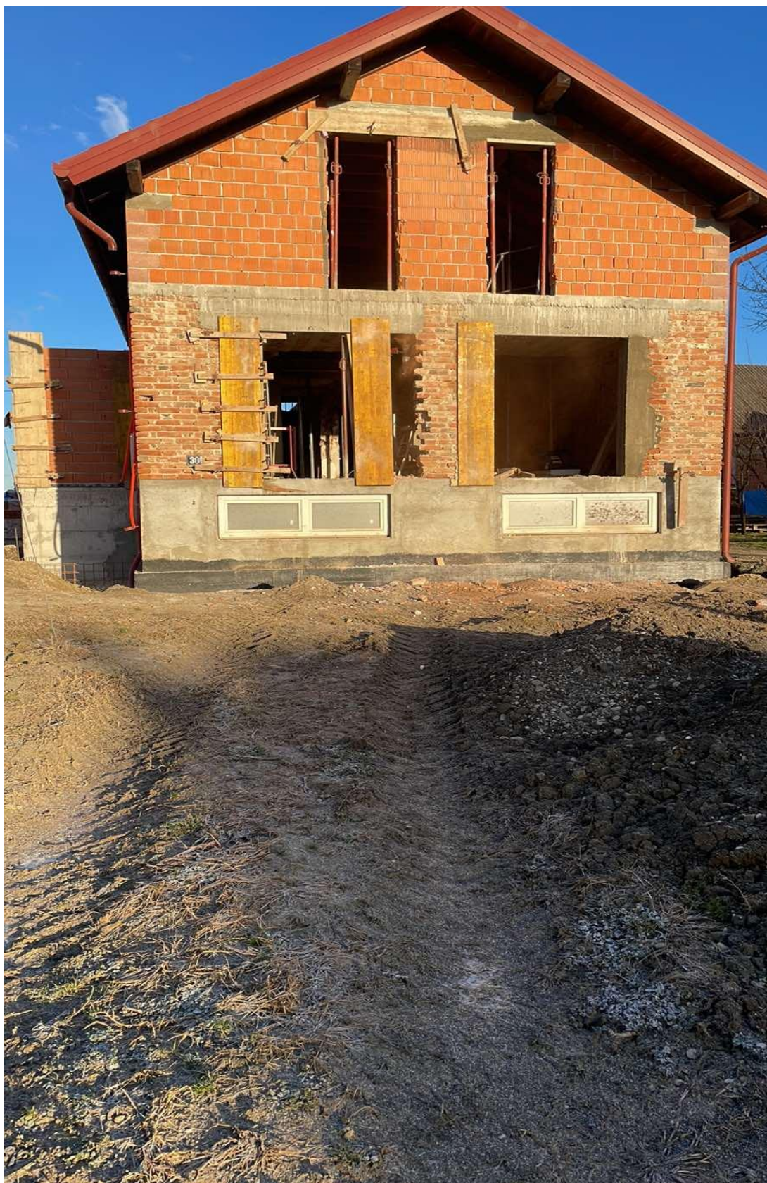
Slika 4.19 – Betoniranje vertikalnih i horizontalnih serklaža
