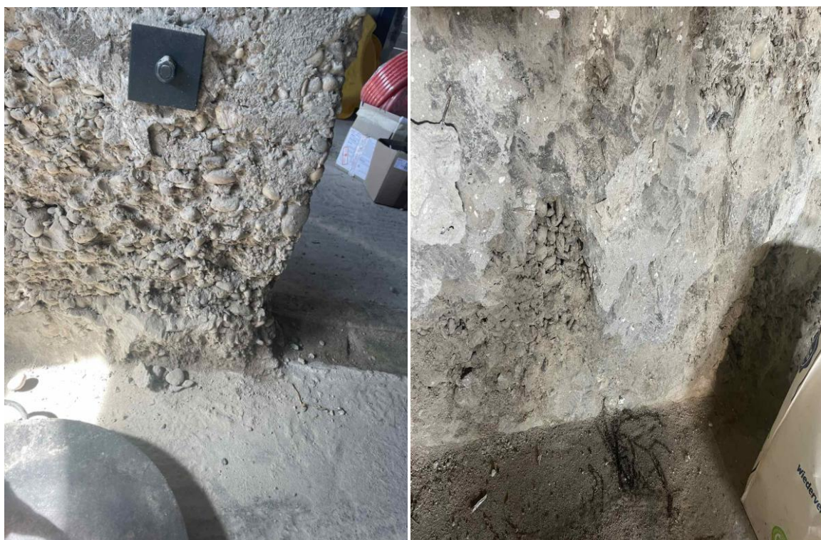
Slika 3.3 – Tragovi vlage
