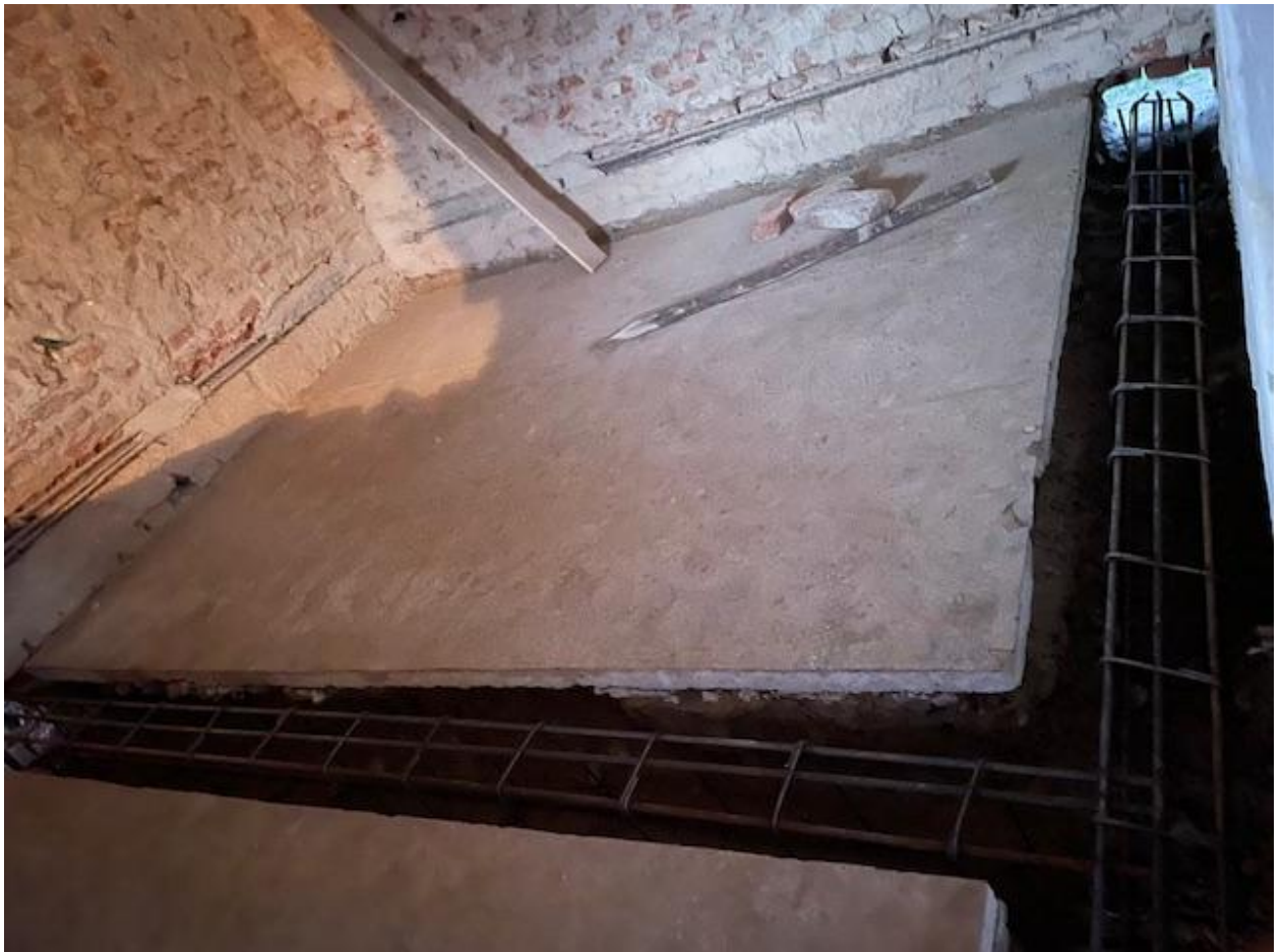
Slika 4.4 – Izrada trakastog temelja
