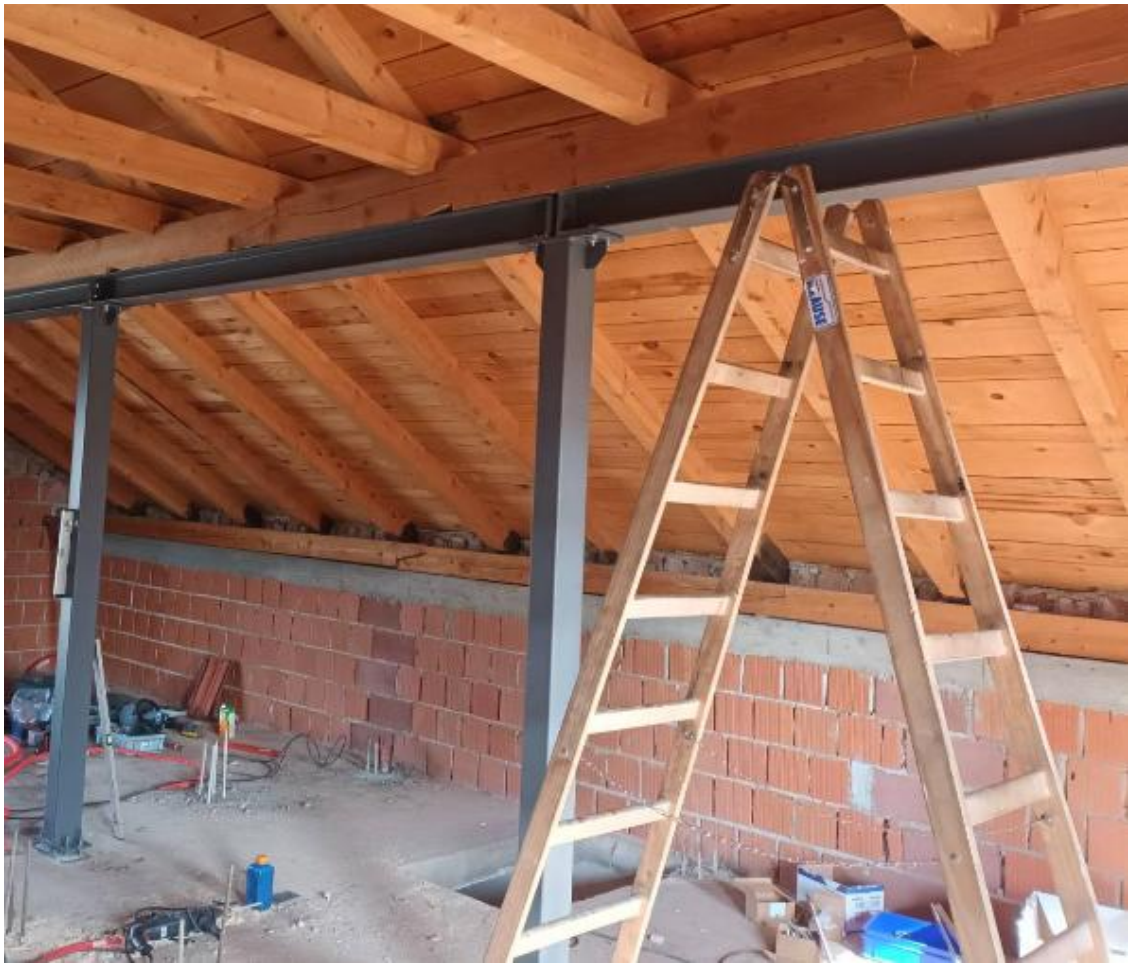
Slika 6.16 – Postavljeni HEA profili
