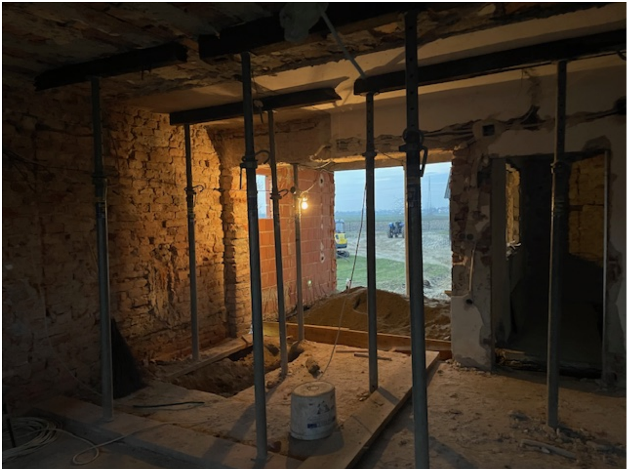
Slika 4.7 – Podupiranje postojeće konstrukcije
