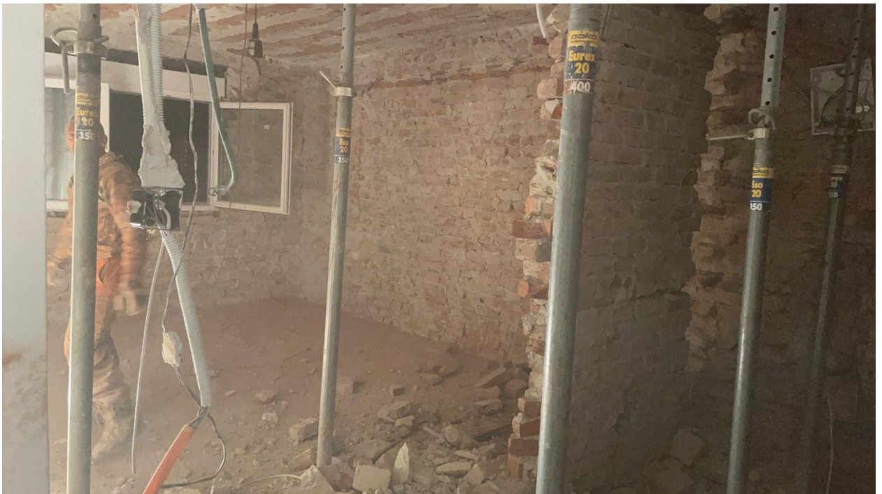
Slika 4.7 – Podupiranje postojeće konstrukcije
