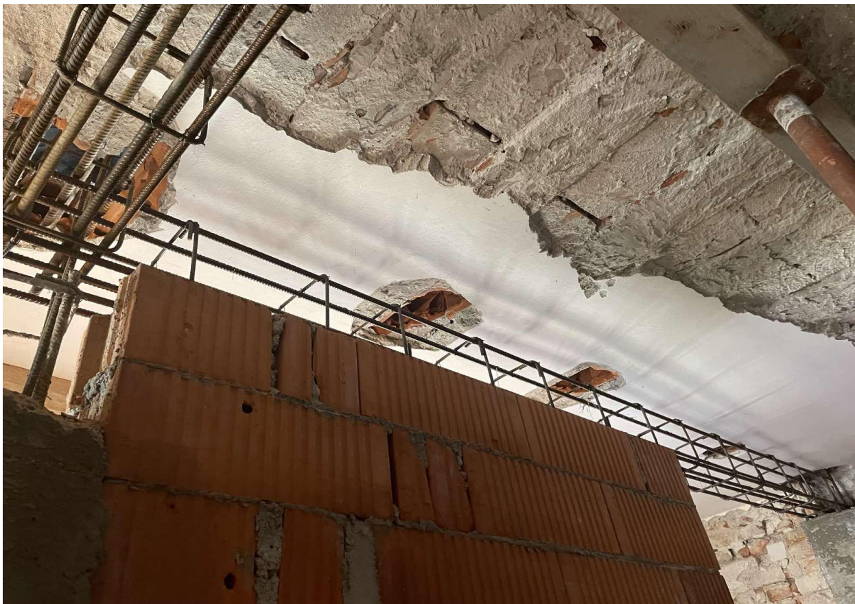
Slika 4.10 – Greda novog nosivog zida
