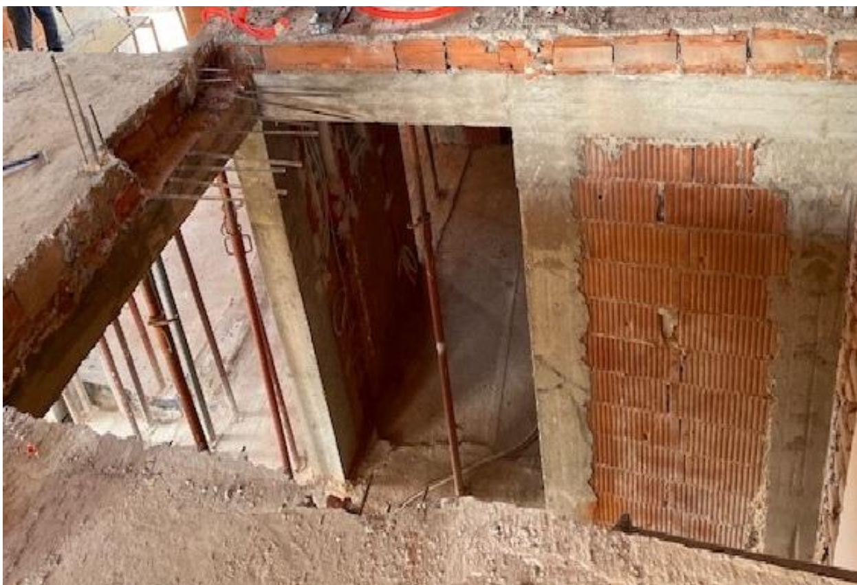
Slika 4.10 – Greda novog nosivog zida
