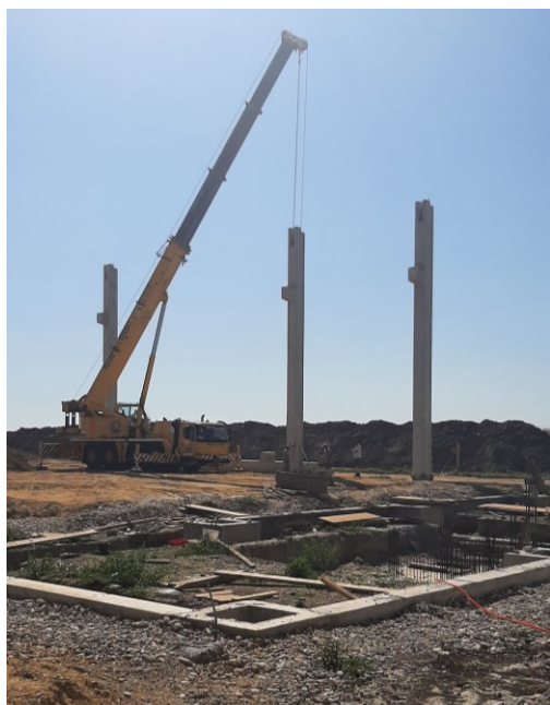
Slika 11 Montaža stupova
