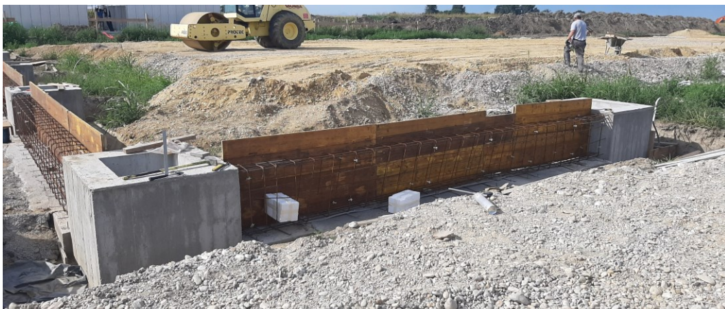
Slika 7 Priprema za betoniranje
