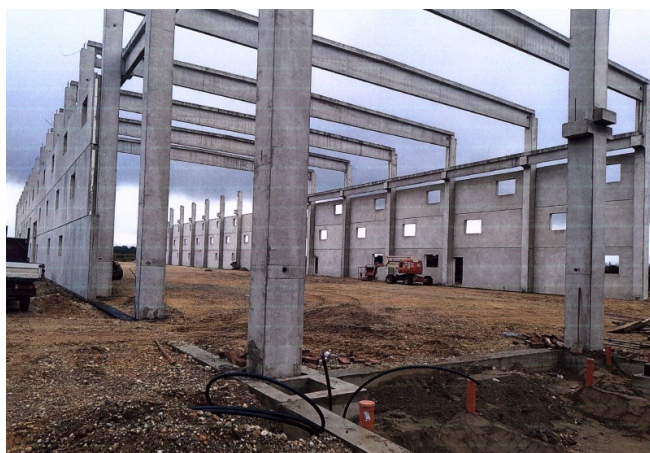
Slika 14 Prikaz postavljenih krovnih greda
