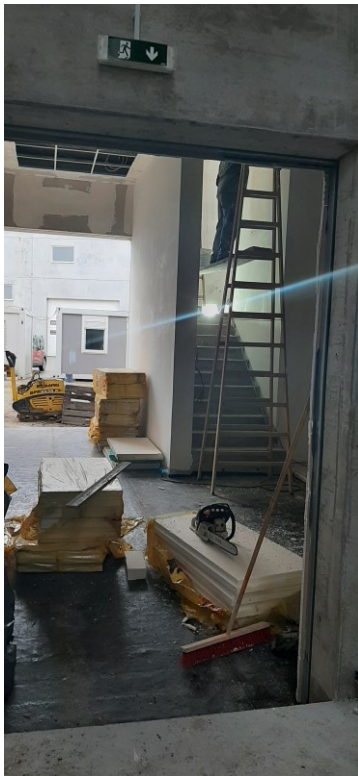
Slika 22 Toplinska izolacija podova
