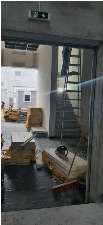
Slika 22 Toplinska izolacija podova
