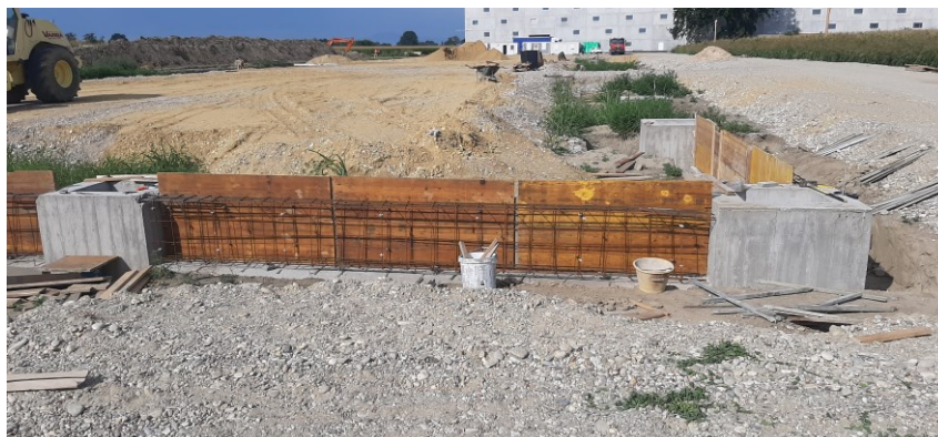
Slika 16 Oplata za betoniranje temeljnih traka
