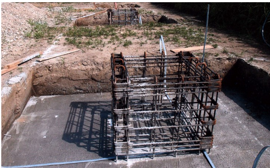
Slika 6 Betoniranje temeljnih stopa
