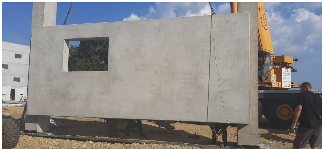
Slika 13 Montaža panela
