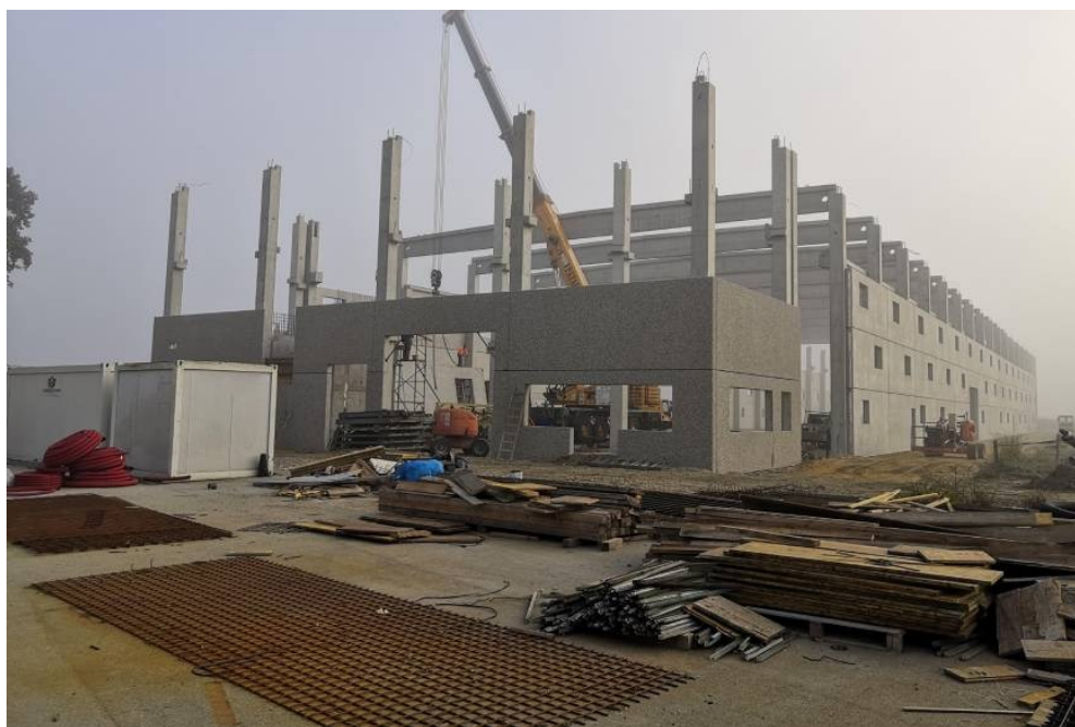
Slika 2 Prikaz građevine u procesu izgradnje
