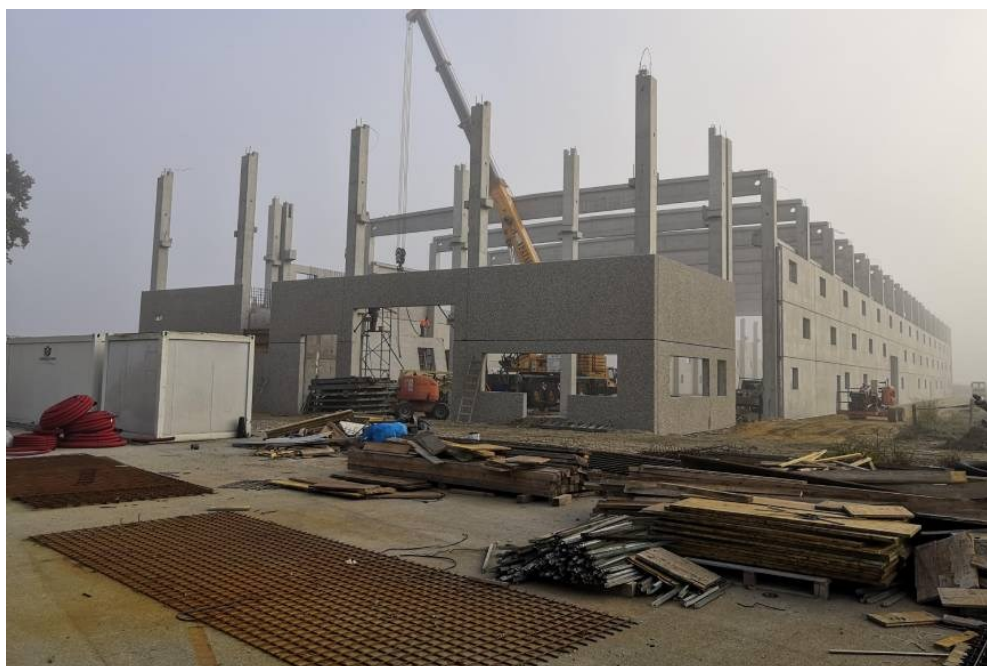
Slika 2 Prikaz građevine u procesu izgradnje
