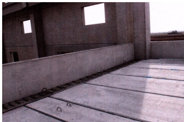
Slika 15 Šuplje stropne ploče
