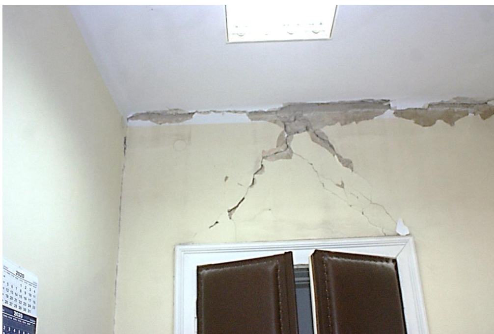
Slika 5.11 Prostorija 3. Oštećenje nadvoja
