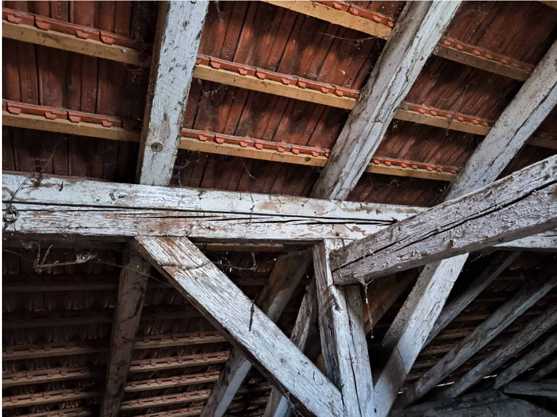
Slika 26. Detaljan prikaz drvenih greda i poprečnih elemenata
