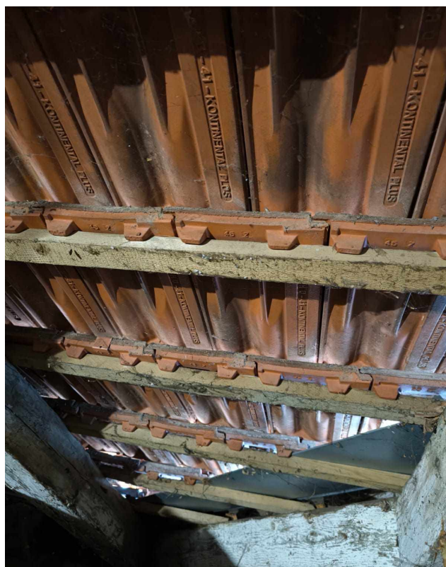
Slika 28. Detaljan prikaz novih letva
