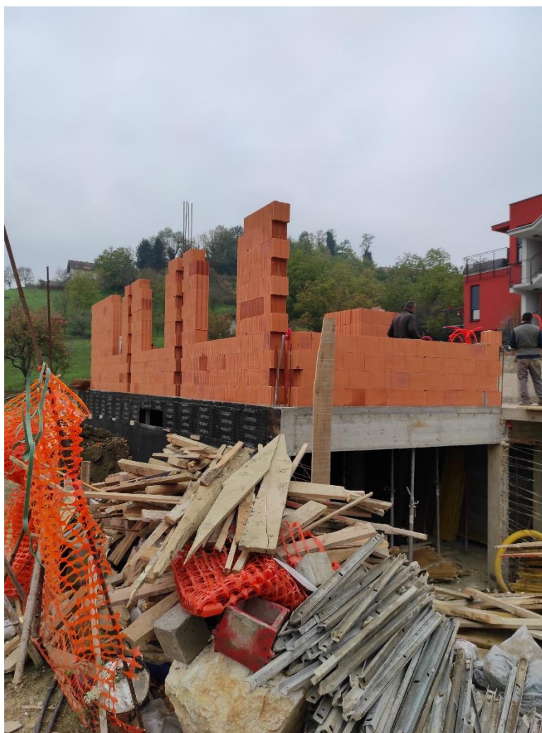
Slika 3.6.1. Zidanje opekom tipa Wienerberger Profi 25
