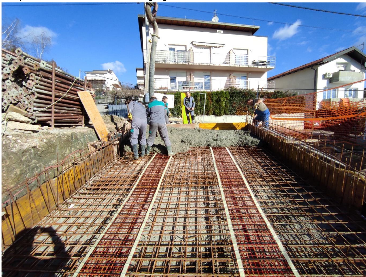
Slika 3.5.1.1. Betoniranje temeljne ploče
