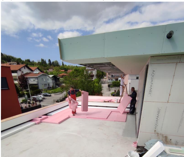
Slika 3.7.3.1. Polaganje ploče XPS
