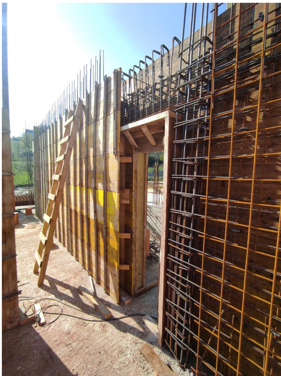
Slika 3.3.2. Postavljanje oplata za AB zidove
