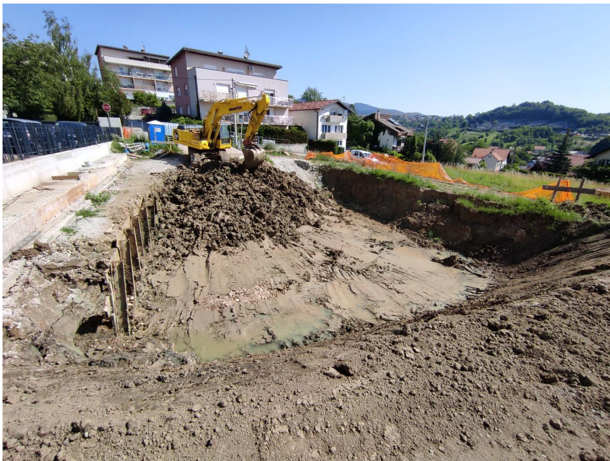
Slika 3.2.1.1. Strojni iskop građevinske jame
