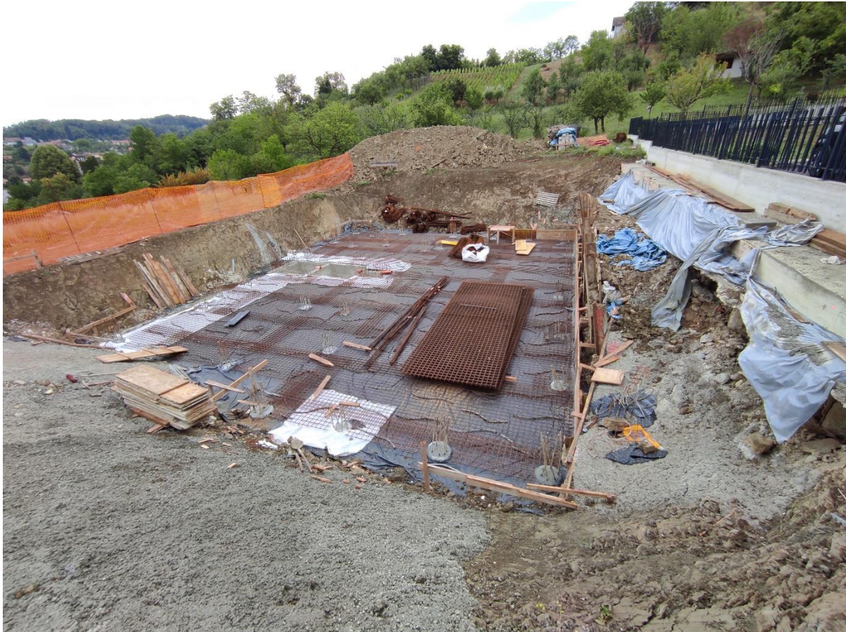
Slika 3.4.1. Postavljanje armature za temeljnu ploču
