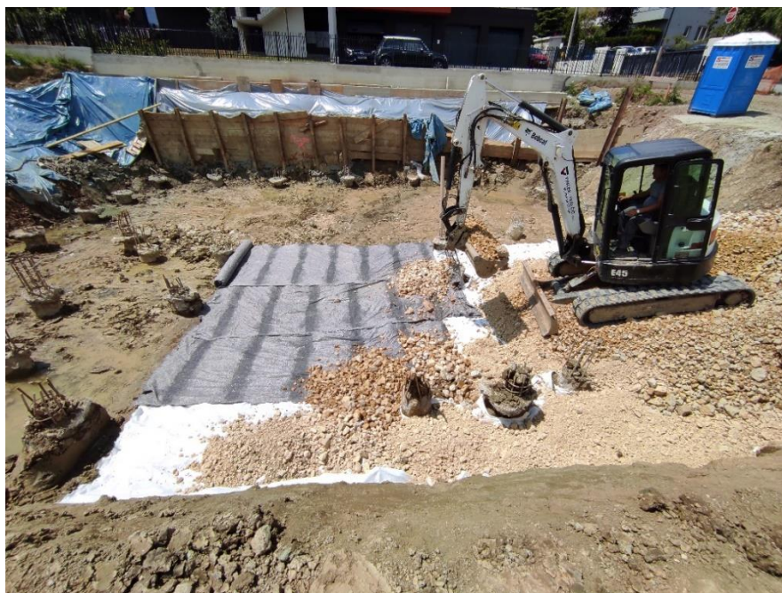
Slika 3.2.5.1. Ugradnja kamenog agregata
