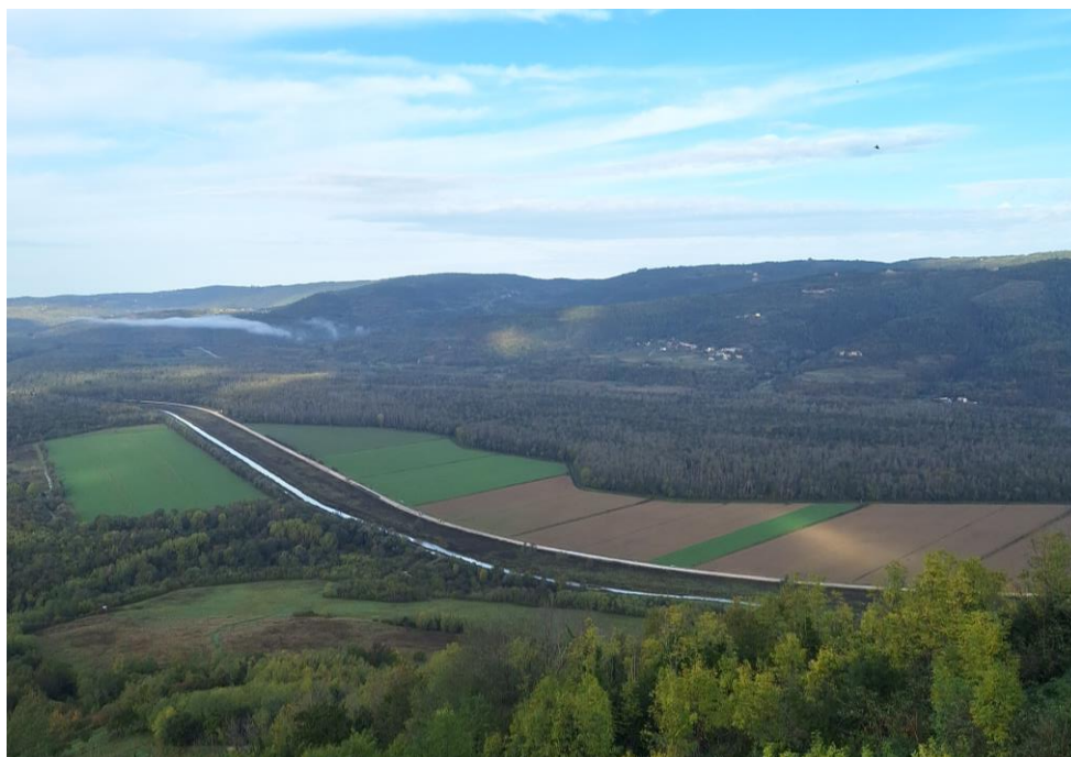
Slika 3.2. Primjer umjetnog vodotoka – regulirana rijeka Mirna [5]
