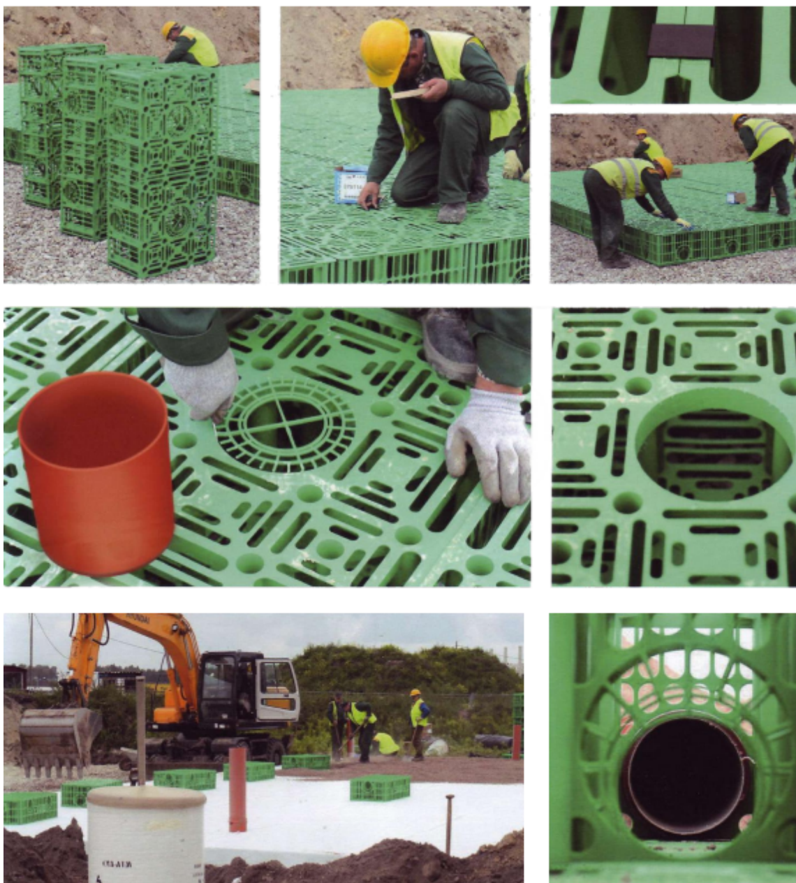
Slika 23. Proces montaže sustava Stormbox-a
