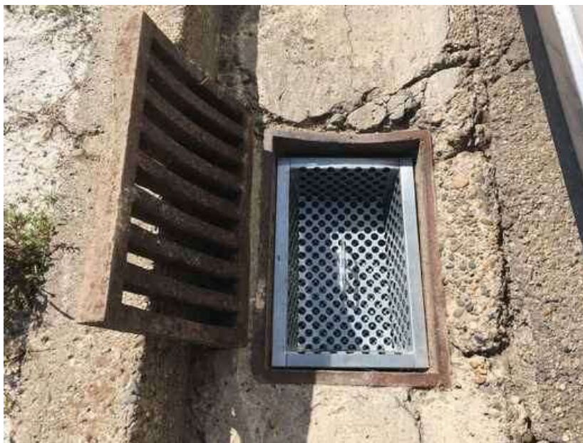
Slika 10. Sugarfilter - Filter za oborinske odvode
