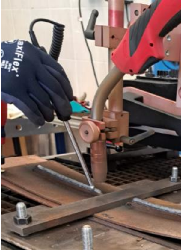
Slika 32 Mjerenje međuprolazne temperature
