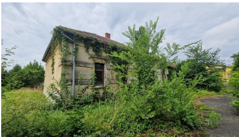
Slika 17. Zapadno pročelje testne građevine
