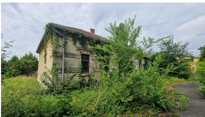
Slika 17. Zapadno pročelje testne građevine
