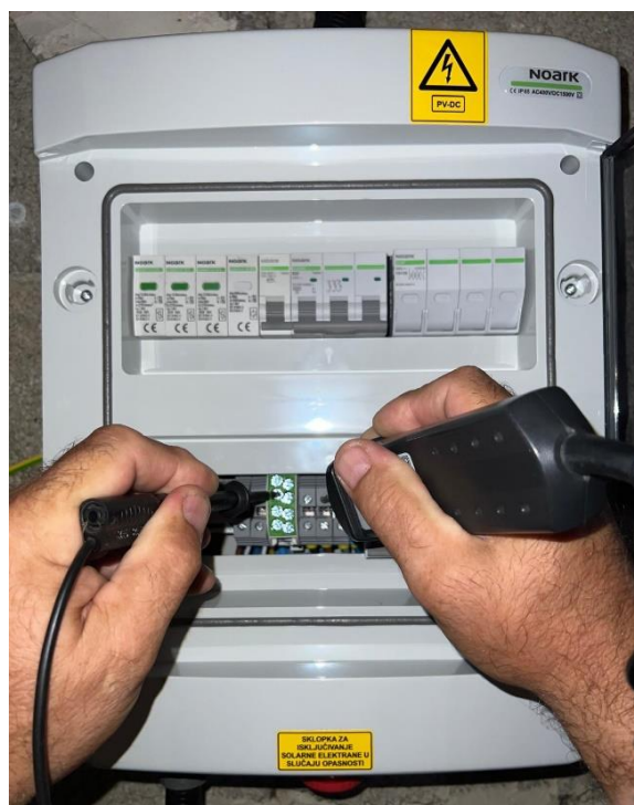
Slika 5.6. Ispitivanje otpora uzemljenja
