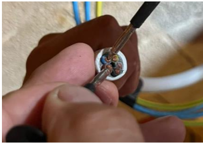
Slika 5.3. Ispitivanje izolacijskog otpora vodiča
