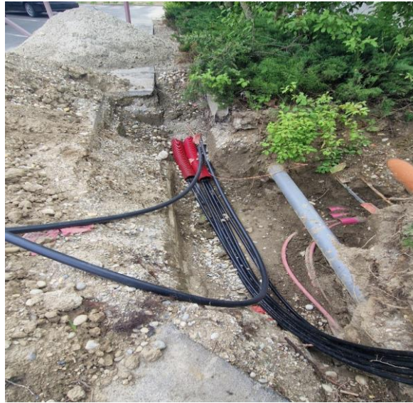
Slika 22. SN kableski vod prije spajanja
