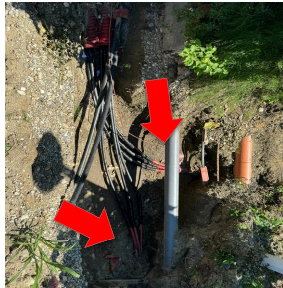
Slika 24. SN kableski vod nakon spajanja (2)
