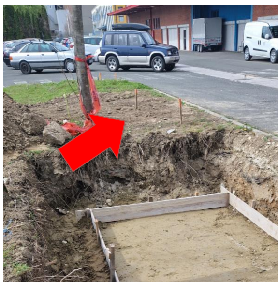
Slika 5. Iskolčenje kablenske trase
