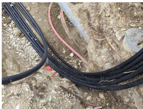
Slika 20. Kabel NA2XS(F)2Y (1x185RM/25mm 2 ) položen u kabelski rov
