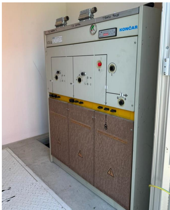
Slika 12. SN sklopni blok VDAΣ 24-2VT
