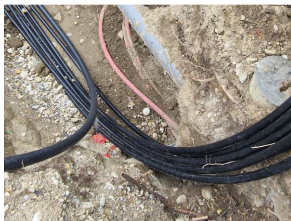
Slika 20. Kabel NA2XS(F)2Y (1x185RM/25mm 2 ) položen u kabljski rov
