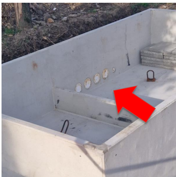
Slika 8. Otvori za uvođenje vodova
