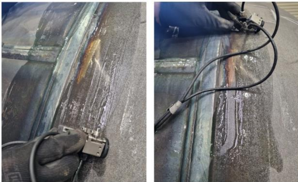
Slika 5.36 Vođenje sonde prilikom skeniranja zavara [28]
