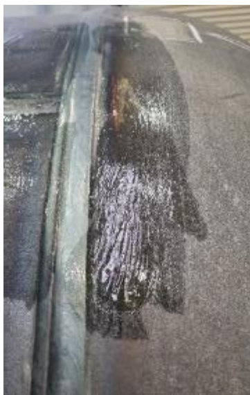
Slika 5.2 Sučeljeni V-zavar na plaštu regeneratora-izmjenjivača topline [28]
