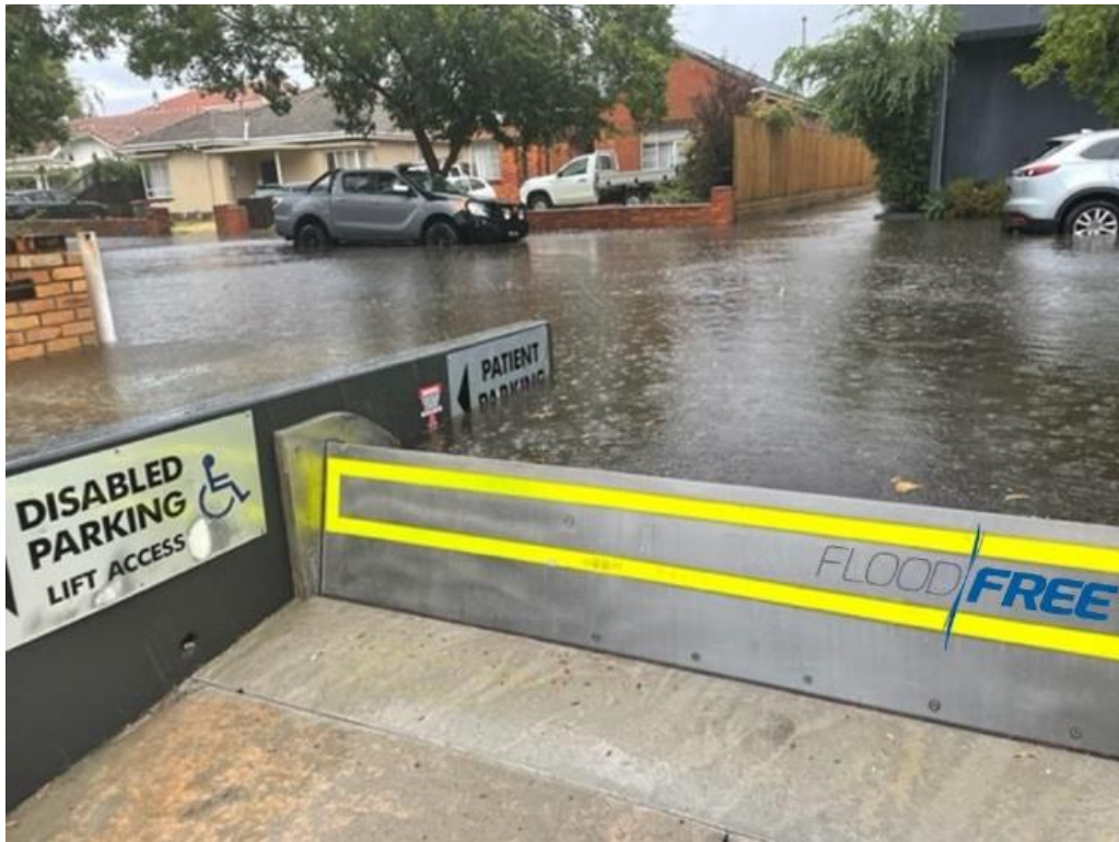
Slika 11 Podizna vodena barijera [12]
