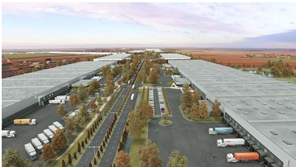
Slika 1 Izgradnja kompleksa e-Valley [1]
