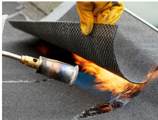
Slika 9.1.1. Varenje bitumenske trake
