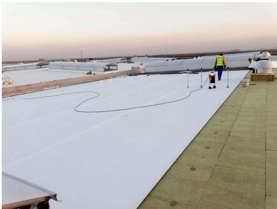
Slika 9.3.2. Polaganje TPO folija na ravni krov
