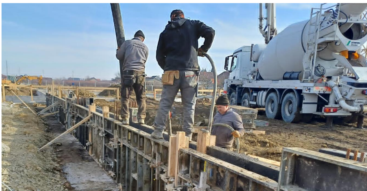
Slika 18. - Betoniranje AB nadtemeljnih greda
