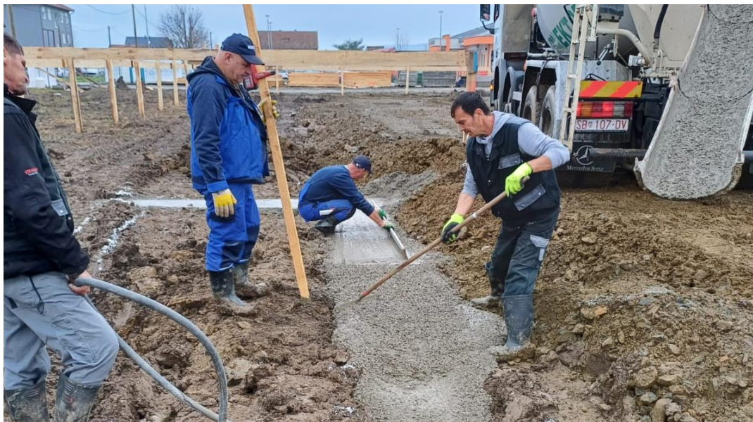
Slika 17. - Betoniranje temeljnih traka
