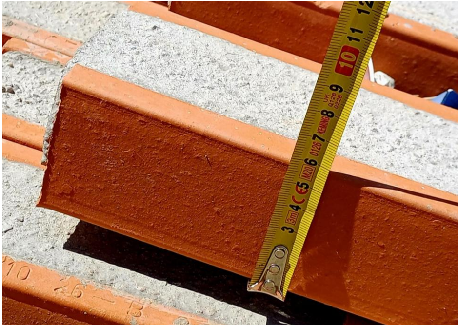
Slika 30. - AB montažni nadvoj
