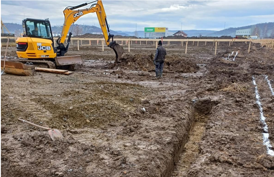
Slika 13. - Iskop za temeljne trake rovokopačem
