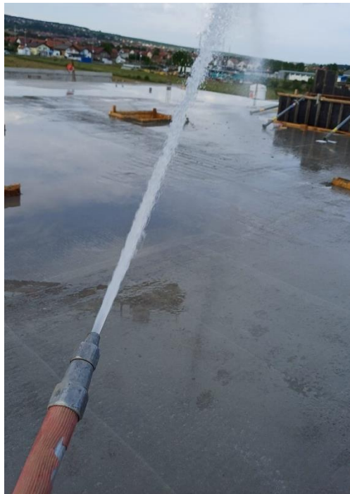
Slika 22. - Njegovanje betona sa laganim površinskim prskanjem vode
