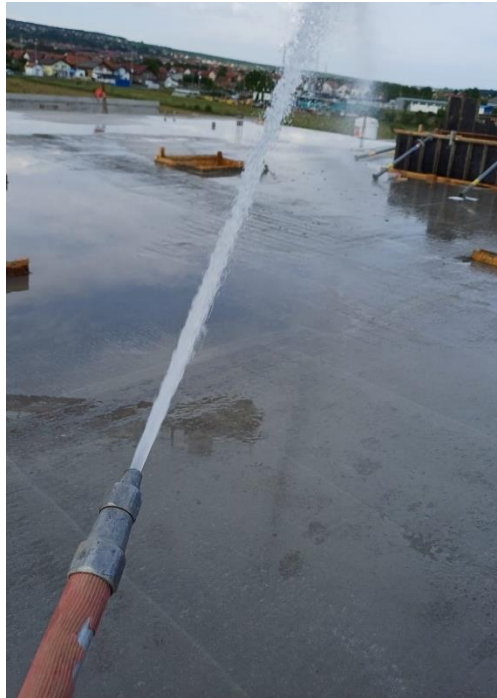
Slika 22. - Njegovanje betona sa laganim površinskim prskanjem vode
