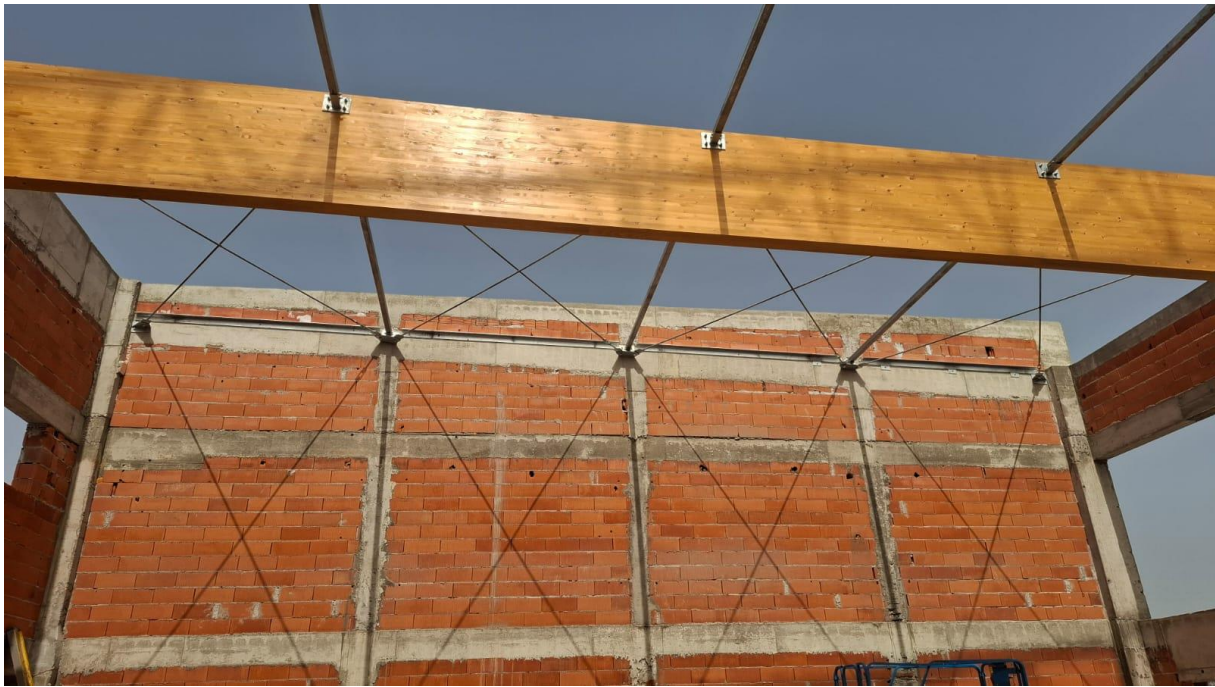
Slika 33. - Postavljeni LLD nosači
