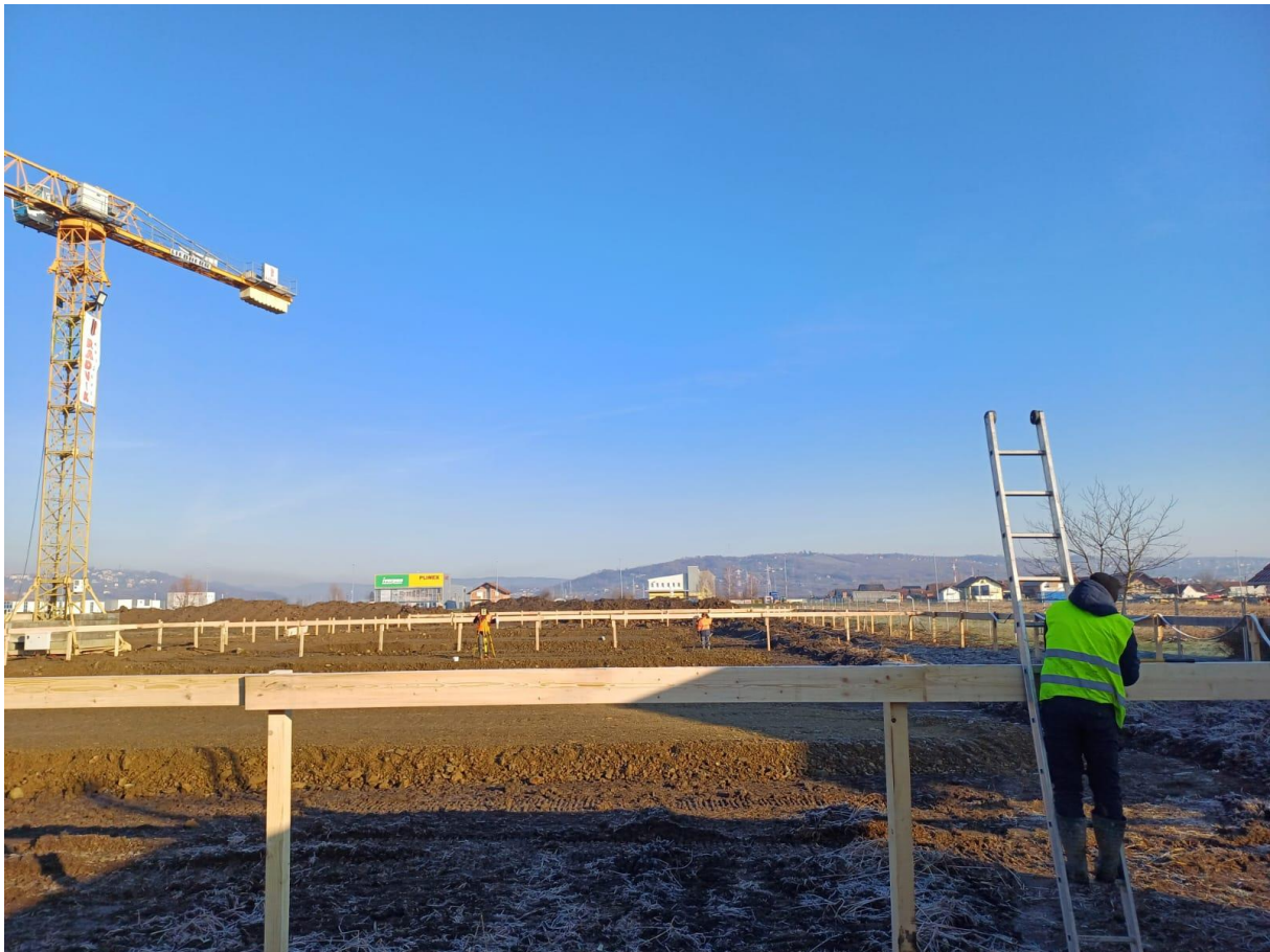
Slika 10. - Nanosna skela i geodetsko označavanje osi zgrade
