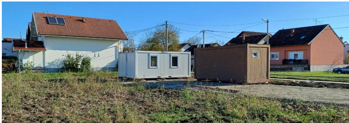
Slika 8. - Postavljanje građevinskih kontejnera
