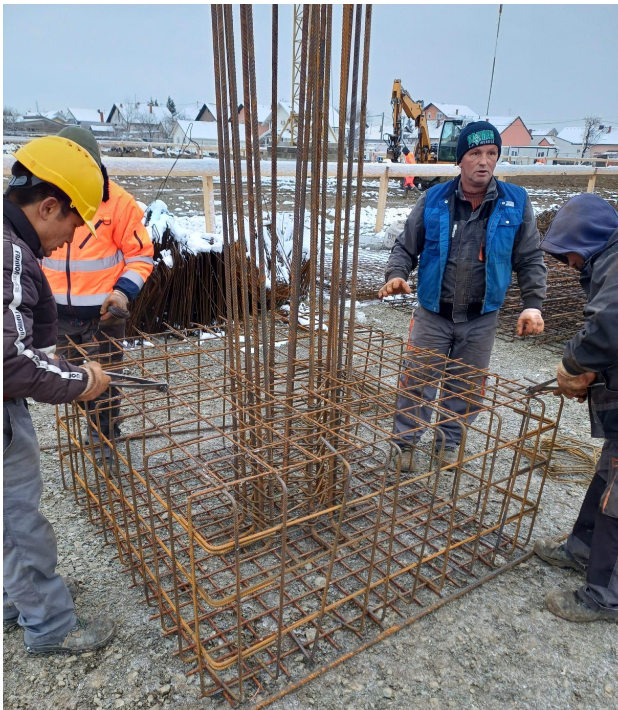
Slika 24. - Vezivanje armature temeljne stope
