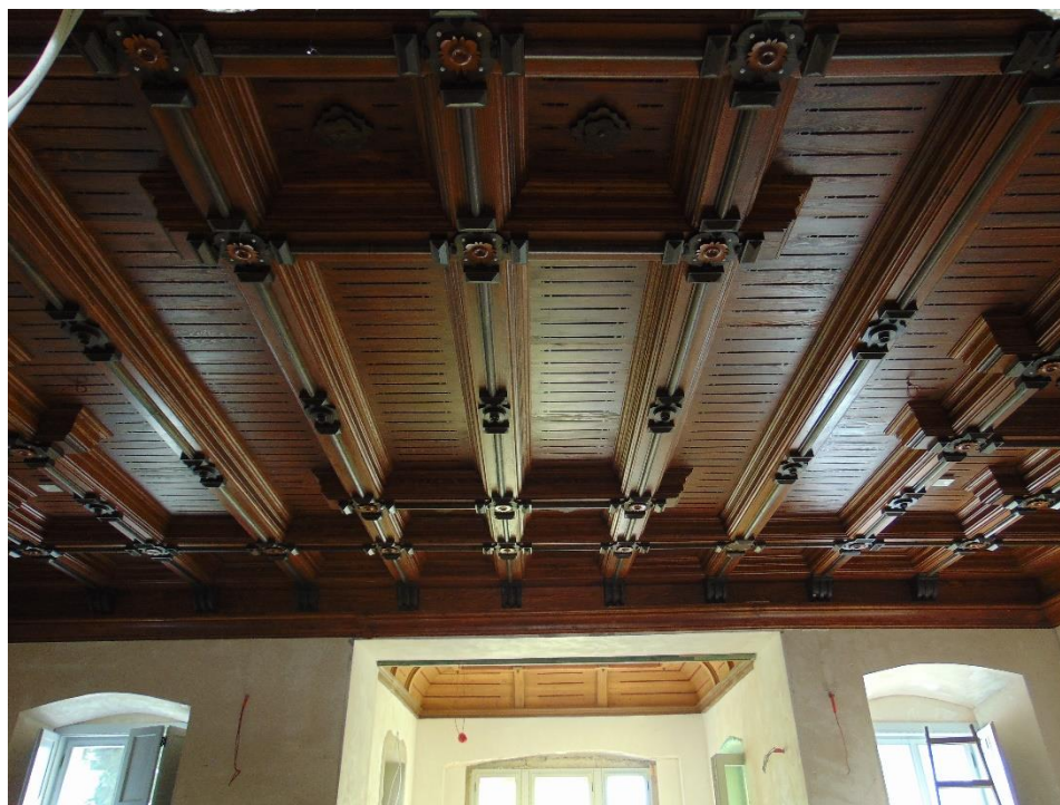
Slika 16. Strop u jednoj od prostorija dvorca Opeka
