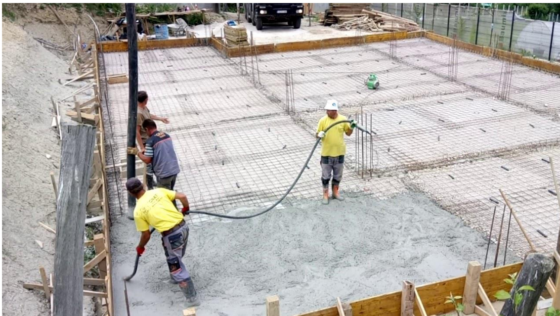
Slika 3.2.1 Prikaz primjera betoniranja AB ploče stambenog objekta Poljine u Sarajevu
