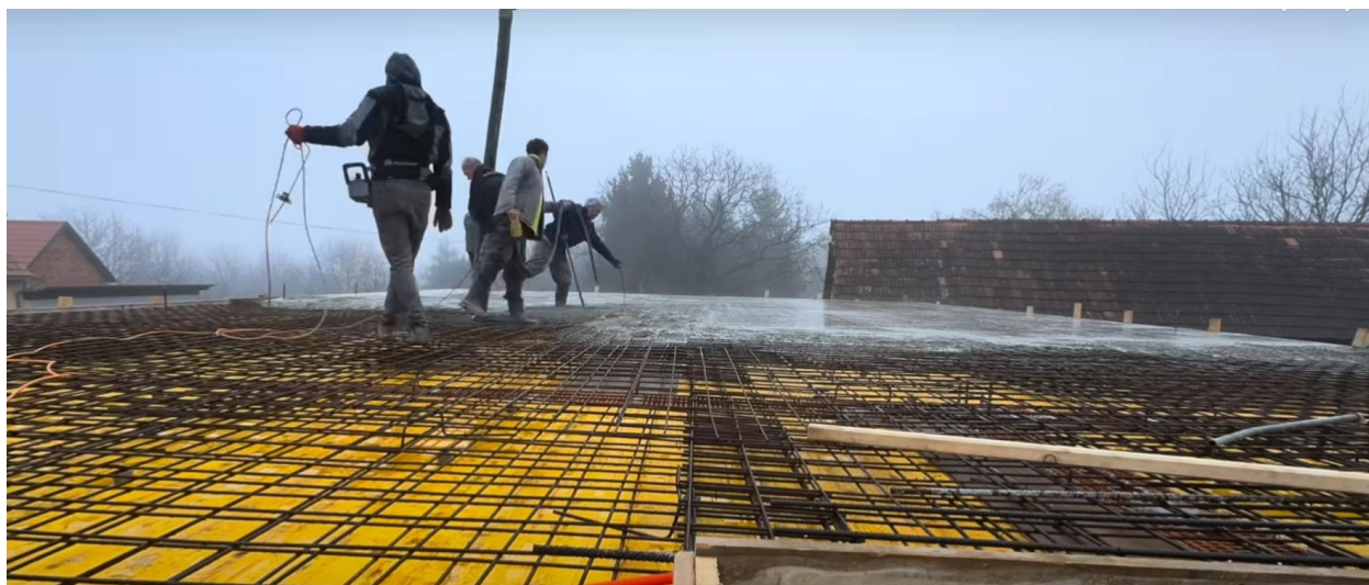
Slika 3.2.3 Prikaz primjera betoniranja AB međukatne ploče
