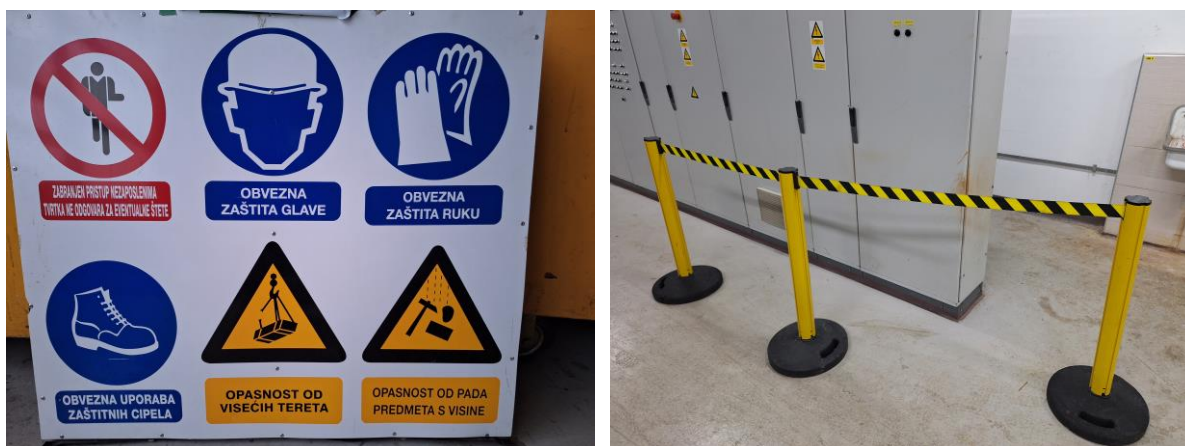
Slika 3.9 Znak upozorenja i stupići s trakom upozorenja
